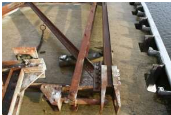
Obr.4 Kotevní čep slupice hor.hrazení
