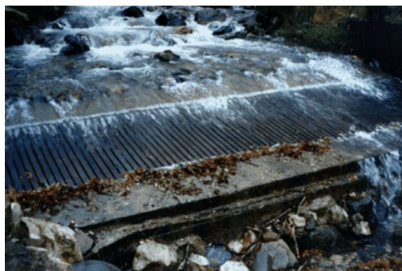
obr. 41 - Klasický dnový odběr
