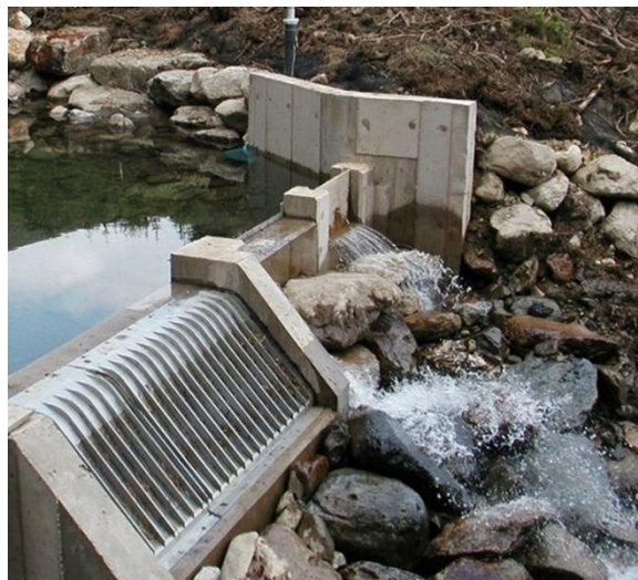
obr. 42 - Dnový odběr "Coanda"
