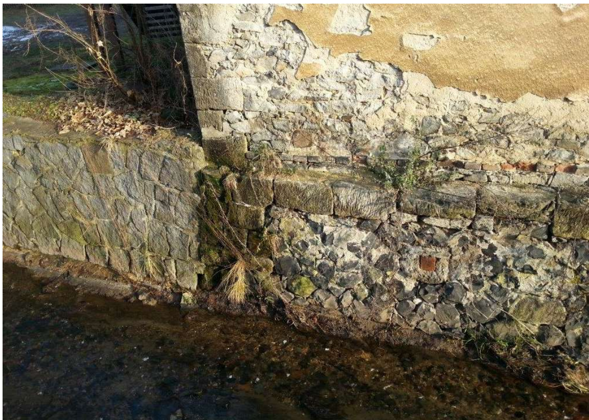
Foto 4 Špatný stavební stav obvodové zdi Hostince U Slunce v řezu PF 06, převzato z c)
