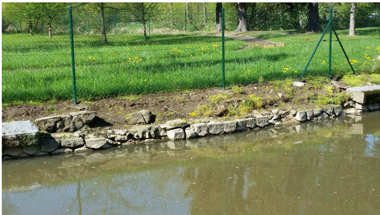
Obr.4 Porušená zeď – levý břeh
