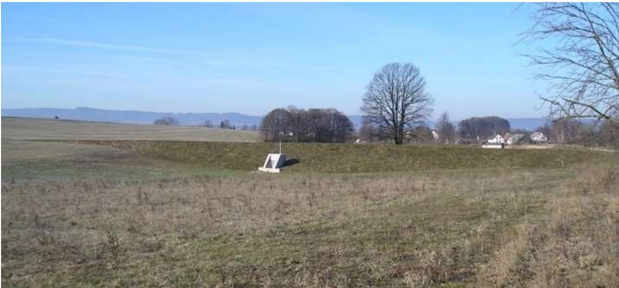
Obr. č. 70: Příklad realizace suché nádrže
