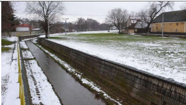
Obr. č. 51 Nepřiměřená úprava koryta (kanalizování) potoka v Neprobylicích. Typická lokalita pro intravilánové přírodě blízké rozvolnění koryta.
