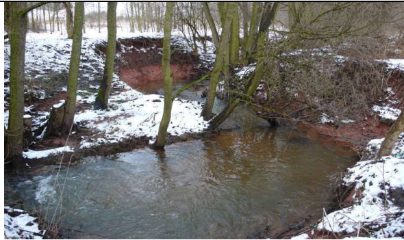
Obr. č. 48 Bakovský potok pod Pozdní byl kdysi poškozen nevhodnými úpravami. Ztráta stability se projevuje výraznou stranovou i hloubkovou erozí v málo odolných zeminách.
