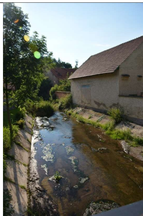
Obr. č. 37 Zlonický potok nad Zlonicemi – KM 10,3 s nevhodnou „betonovou úpravou“. Vhodnost revitalizace – zároveň jde o lokalitu vhodnou pro realizaci suché nádrže
