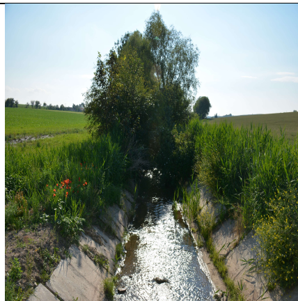
Obr. č. 37 Zlonický potok nad Zlonicemi – KM 10,3 s nevhodnou „betonovou úpravou“. Vhodnost revitalizace – zároveň jde o lokalitu vhodnou pro realizaci suché nádrže
