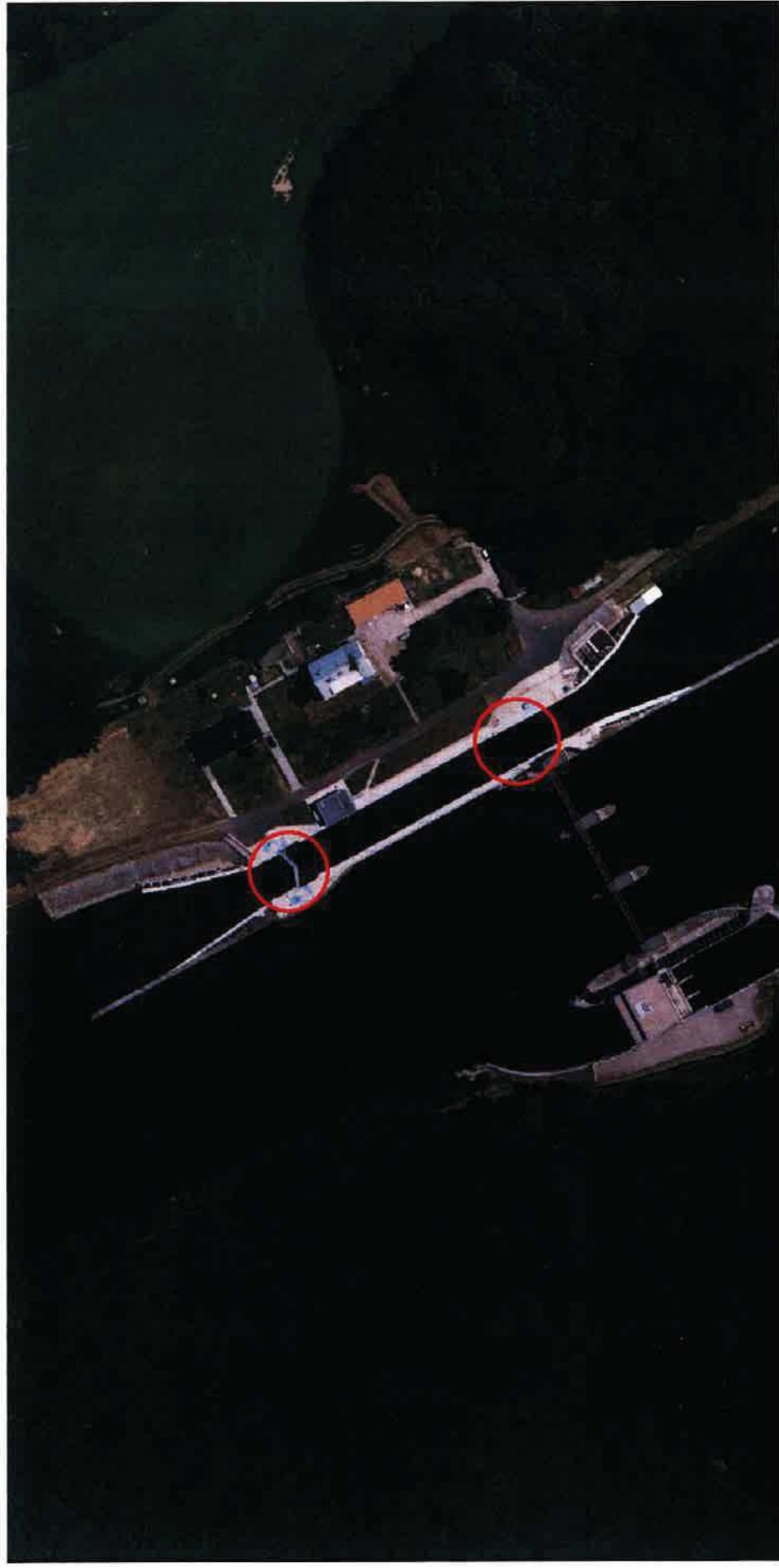
Sřřední Labe, potápěčské práce při osazení provizorního hrazení PK Velký Osek
