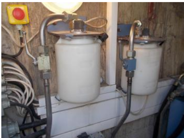
Jímky pro odsazení průsaků do hydromotoru (sousedních válců jednoho pilíře)
