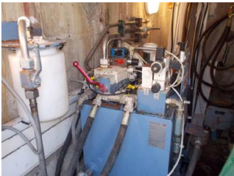
Pohled na stávající agregát v kobce pilře.
