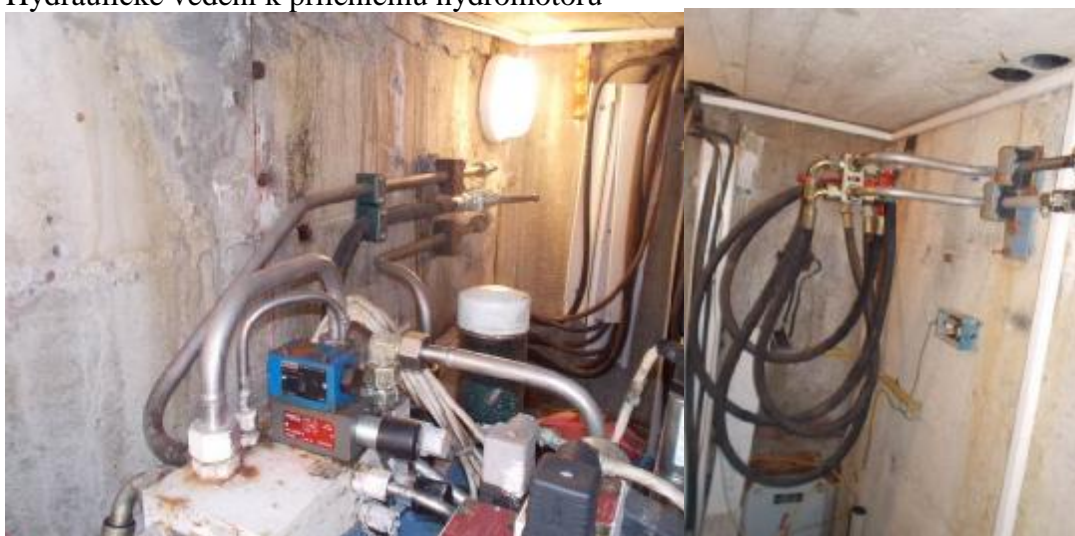
Hydraulické vedení k protilehlému hydromotoru (od agregátu a v protilehlém pilří)
