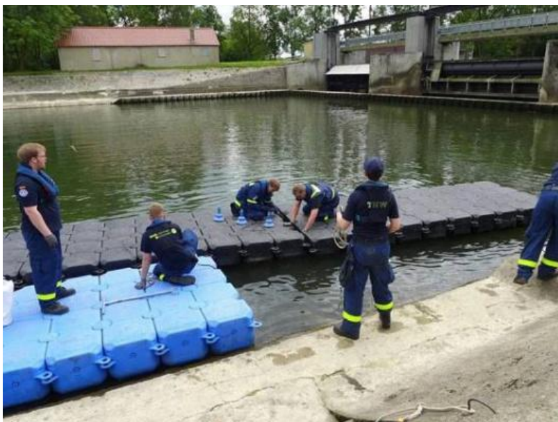
Ukázka využitelné provizorní plovoucí desky "JetFloat"
