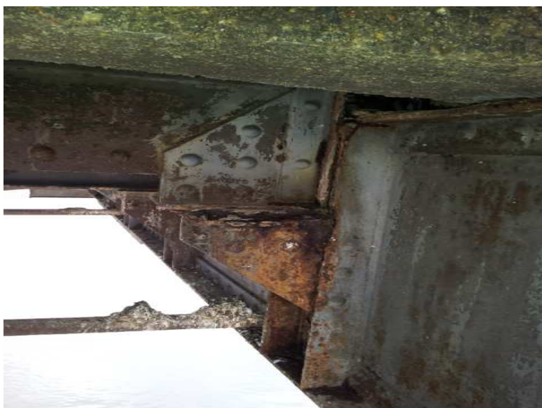
4. pole, 6. příhrada, povodní strana – stav uložení podélníku na příčnick v místě kloubu
