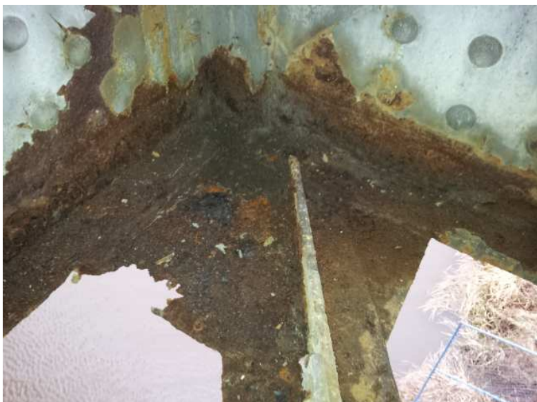
1. pole, 3. příhrada, návodní strana – koroze styčnickového plechu a profilů diagonál vodorovného ztužení
