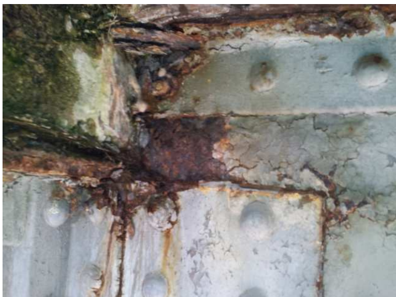
2. pole, 9. příhrada, - koroze styku příčníku a podélníku pod mostovkou
