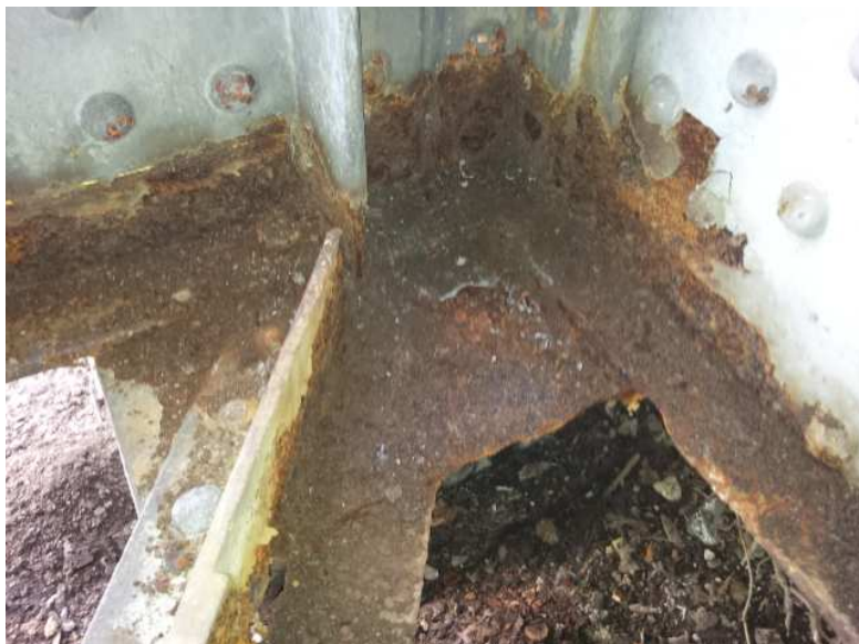
LB opěra, 1. pole, 1. příhrada, návodní strana – koroze styčnickového plechu a profilů diagonál vodorovného ztužení
