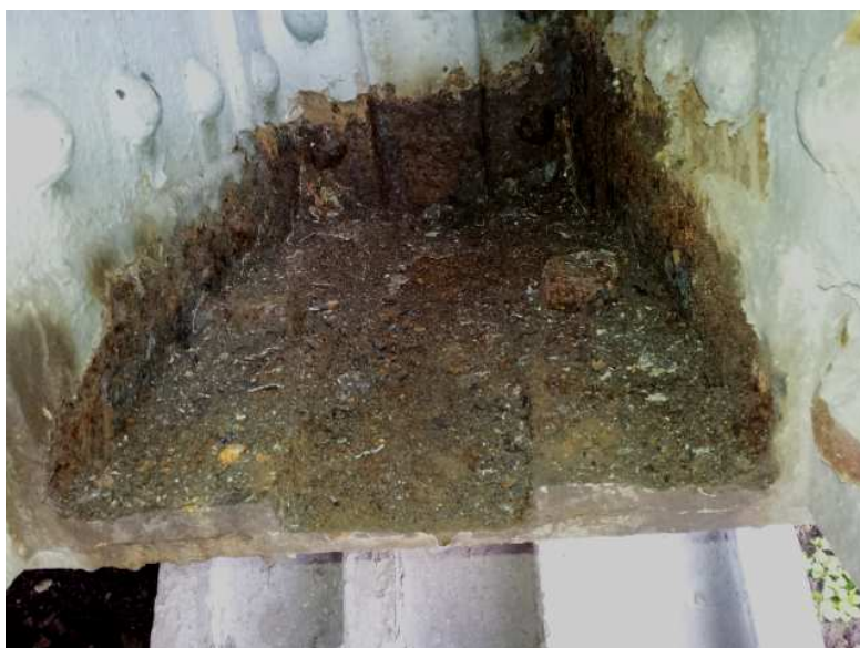
LB opěra, 1. pole, 1. příhrada, povodní strana – koroze spodního plechu a profilů příčnicku nad ložiskem
