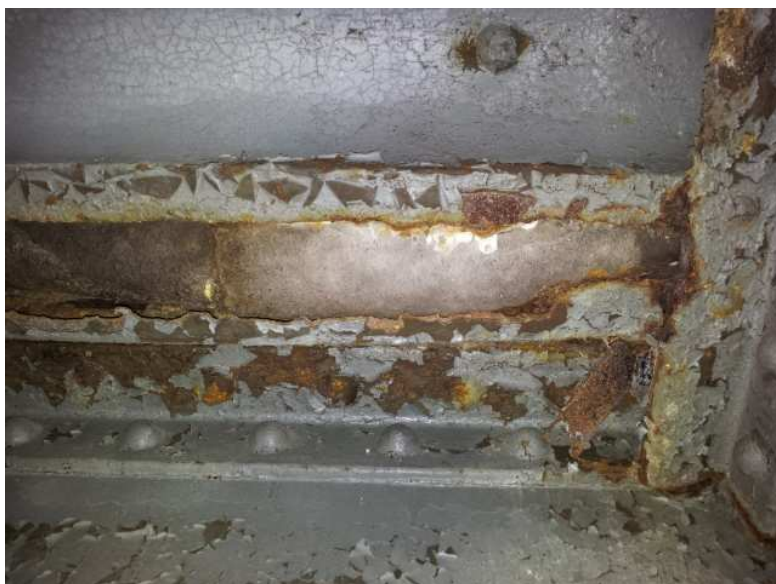
3. pole, 8. příhrada, povodní strana - koroze podlažnic
