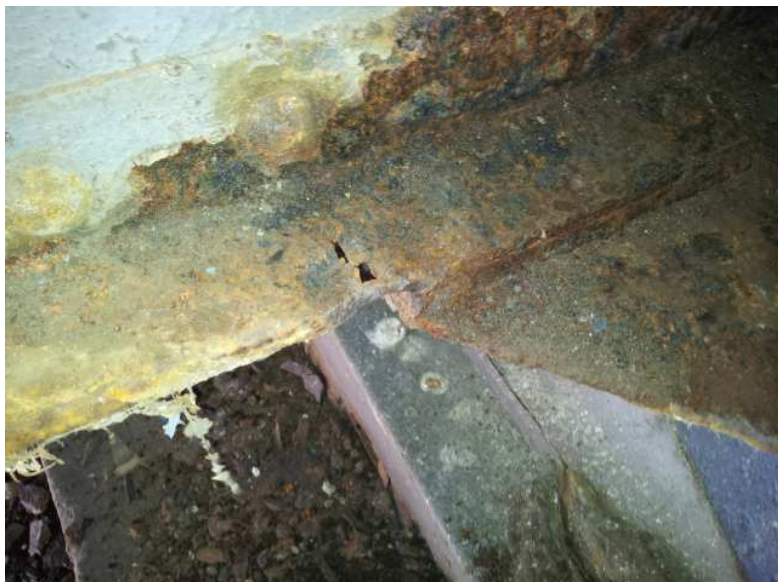
1. pole, 21. příhrada, povodní strana – korozní oslabení spodní příruby příčnicku nad ložiskem
