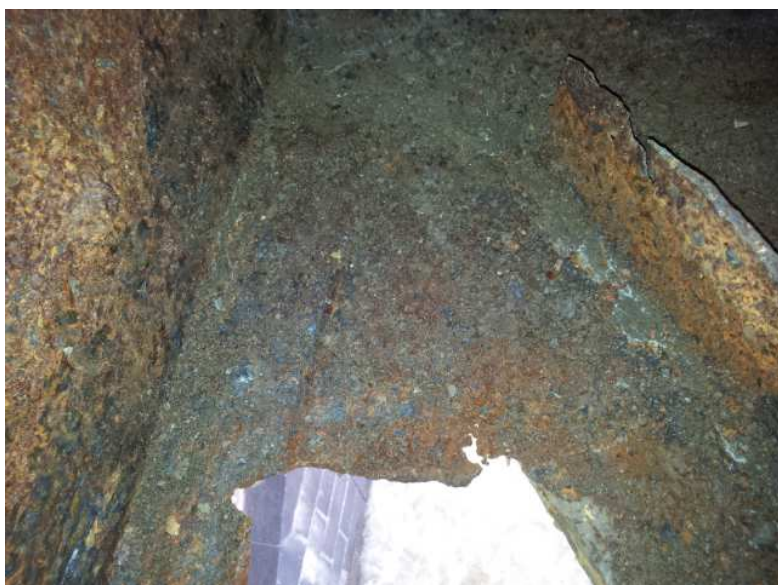
2. pole, 9. příhrada, povodní strana – koroze styčnickového plechu a profilů diagonál vodorovného ztužení
