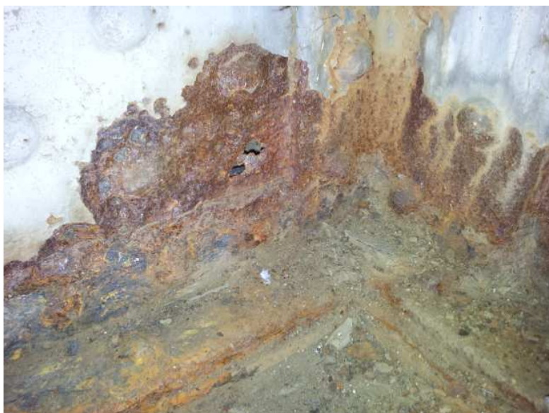
4. pole, 3. příhrada, povodní strana – korozní oslabení plechů příčnicku u styčnicku
