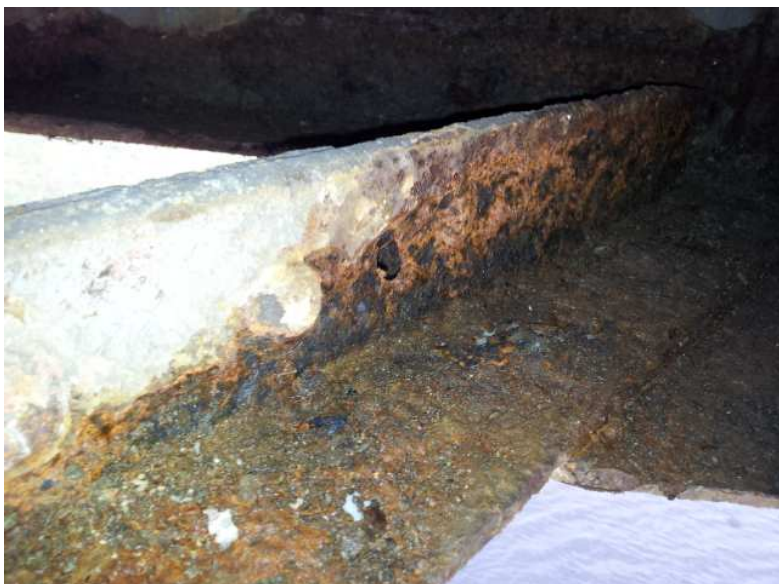
1. pole, 3. příhrada, povodní strana - koroze diagonály vodorovného ztužení
