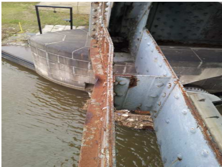
2. pole, 15. příhrada, návodní strana – deformace spodního pasu hlavního nosníku
