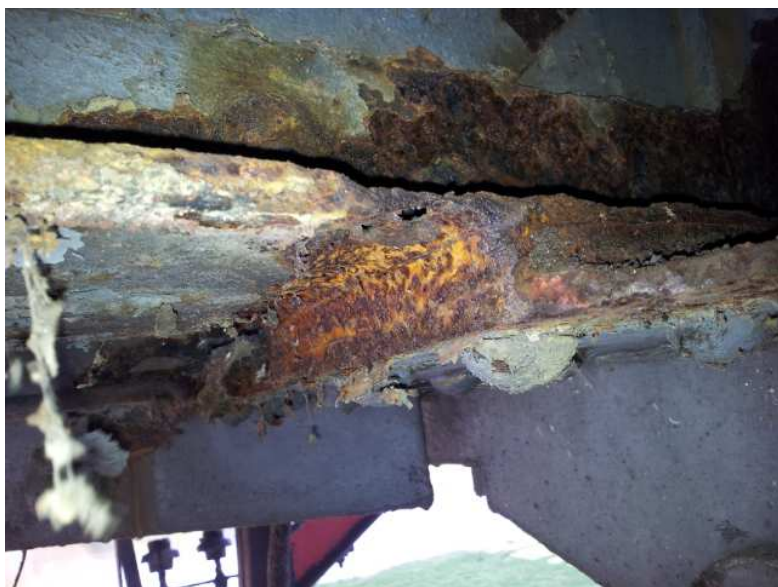
1. pole, 21. příhrada, povodní strana – korozní oslabení spodní příruby příčnicku nad ložiskem z pohledu
