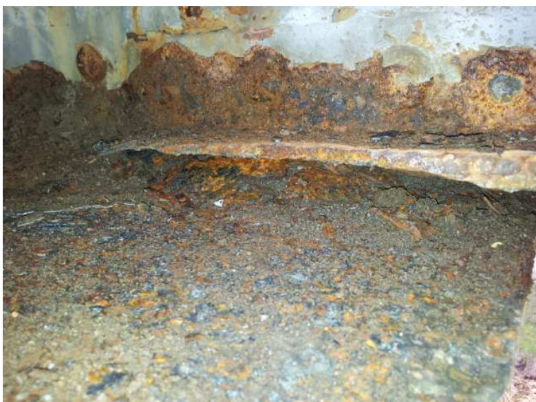
1. pole, 5. příhrada, návodní strana – korozní oslabení spodní příruby příčnicku
