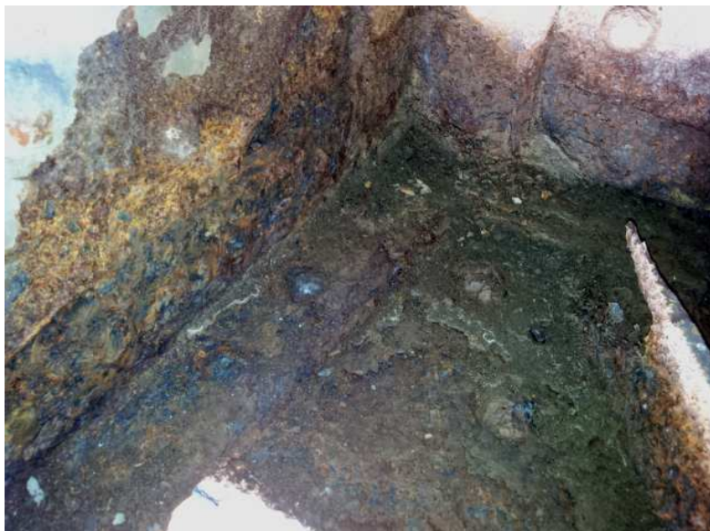
2. pole, 3. příhrada, povodní strana – koroze styčnickového plechu a profilů diagonál vodorovného ztužení
