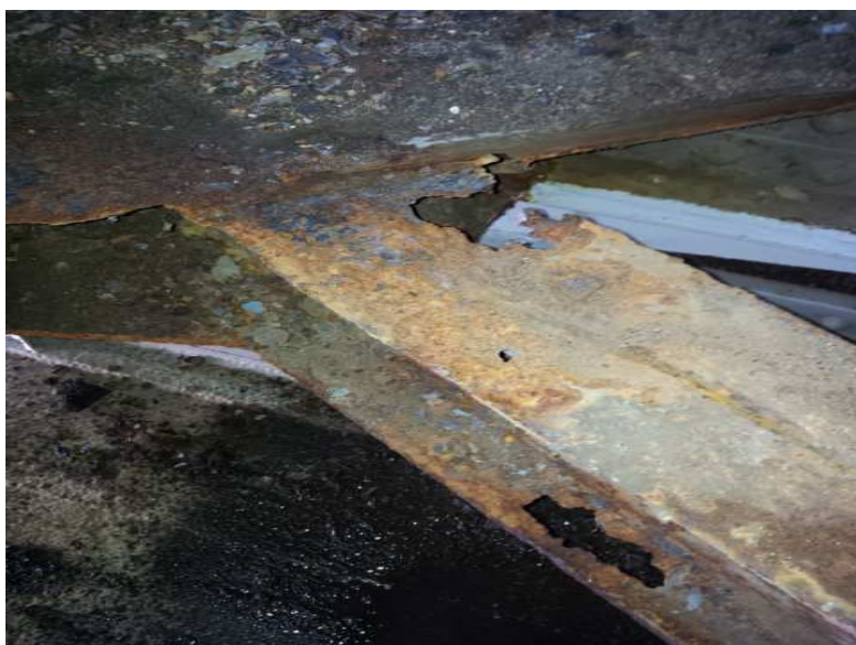
3. pole, 9. příhrada, povodní strana – koroze diagonály vodorovného ztužení
