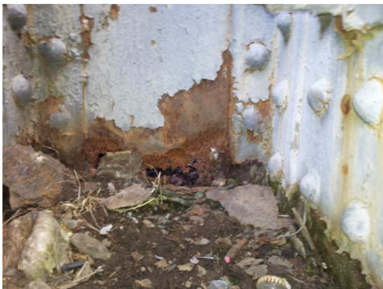
3. pole, 19. příhrada, návodní strana – korozní oslabení plechu svislé stojky ve styčnicku
