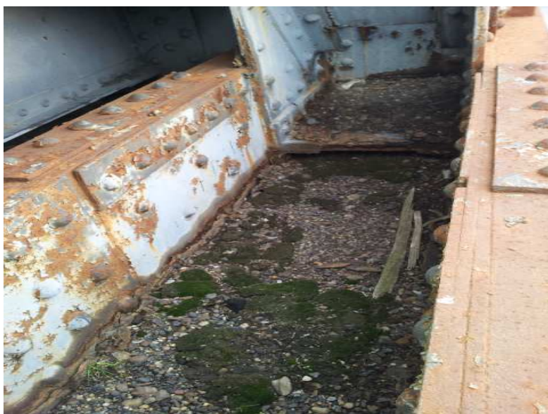
3. pole, návodní strana – plná „vana“ nečistot ve spodním pasu hlavního nosníku
