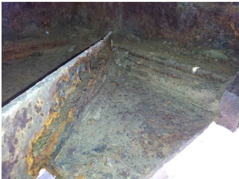
4. pole, 3. příhrada, povodní strana – koroze styčnickového plechu a profilů diagonál vodorovného ztužení
