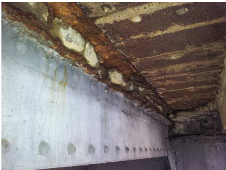
LB opěra, 1. pole, 1. příhrada - koroze profilu příčnicku v dotyku s mostovkou
