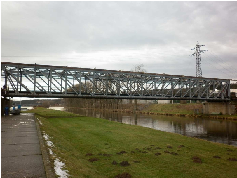
Obr. 3.8 – Pohled na nosnou konstrukci pole 1 – rozpětí 62 m
