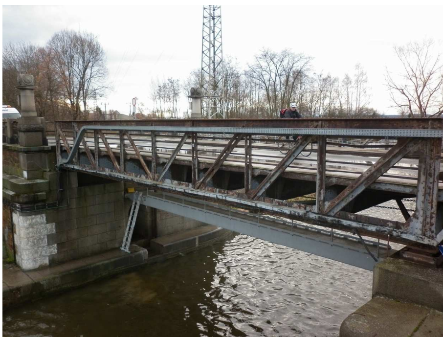
Obr. 3.35 – Pohled na nosnou konstrukci pole 5 – rozpětí 16 m
