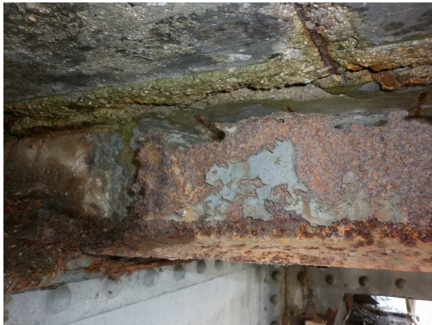
Obr. 3.5 – koroze zcela přerušeny nosník I 140 pod kolejnicí nad opěrou OP1
