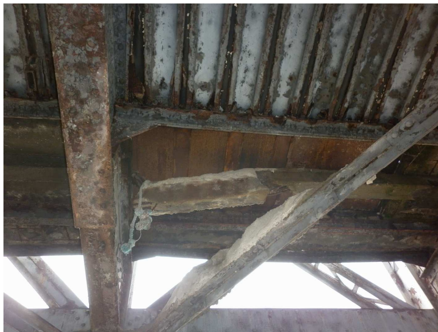
Obr. 3.6 – betonový trám pod chodníkovou částí konzoly je zcela rozpadlý
