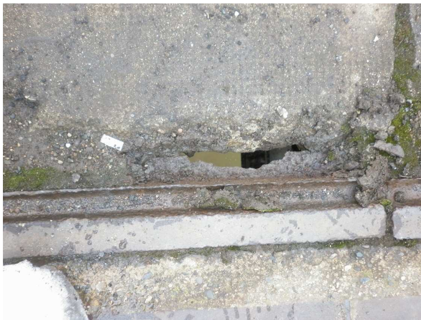
Obr. 3.7 – rozpadlá ŽB deska návodního (pravého chodníku)
