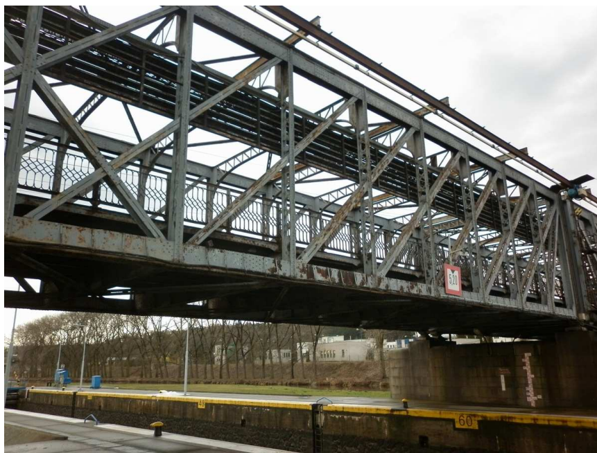
Obr. 3.15 – Pohled na nosnou konstrukci pole 1 – rozpětí 48 m
