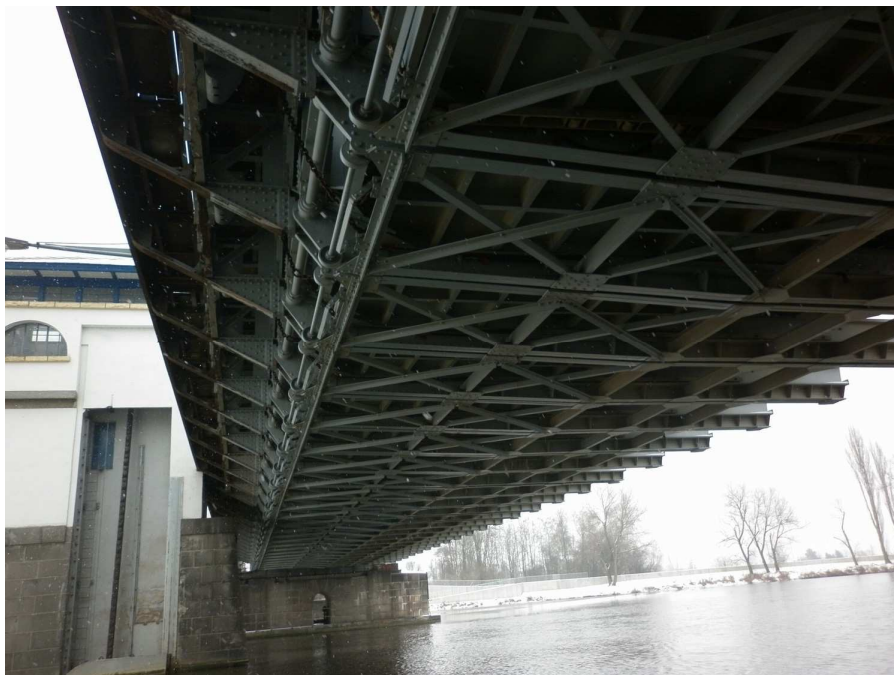
Obr. 3.21 – Spodní líc nosné konstrukce s podvěšenou konstrukcí systému provizorního hrazení
