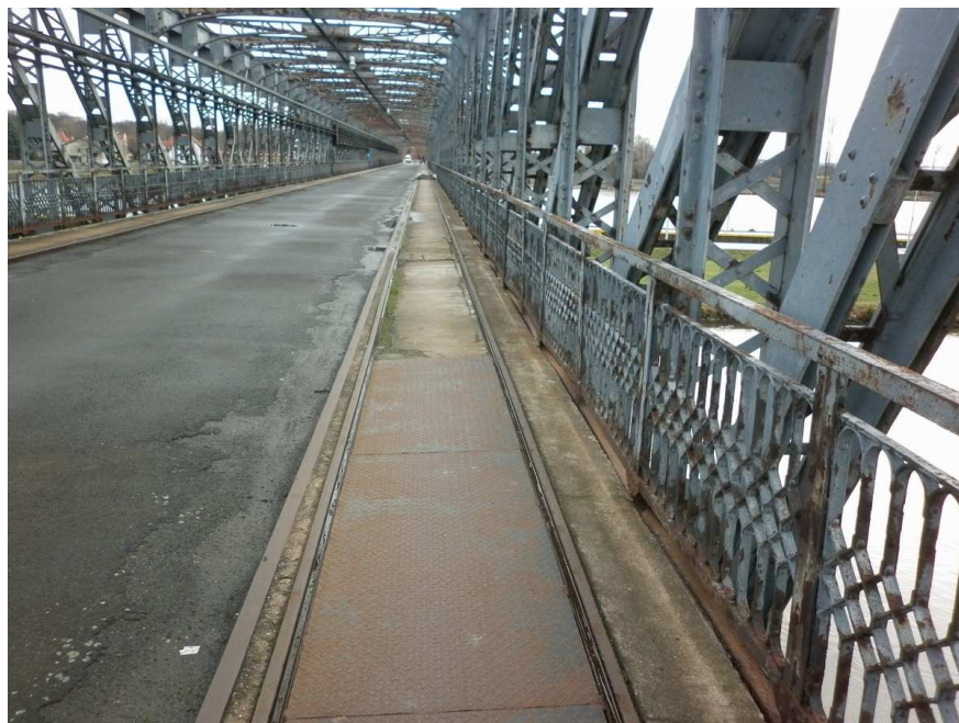
Obr. 3.2 – Kolejová dráha na návodní straně
