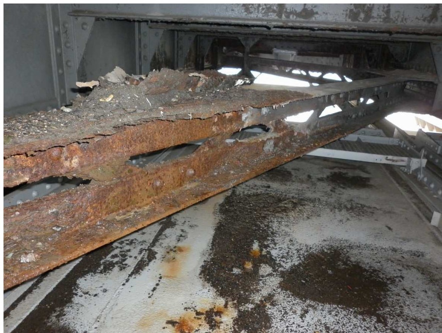
Obr. 3.34 - koroze silně oslabený prvek spodního zavětrování
