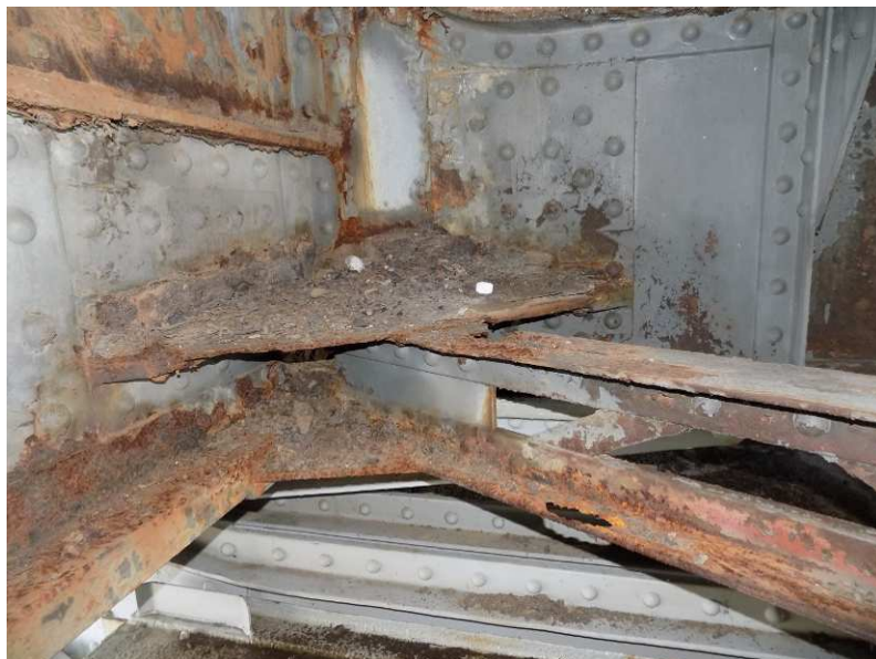
Obr. 2.52 – sonda 16 , pohled na přípoj styčnickového plechu a dolního vodorovného ztužení
