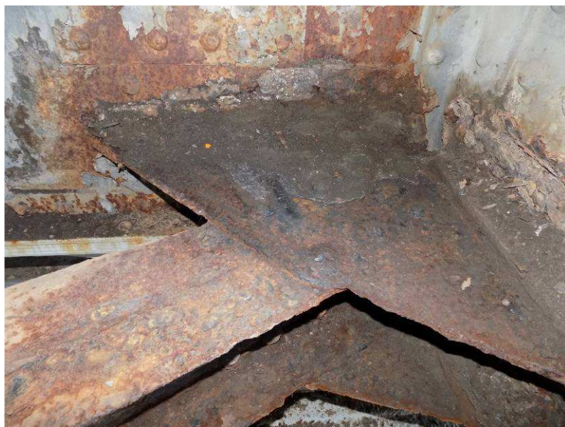
Obr. 2.54 – sonda 17 , pohled na přípoj styčnickového plechu a dolního vodorovného ztužení, silná koroze
