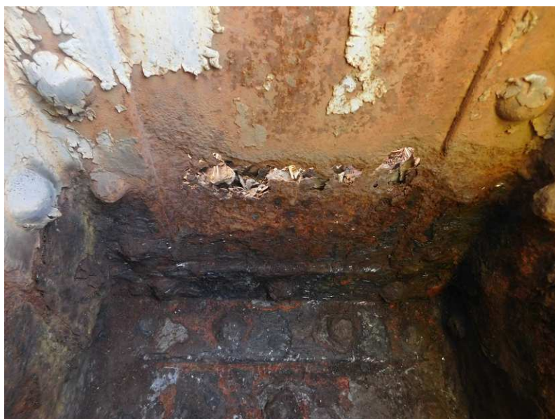
Obr. 2.29 – detail sondy 4, prokorodování plechu svislice, silné korozní oslabení nosných úhelníků svislice
