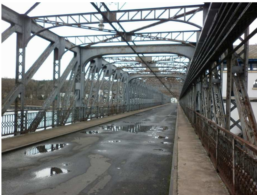
Obr. 2.2 – šířkové uspořádání na mostovce v poli 3
