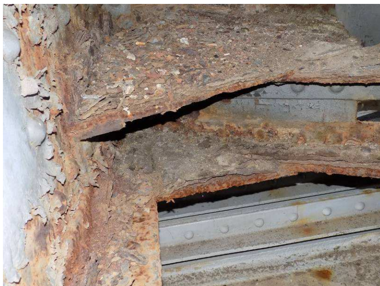
Obr. 2.16 – typický stav styčnicků dolního vodorovného ztužení, příčnicku a spodního hlavního nosníku
