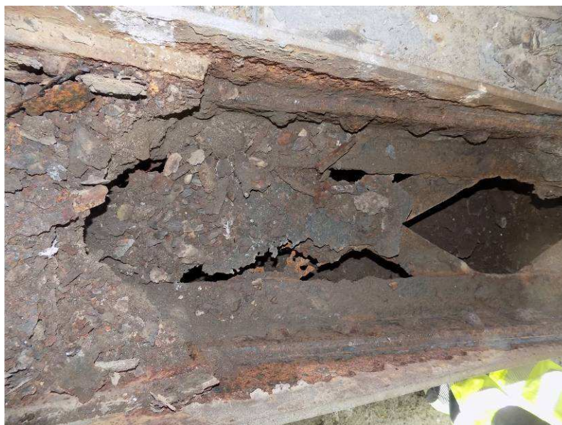
Obr. 2.47 – detail sondy 13, detail silné koroze
