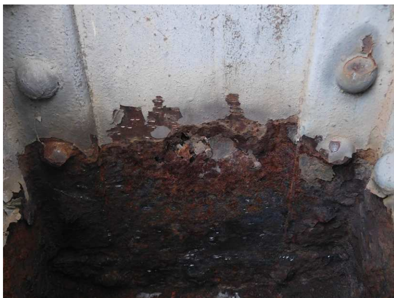
Obr. 2.41 – detail sondy 10, prokorodování plechu svislice, silné korozní oslabení nosných úhelníků svislice
