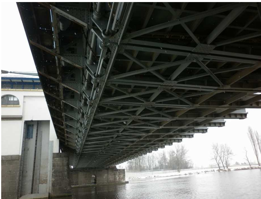
Obr. 2.1 – spodní líc nosné konstrukce s podvěšenou konstrukcí systému provizorního hrazení
