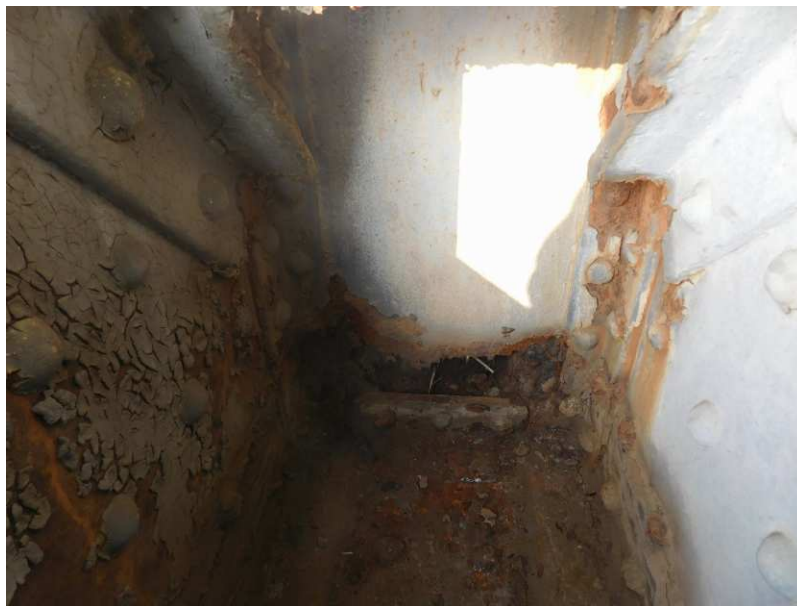
Obr. 2.22 – sonda 1 , styk svislice a spodního pasu, 1. svislice pravého pasu nosné konstrukce
