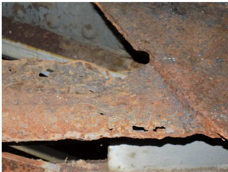
Obr. 2.57 – sonda 18 , detail velmi silné koroze horní pásnice dolního vodorovného ztužení
