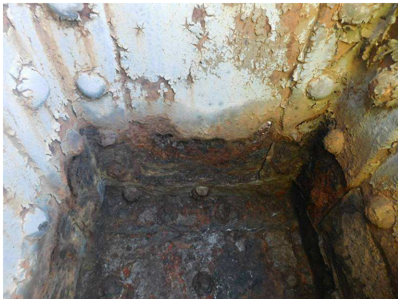
Obr. 2.31 – detail sondy 5, prokorodování plechu svislice, silné korozní oslabení nosných úhelníků svislice
