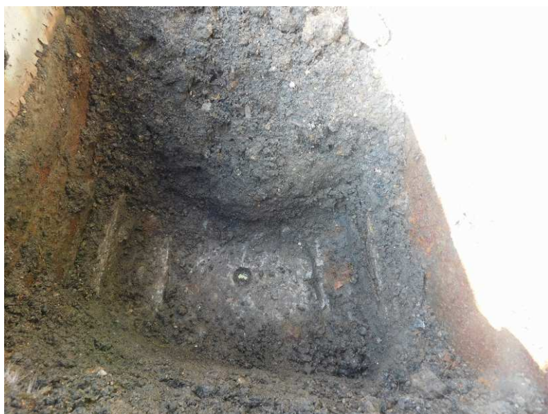
Obr. 2.33 – detail sondy 6, spodní pás je pod vrstvami nečistot v relativně uspokojivém stavu
