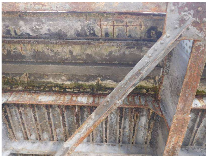
Obr. 2.73 – spodní líc pravé konzoly v poli 2 – typický stav, silné zatékání a degradace betonového chodníku
