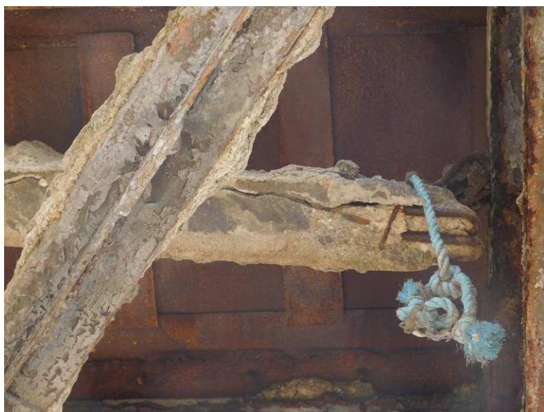
Obr. 2.72 – spodní líc pravé konzoly v poli 2 – lokální závada – detail přerušení betonové trámy pravého chodníku
