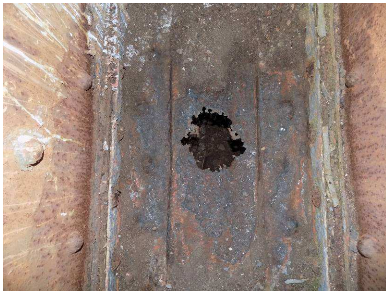
Obr. 2.44 – sonda 12 , spodní hlavní pás, množství nečistot, silná koroze plechu spodního hlavního pasu
