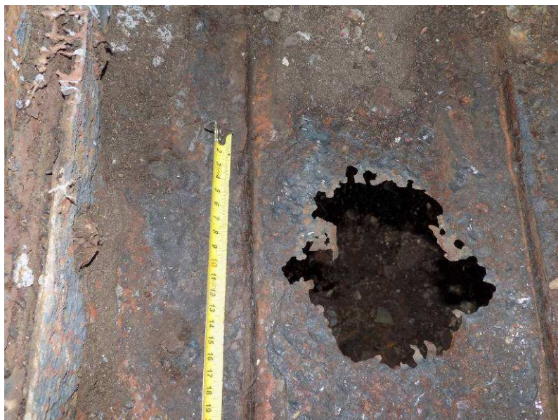
Obr. 2.45 – detail sondy 12, detail korozního oslabení v místě odvodňovacího otvoru
