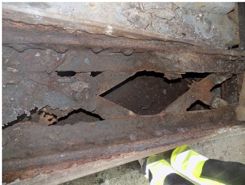
Obr. 2.46 – sonda 13 , kotevní prvek uložení nosné konstrukce na pilíři P3, silná koroze, překorodování výztuh z plechů
