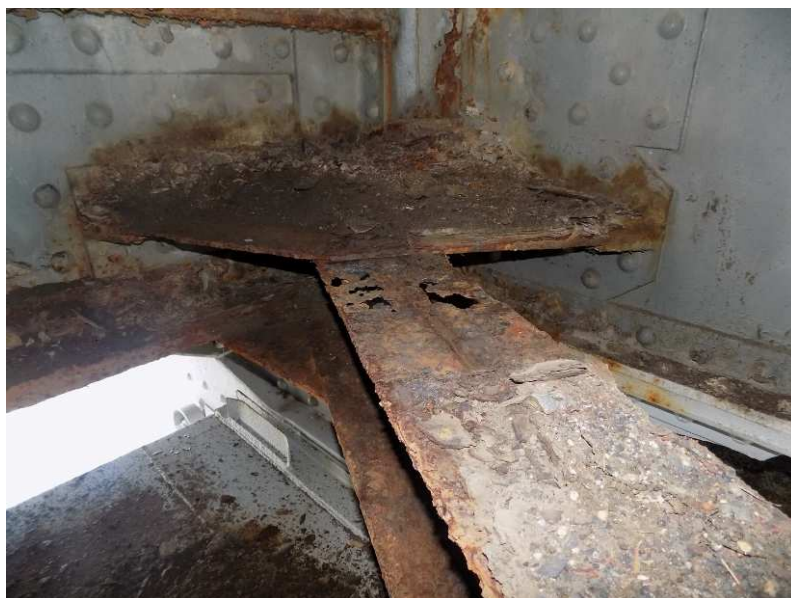
Obr. 2.50 – sonda 15 , pohled na přípoj styčnickového plechu a dolního vodorovného ztužení
