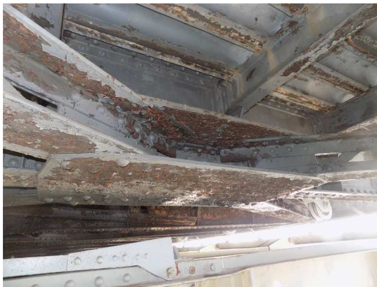
Obr. 2.15 – styčnickový plech na styku vodorovné dolní ztužení a příčnick v podélné ose mostovky
