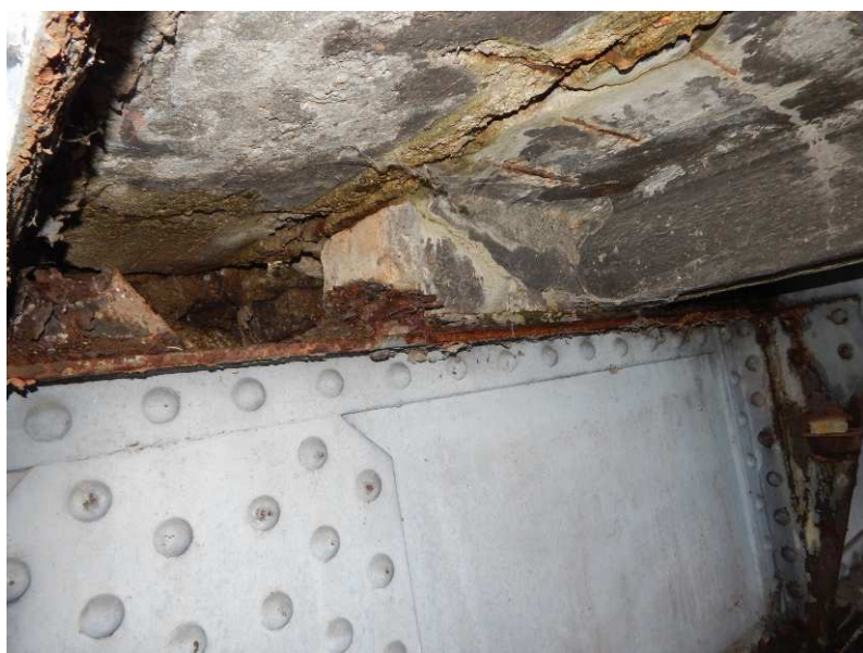
Obr. 2.68 – spodní líc pravé konzoly v poli 1 nad opěrou OP1 – překorodovaný chybějící podélný ocelový nosník I140 pod kolejnicí dráhy
