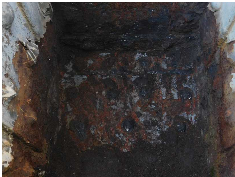
Obr. 2.40 – sonda 10 , styk svislice a dolního pasu, 26. svislice levého spodního pasu nosné konstrukce
