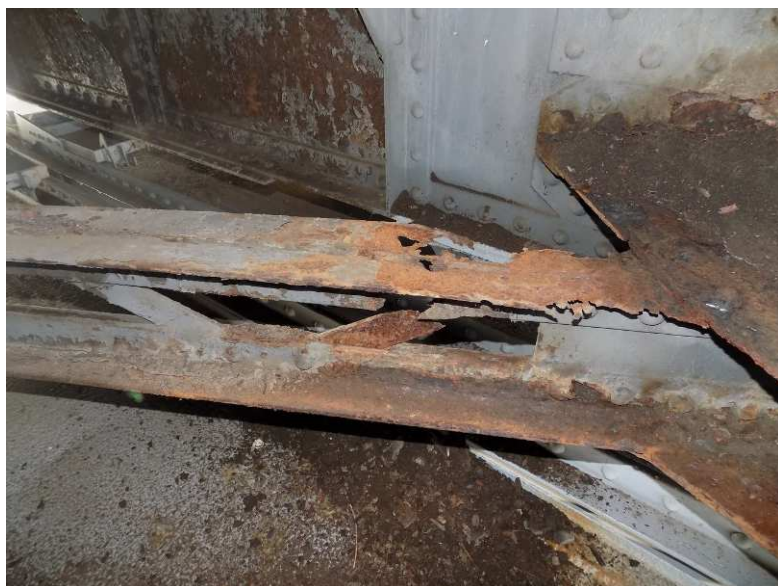
Obr. 2.19 – dolní vodorovné ztužení je v místě připojení na styčník s dolním hlavním nosníkem zcela překorodavné
