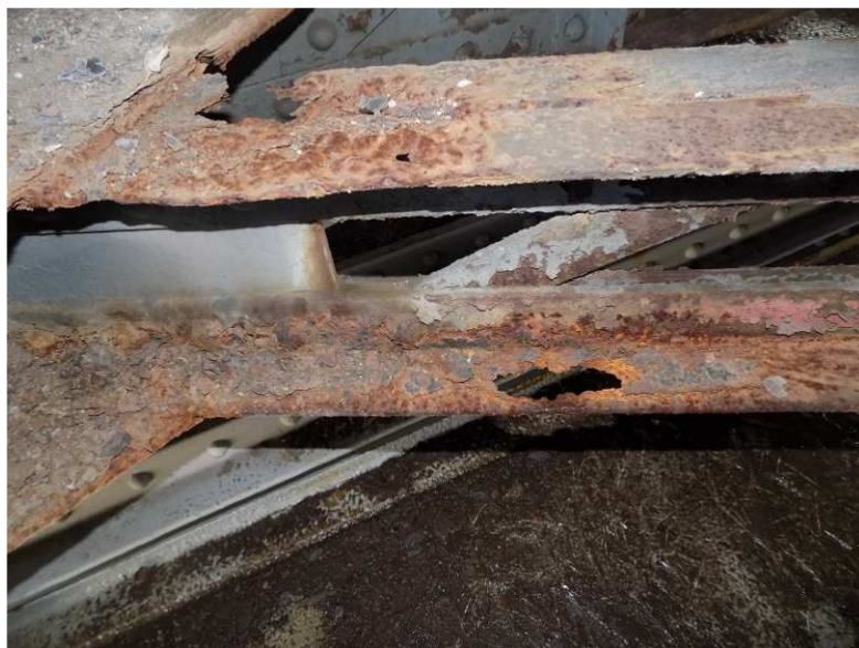
Obr. 2.18 – dolní vodorovné ztužení je v místě připojení na styčník s dolním hlavním nosníkem zcela překorodavné
