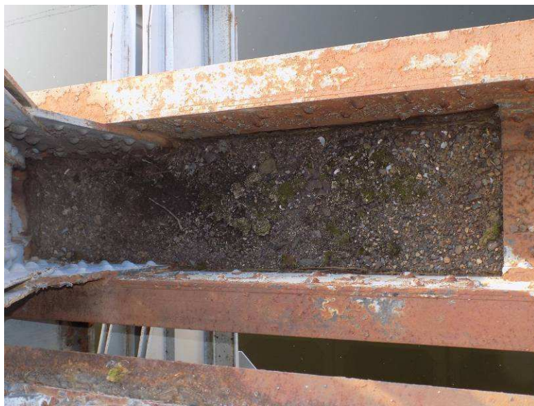
Obr. 2.12 – spodní hlavní nosníky, částečně uzavřený profil je plný nečistot, odvodňovací otvory ucpány, koroze prvků dolního hlavního nosníku do 10% průřezové plochy)
