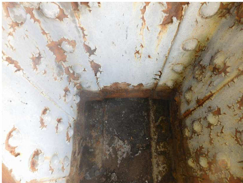
Obr. 2.24 – sonda 2 , styk svislice a spodního pasu, 3. svislice pravého pasu nosné konstrukce
