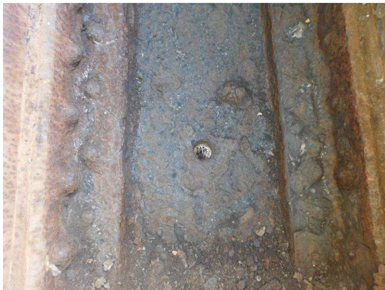
Obr. 2.35 – detail sondy 6, spodní pás s korozním oslabením do 10%
