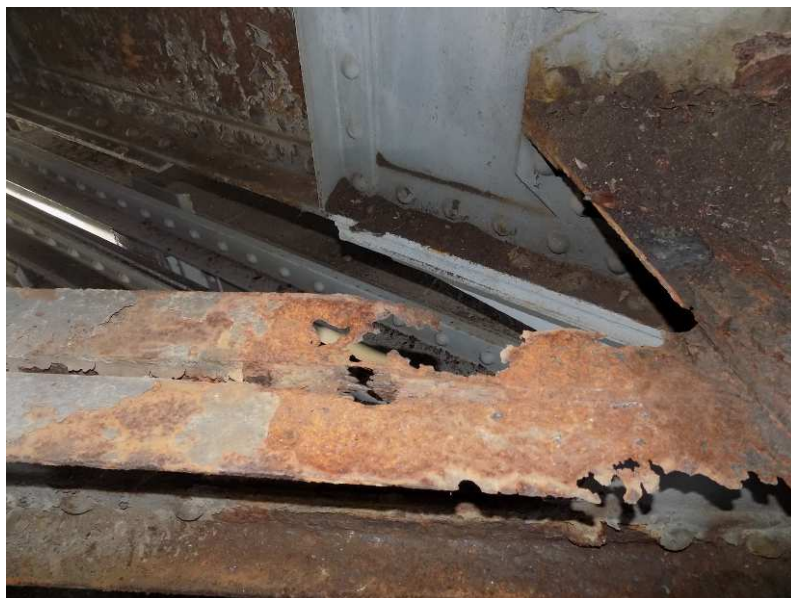
Obr. 2.59– sonda 19 , detail velmi silné koroze horní pásnice dolního vodorovného ztužení
