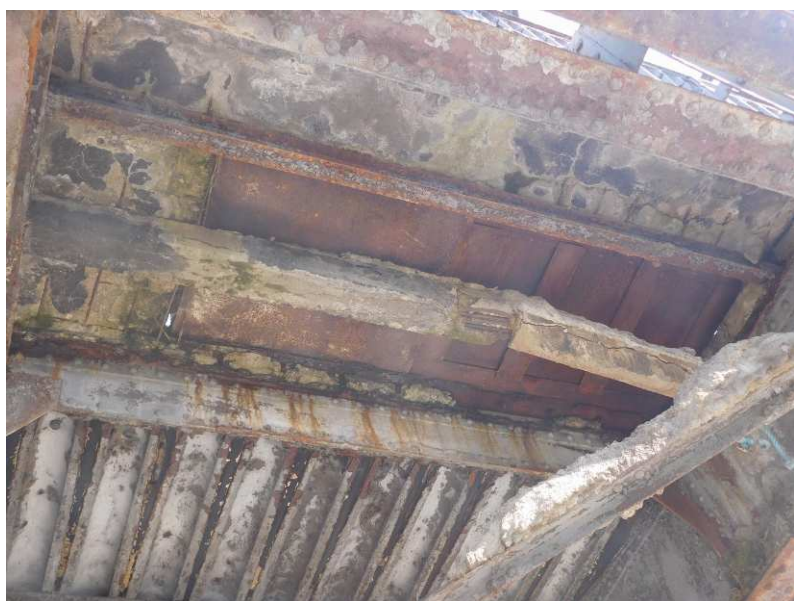
Obr. 2.71 – spodní líc pravé konzoly v poli 2 – lokální závada – přerušení betonové trámy pravého chodníku
