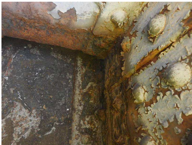
Obr. 2.25 – detail sondy 2, koroze středního plechu svislice, oslabení nosných úhelníků svislice
