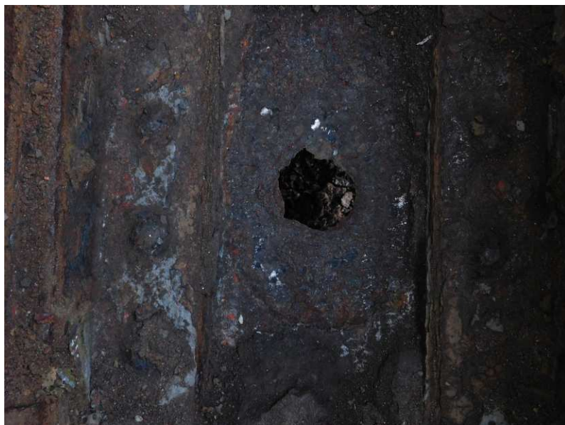
Obr. 2.39 – detail sondy 9, detail korozního oslabení v místě odvodňovacího otvoru
