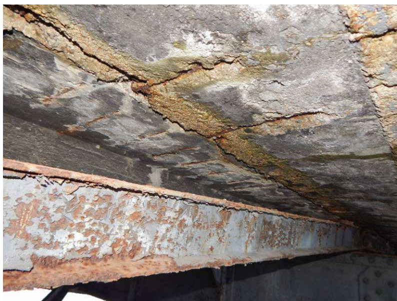
Obr. 2.69 – spodní líc pravé konzoly v poli 1 nad opěrou OP1 – překorodovaný a zkroucený ocelový nosník I140 pod kolejnicí dráhy
