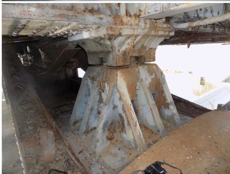
Obr. 2.14 – ložisko na pilíři P3
