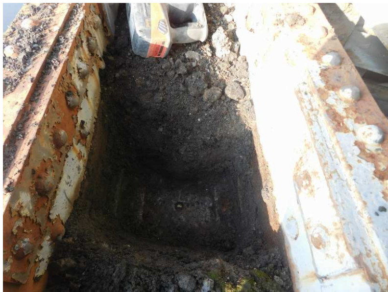
Obr. 2.32 – sonda 6 , spodní hlavní pás, ocelový průřez je zcela zanesený nečistotami do výšky cca 40 cm
