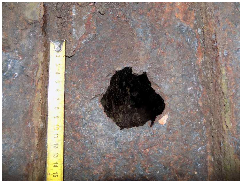
Obr. 2.43 – detail sondy 11, detail korozního oslabení v místě odvodňovacího otvoru
