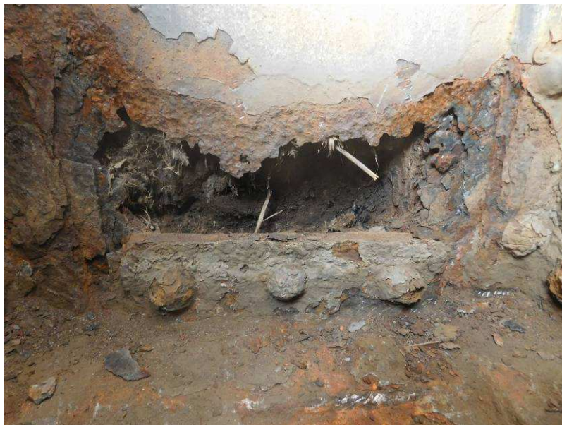
Obr. 2.23 – detail sondy 1, prokorodování plechu svislice, silné korozní oslabení nosných úhelníků svislice
