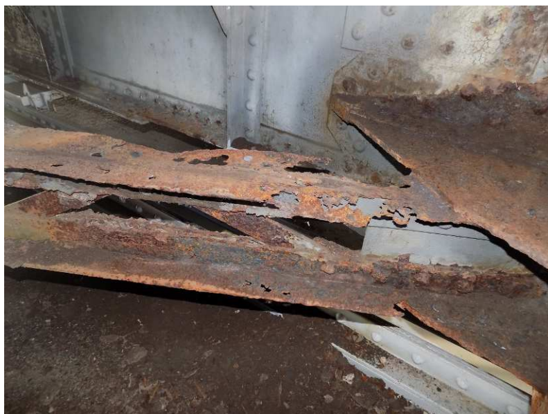
Obr. 2.60 – sonda 20 , pohled na přípoj styčnickového plechu a příčného ztužení, silná koroze
