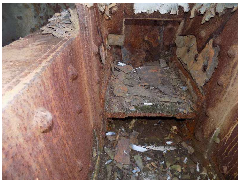
Obr. 2.20 – oslabení dolního hlavního nosníku silnější korozi (oslabení do 10% průřezové plochy)
