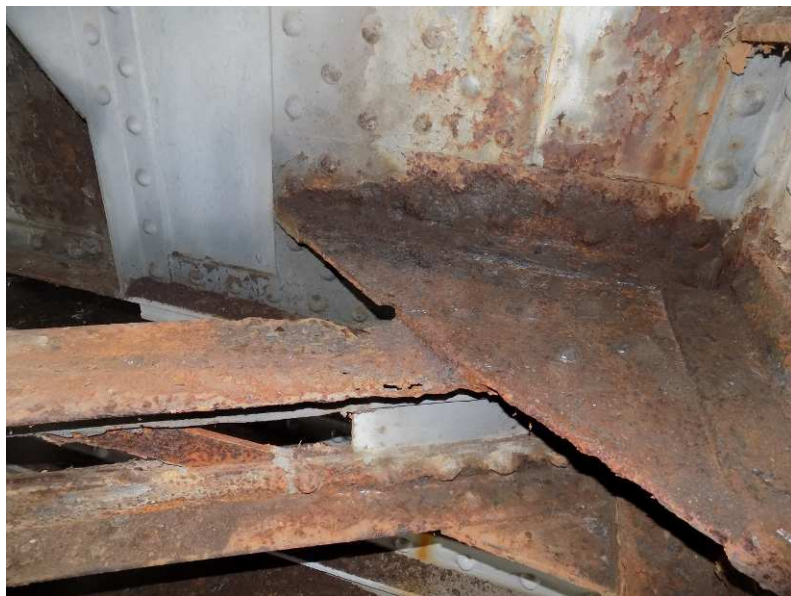
Obr. 2.56 – sonda 18 , pohled na přípoj styčnickového plechu a dolního vodorovného ztužení, silná koroze
