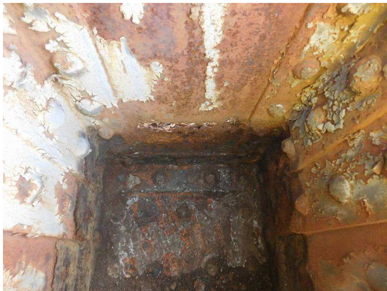
Obr. 2.28 – sonda 4 , styk svislice a dolního pasu, 24. svislice pravého spodního pasu nosné konstrukce
