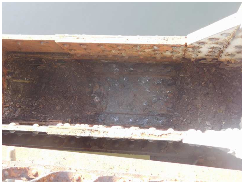
Obr. 2.36 – sonda 8 , spodní hlavní pás, ocelový průřez je zcela zanesený nečistotami
