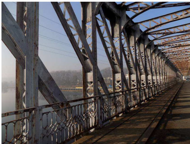
Obr. 2.9 – diagonála a svislice, v části nad mostovkou povrchová koroze
