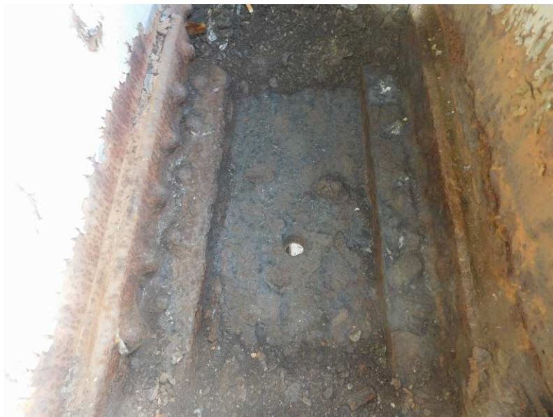
Obr. 2.34 – sonda 7 , spodní hlavní pás, ocelový průřez je zcela zanesený nečistotami
