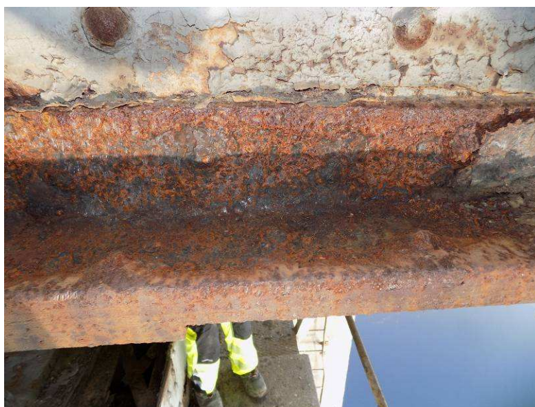
Obr. 2.17 – oslabení dolního hlavního nosníku silnější korozi (oslabení do 10% průřezové plochy)
