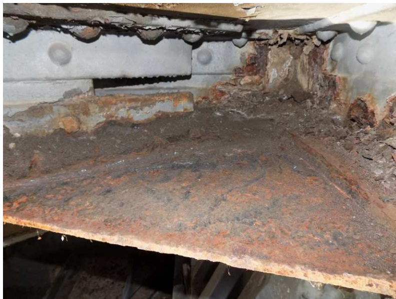
Obr. 2.48 – sonda 14 , styčnickový plech, silnější koroze, lokálně oslabení průřezové plochy do 25%
