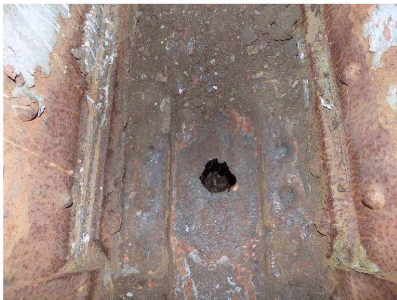
Obr. 2.42 – sonda 11 , spodní hlavní pás, množství nečistot, silná koroze plechu spodního pasu
