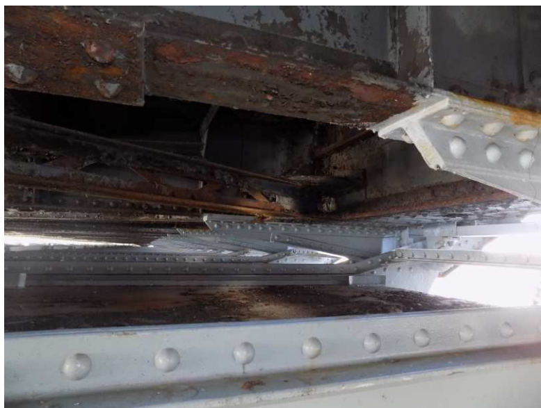
Obr. 2.13 – spodní líc příčnicku nosné konstrukce
