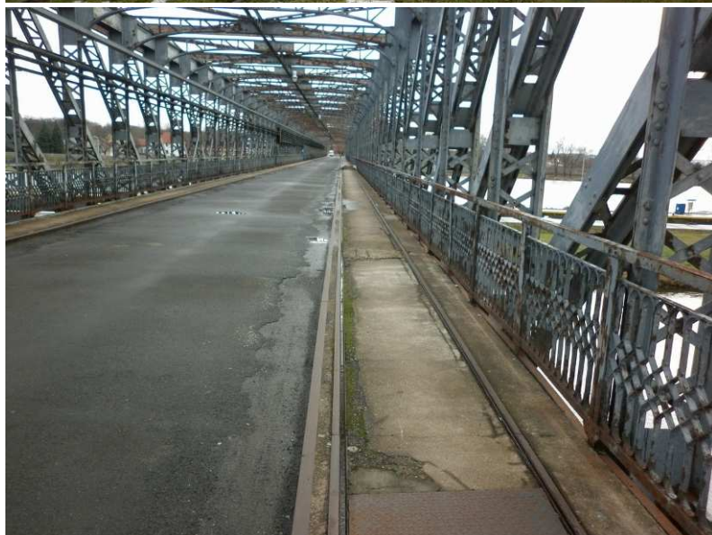
Obr. 2.65 – kolejová dráha v pravé části chodníkové konzoly v poli 1 a 2
