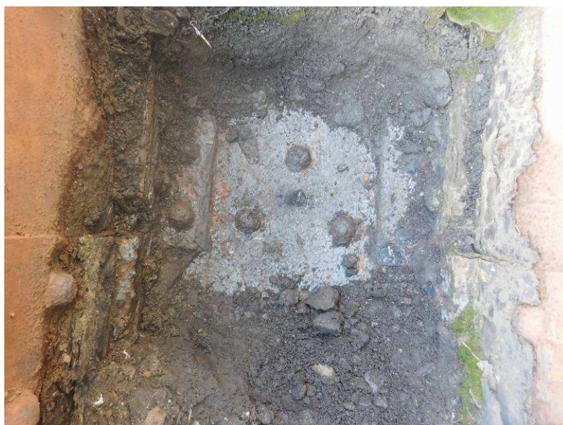
Obr. 2.27 – detail sondy 3, spodní pás je pod vrstvami nečistot v relativně uspokojivém stavu
