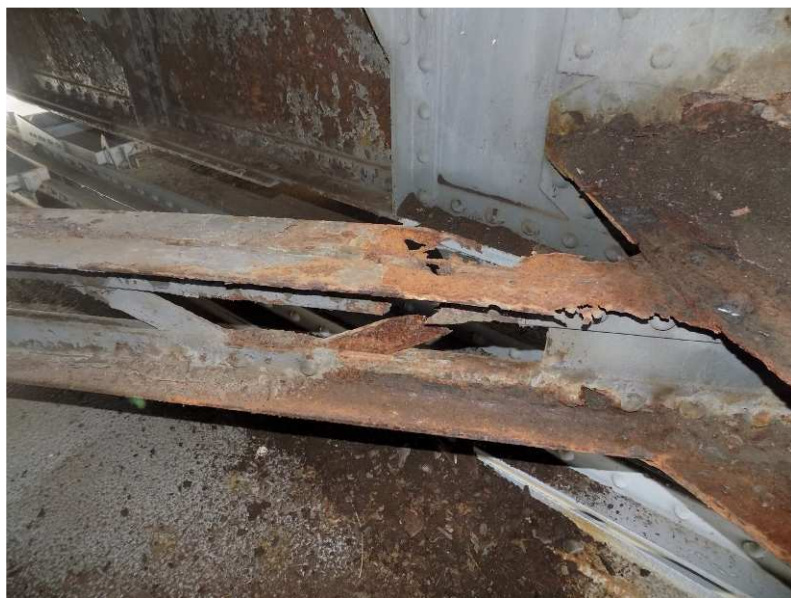
Obr. 2.58 – sonda 19 , pohled na přípoj styčnickového plechu a dolního vodorovného ztužení, silná koroze
