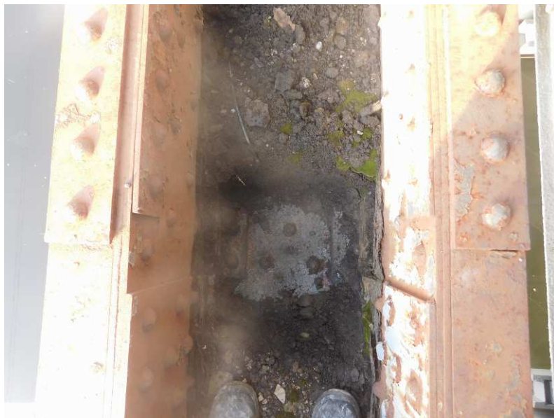
Obr. 2.26 – sonda 3 , spodní hlavní pás, ocelový průřez je zcela zanesený nečistotami do výšky cca 10 cm
