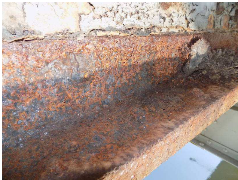
Obr. 2.49 – sonda 14, spodní pás nosné konstrukce, silnější koroze, oslabení průřezové plochy do 15%
