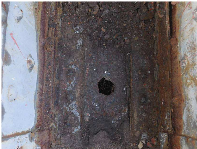
Obr. 2.38 – sonda 9 , spodní hlavní pás, množství nečistot, silná koroze plechu spodního pasu
