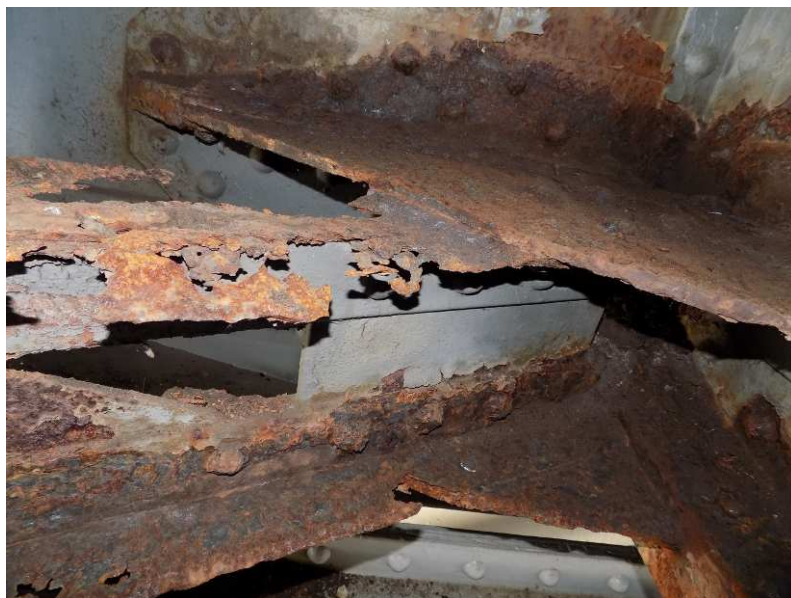
Obr. 2.61 – sonda 19 , detail velmi silné koroze horní pásnice dolního vodorovného ztužení
