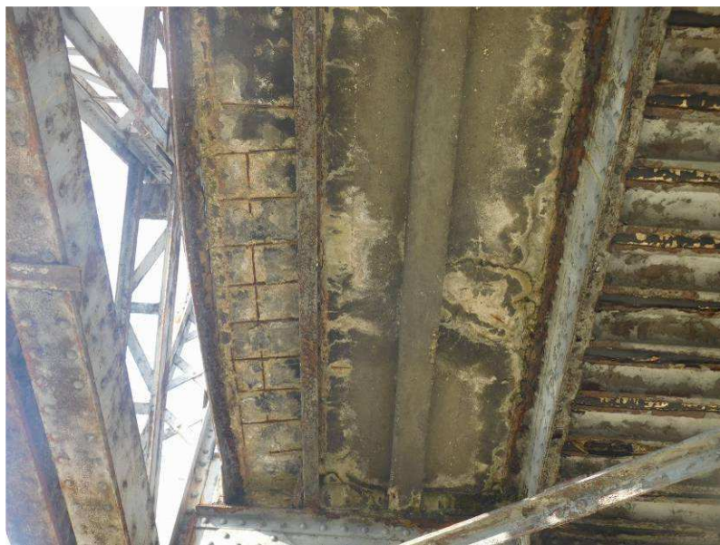
Obr. 2.70 – spodní líc pravé konzoly v poli 2 – typický stav, povrchová degradace betonových konstrukcí, koroze betonářské výztuže, koroze ocelového nosníku I140
