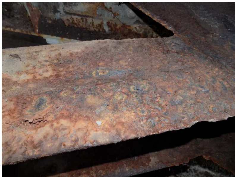
Obr. 2.55 – sonda 17 , detail velmi silné koroze horní pásnice dolního vodorovného ztužení
