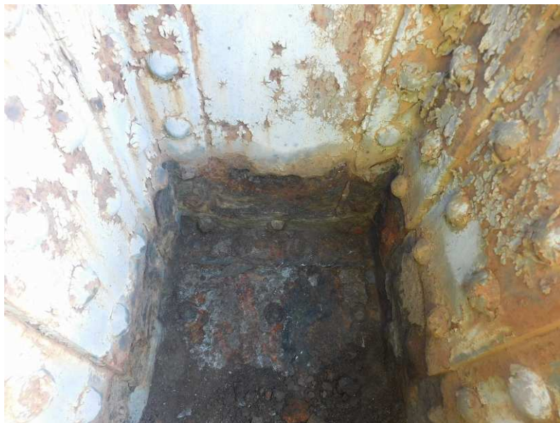
Obr. 2.30 – sonda 5 , styk svislice a dolního pasu, 26. svislice pravého spodního pasu nosné konstrukce
