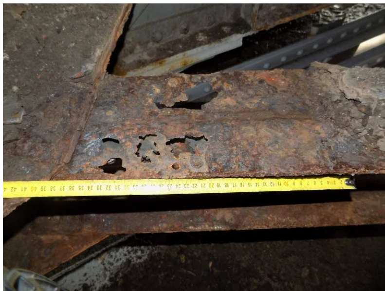
Obr. 2.51 – sonda 15 , detail velmi silné koroze horní pásnice dolního vodorovného ztužení
