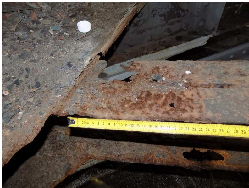
Obr. 2.53 – sonda 16 , detail velmi silné koroze horní pásnice dolního vodorovného ztužení
