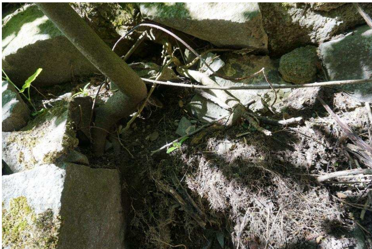
6. Detail uložení dlažby – prorůstání vegetací a absence podkladu pod dlažbou
