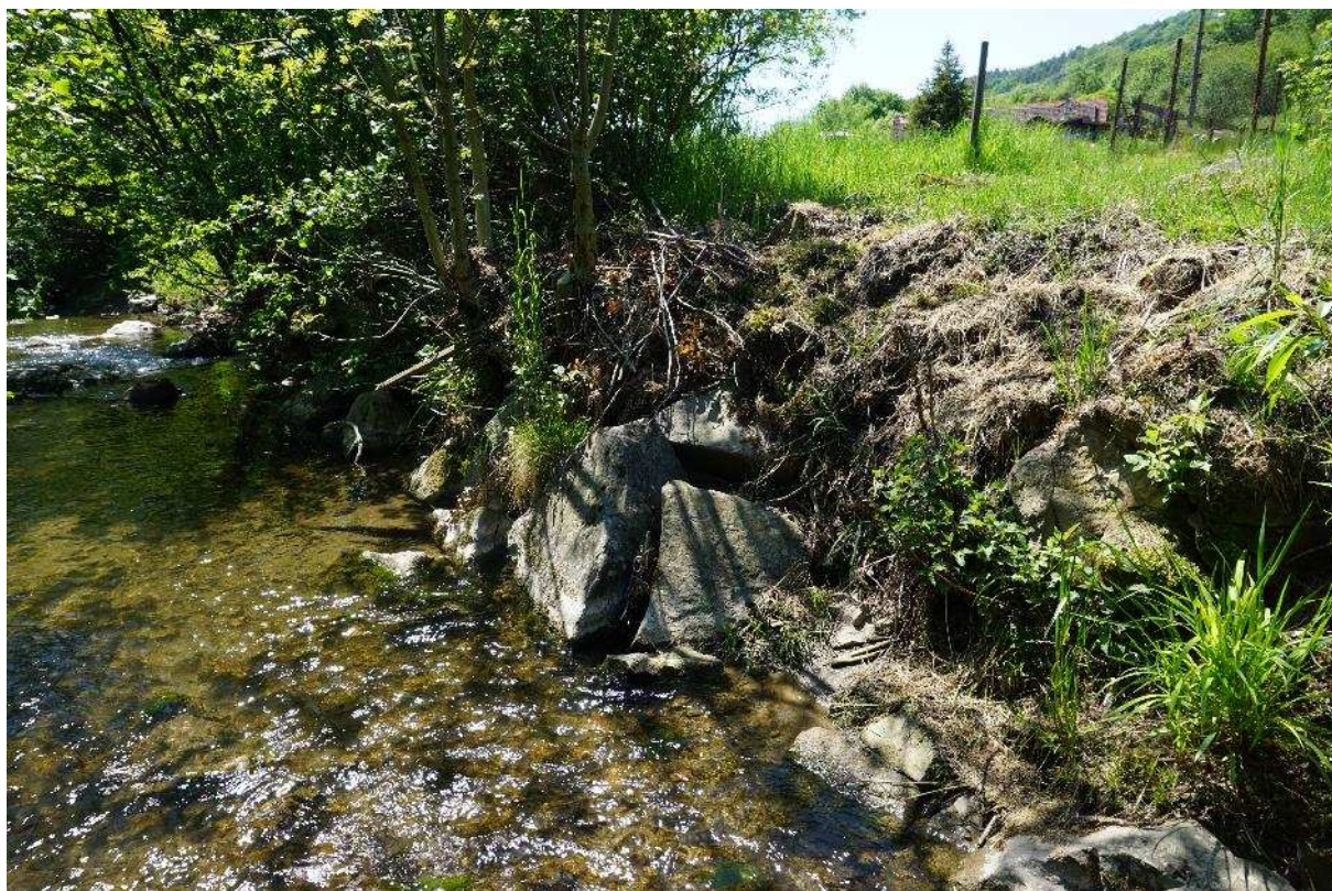
17. Chybějící opevnění ve dně, patrné částečné opevnění v patě svahu
