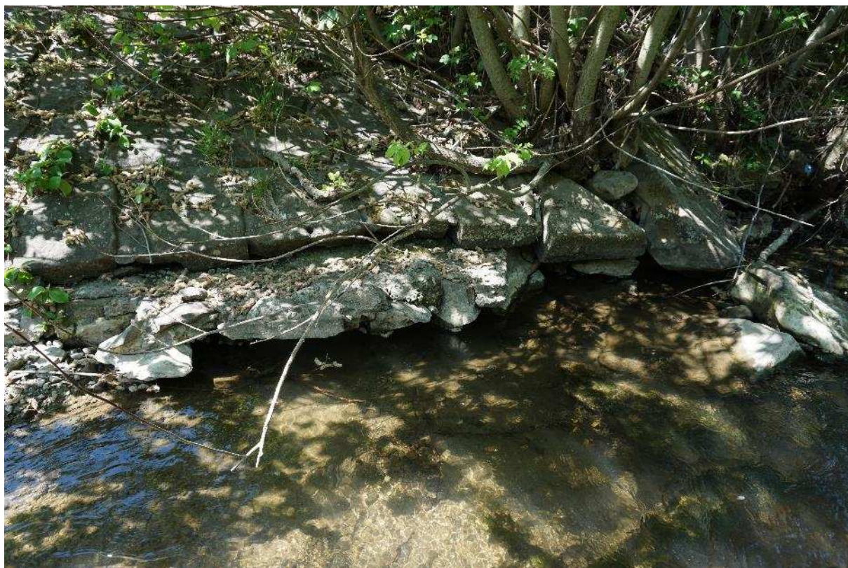
16. Absence opevnění ve dně – podemletí stávající kamenné dlažby na břehu
