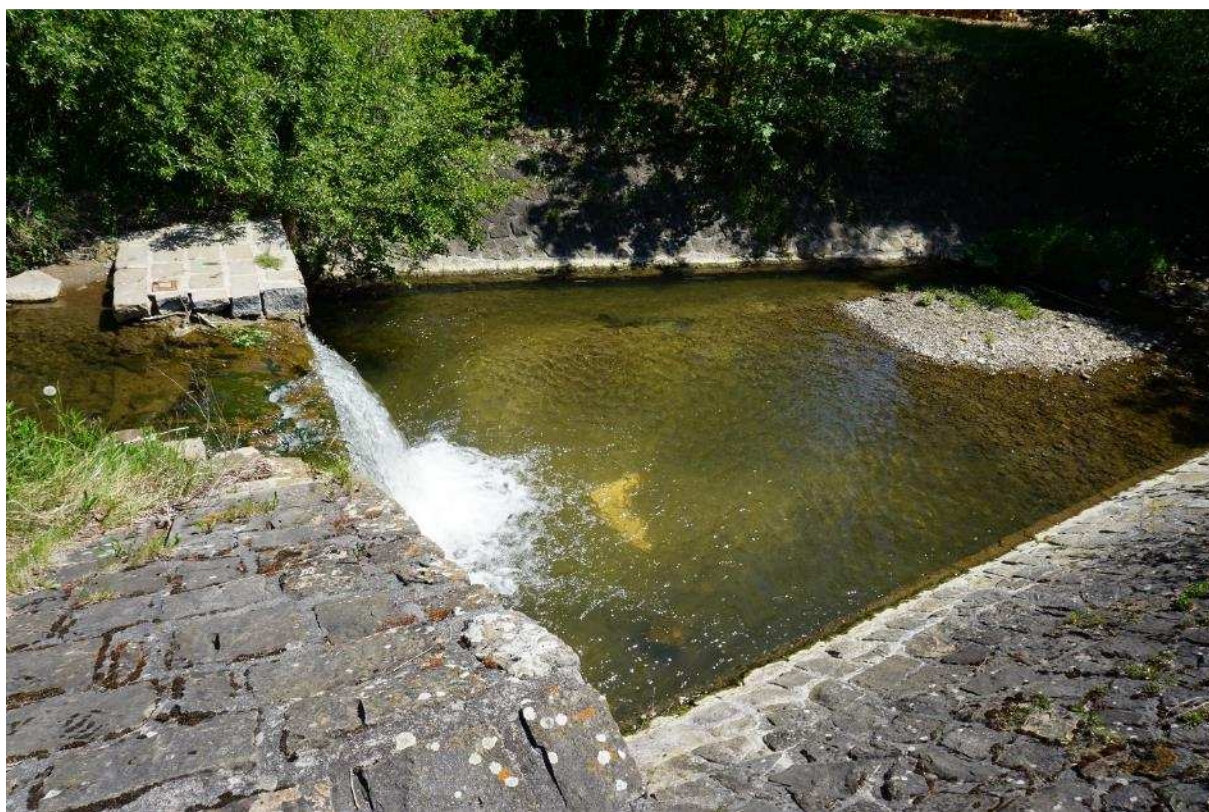
12. Vývar + stupeň – zanesení vývaru sedimentem
