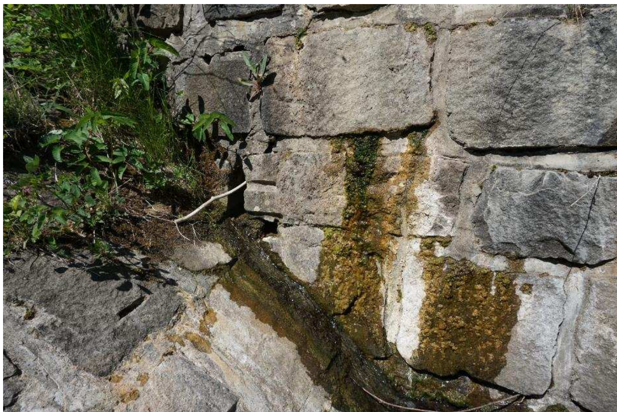
15. Detail průsaku stávající konstrukcí
