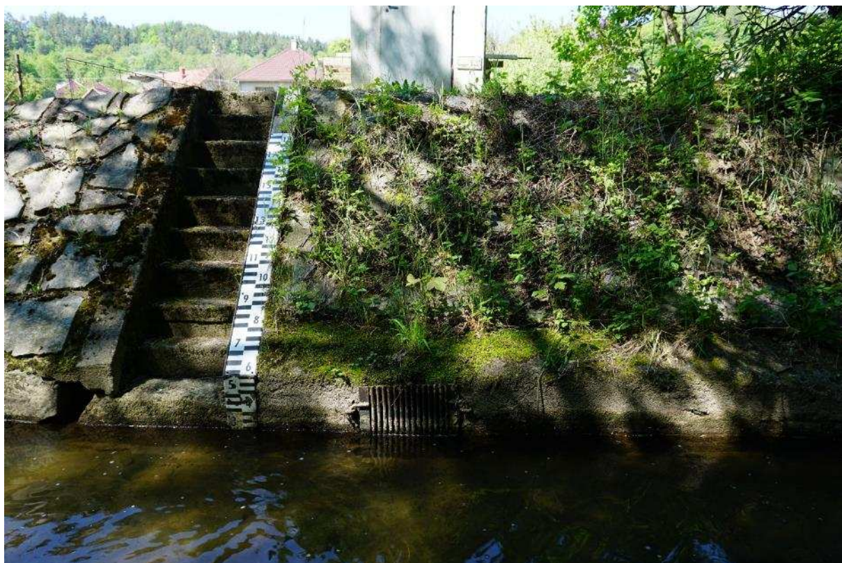
5. Vtokový objekt do limigrafu s vodočetnou latí a stávajícím betonovým schodištěm
