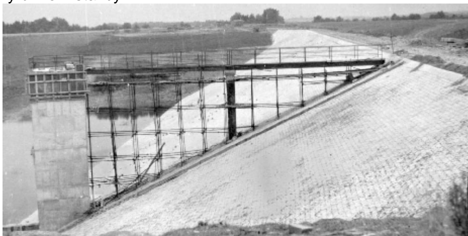
Zajištění přístupu na věžový objekt během výstavby – prostorové lešení
