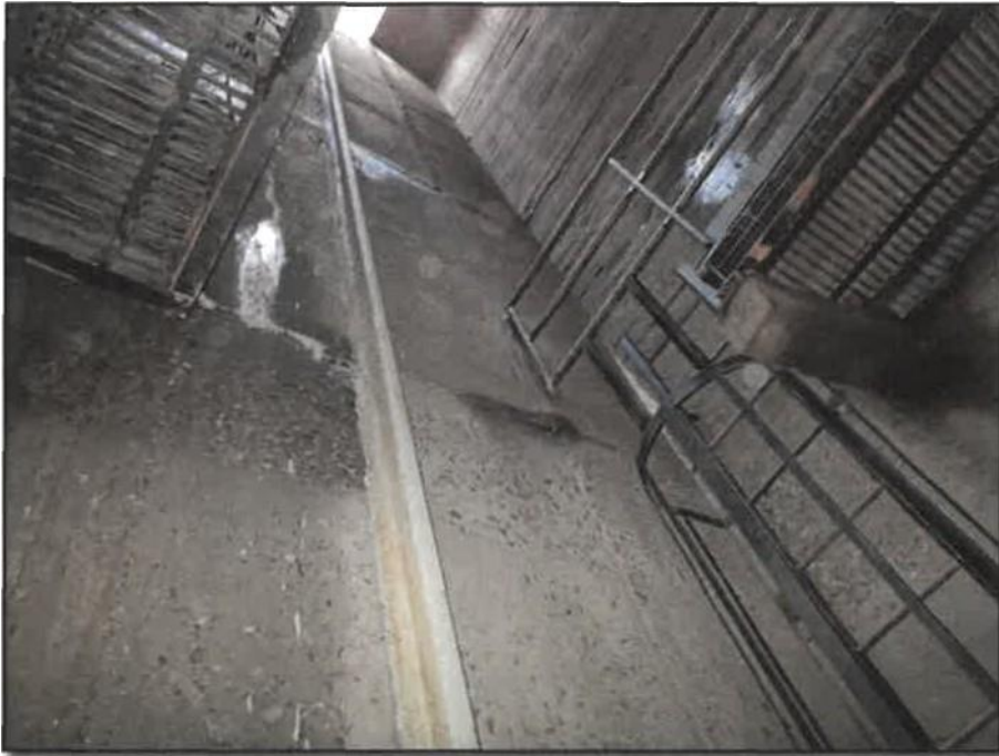
Pohled na vnitřní povrchy betonu a pracovní spáry šachty návodního uzávěru v bloku 21VI
