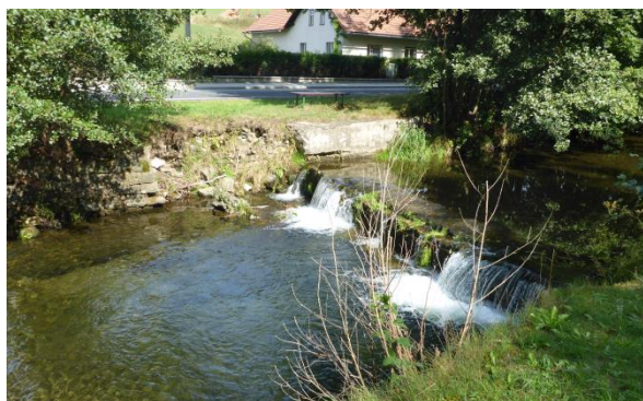
Obr. 3 SO 01 – Petrův jez k rekonstrukci, rozšíření pravého břehu, úprava opevnění a nivelety dna (SO 01)
