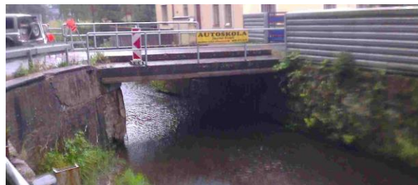
Obr. 13 Mostek nad SO 02 (vlastní PPO ochrana na LB), zúžení toku Doměrek 2018, pohled proto proudu
