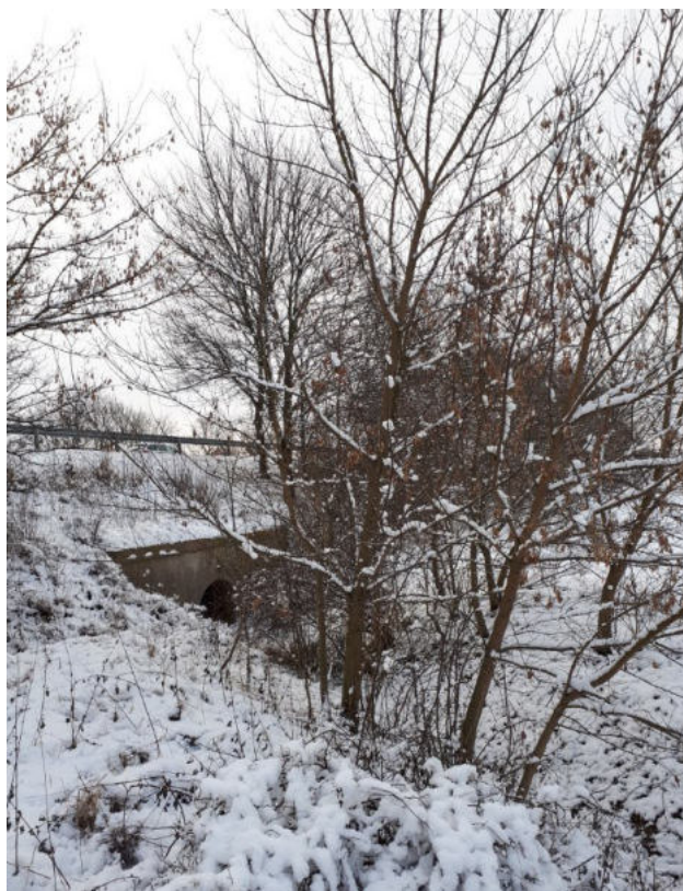
Konec úseku u dálničního tělesa
