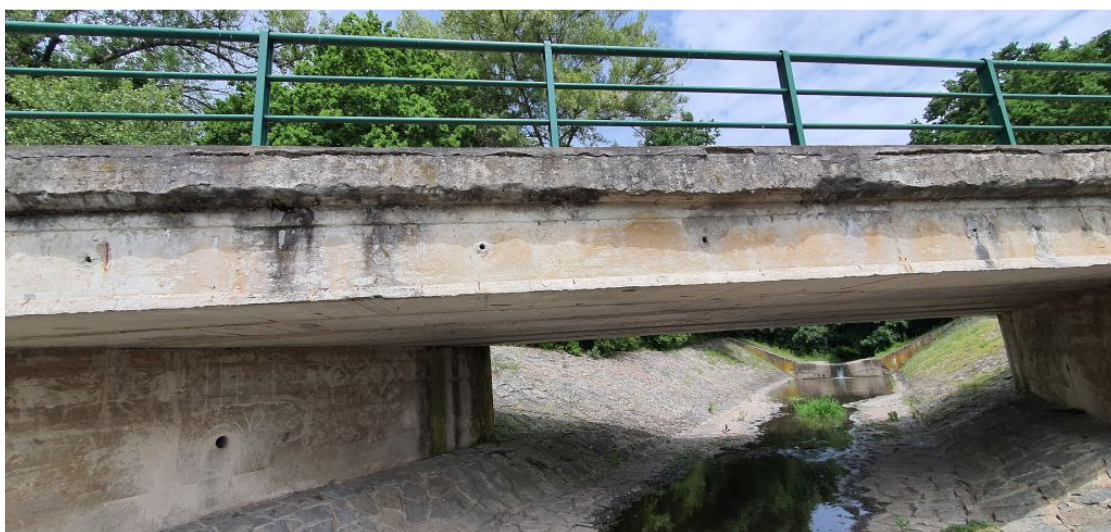
Obrázek 9-Pohled na most z výtokové strany – koroze betonu říms
