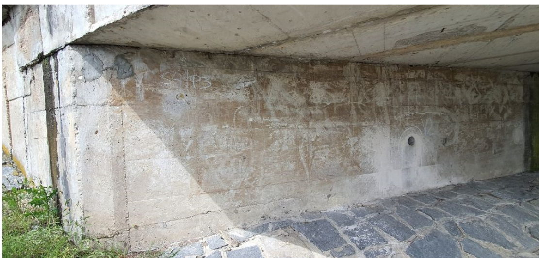
Obrázek 12-Pohled na spodní stavbu mostu – koroze betonu pravobřežní opěry
