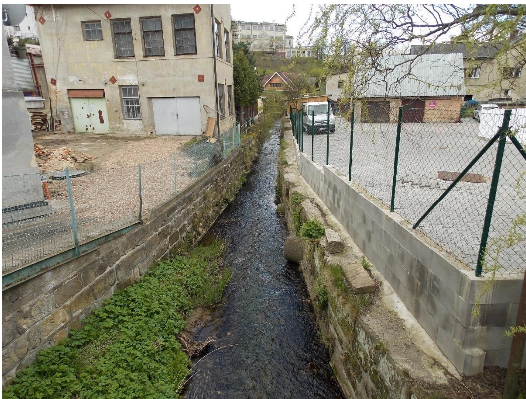
Obr.10 Koryto Stebenky v úseku mezi ř. km 0,860 – 1,020 – obtížně přístupný úsek s nánosy. Pohled z mostu po toku.
