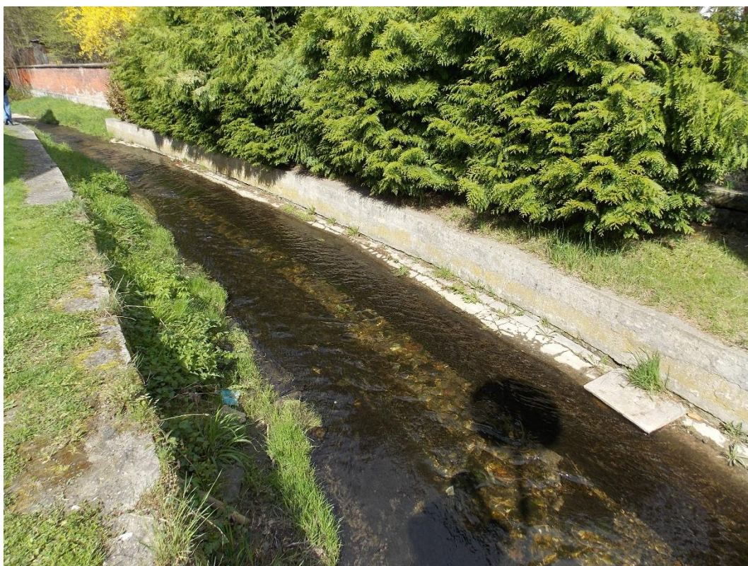
Obr.7 Koryto Stebenky v úseku mezi ř. km 0,620 – 0,860 – nánosy při levém břehu
