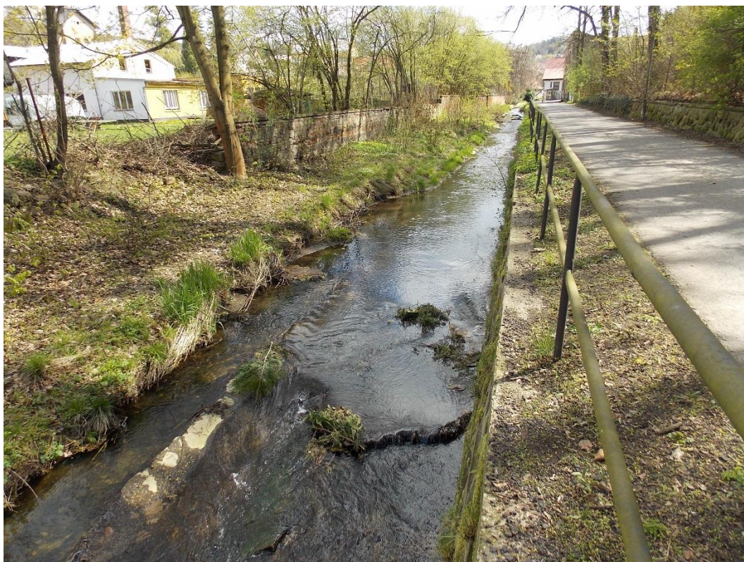
Obr.2 Nátrže na pravém břehu v úseku mezi ř. km 0,620 – 0,860, betonové opevnění dna koryta
