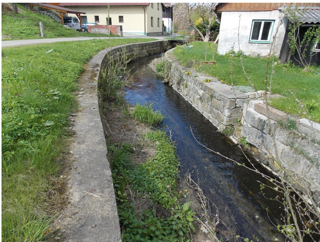
Obr.8 Koryto Stebenky v úseku mezi ř. km 0,620 – 0,860 – nánosy na levém břehu
