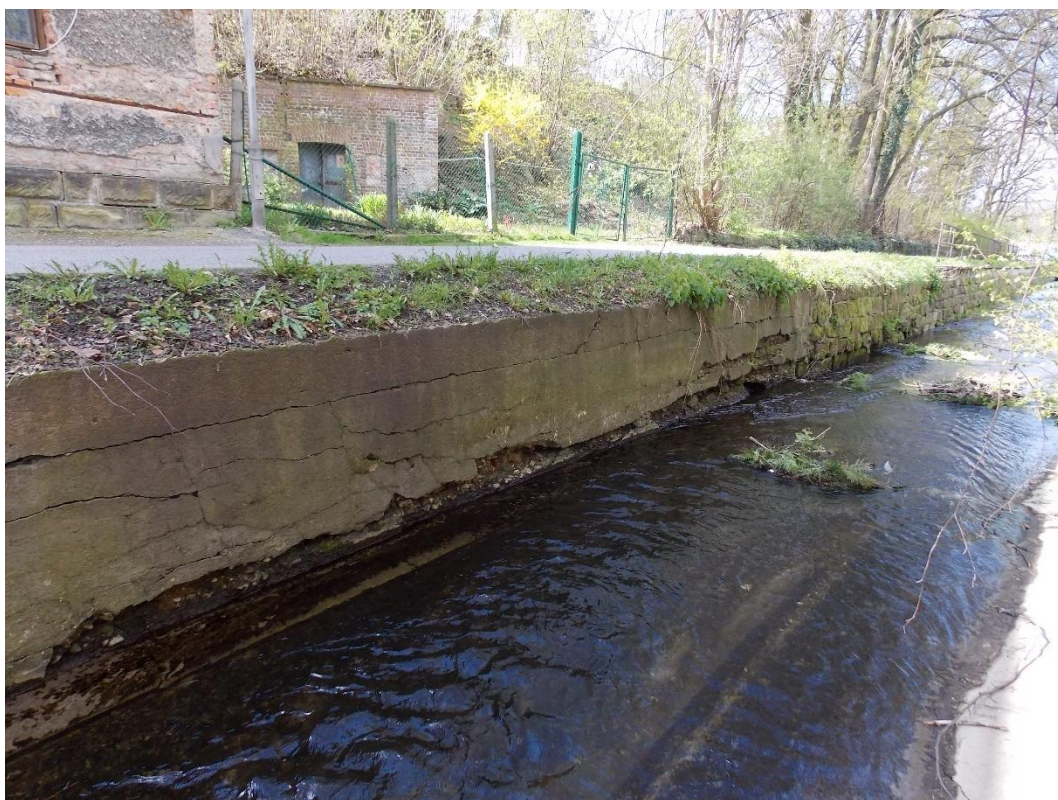
Obr.6 Stávající levobřežní zeď v ř. km 0,620 – 0,860 – nevyhovující stav
