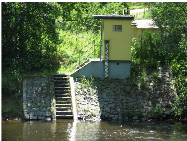
Obrázek 16 – objekt LMG Nové Spolí
