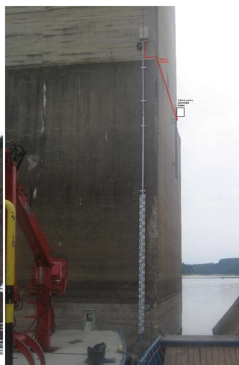
Obrázek 28 – schéma instalace solárního panelu Most Podolsko, Vltava
