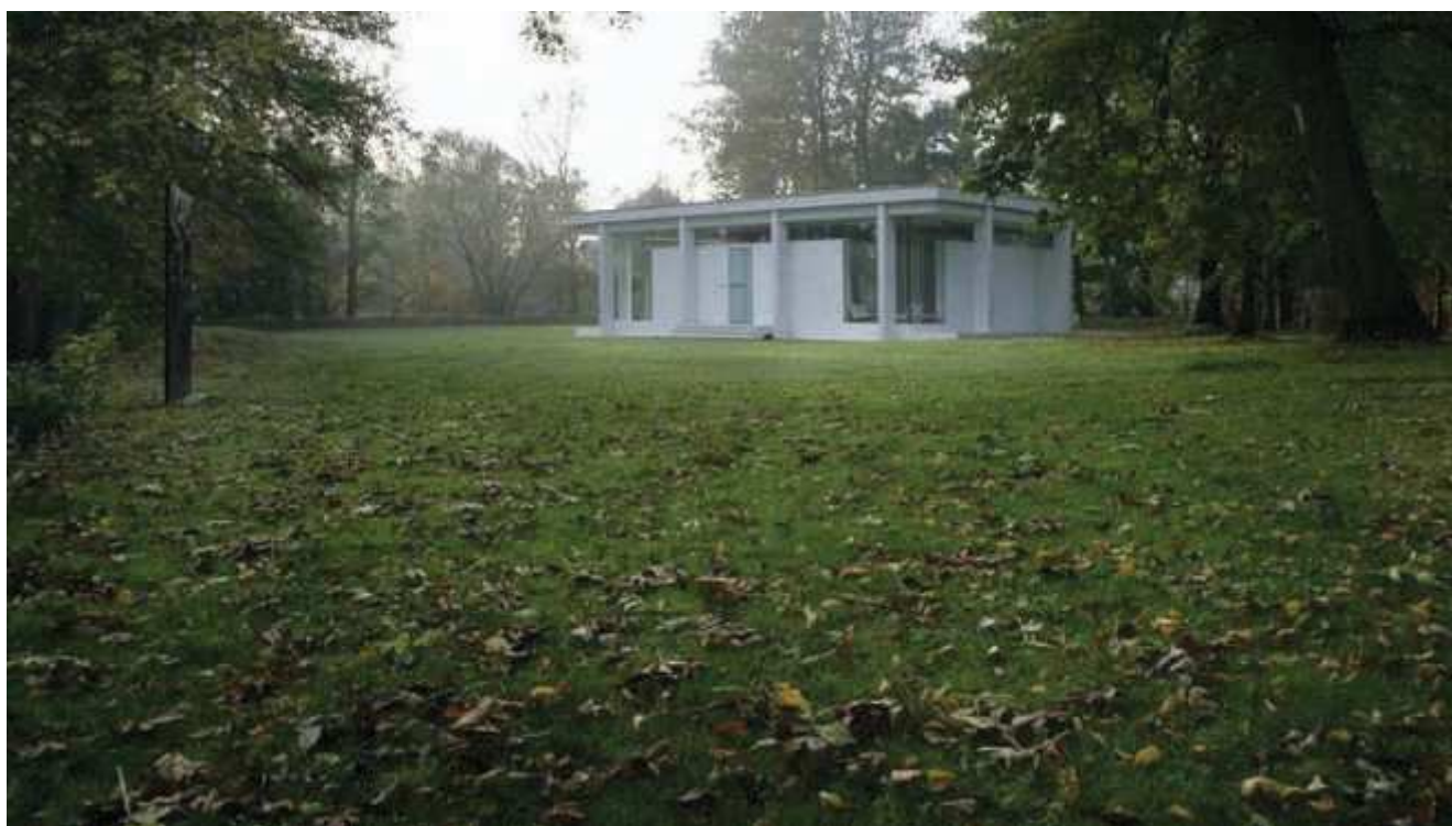
meandr Desné se stavbou galerie, břehové porosty eliminované probírkami
