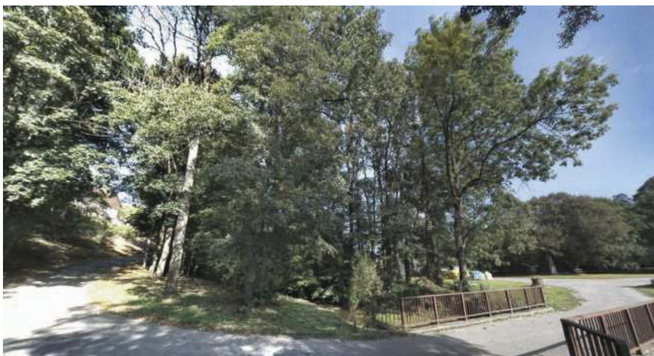
koryto toku zaříznuté v levobřežním svahu
