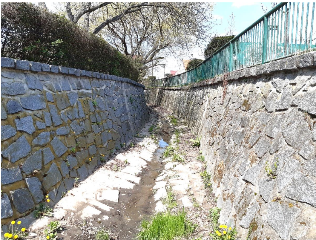
Obr. č.1 – Začátek úseku – oprava dlažby + opevnění (přespárování), nátěr zábradlí
