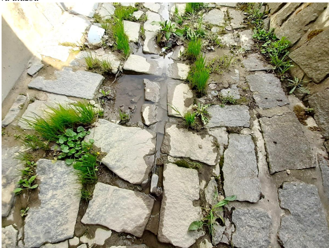
Obr. č.4 – Detailní pohled na vypadlé spáry v dlažbě – bude provedeno vysekání spár do hl. 7 cm, přespárování
