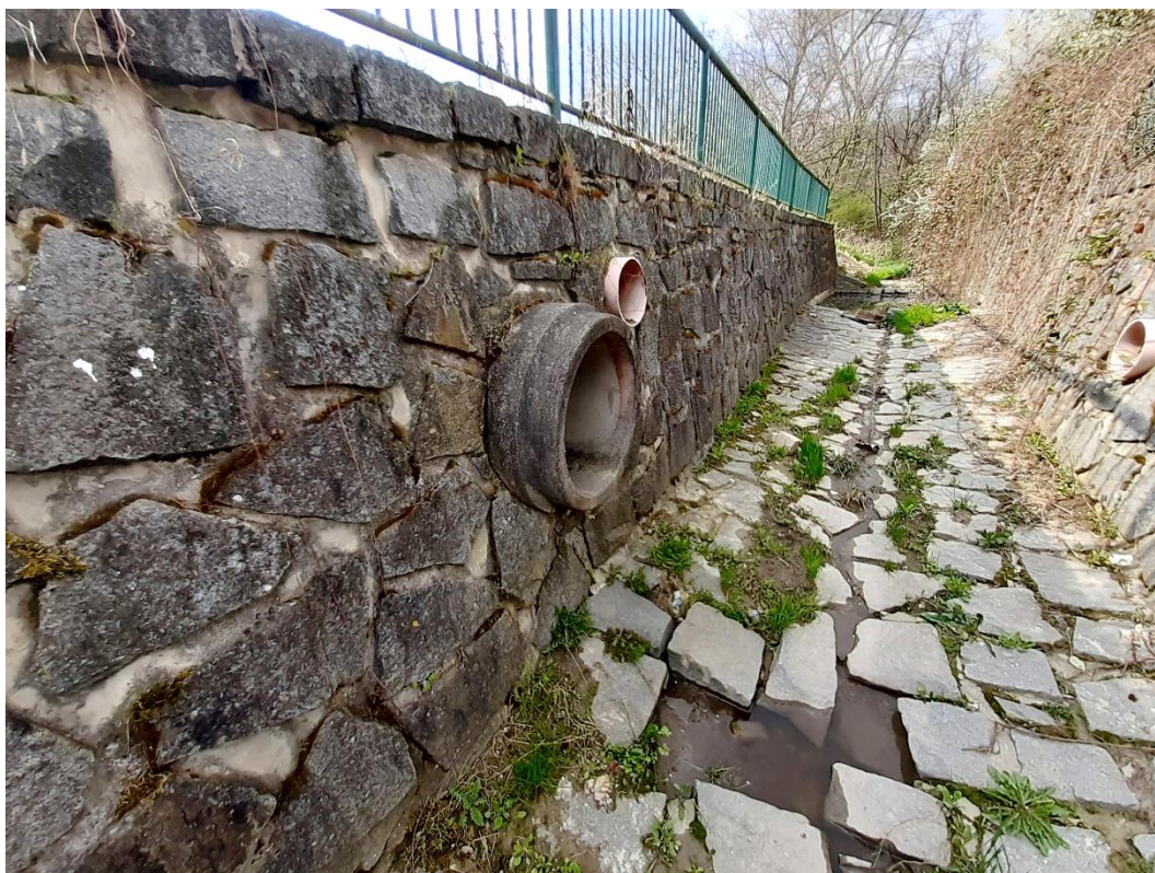
Obr. č.3– Vymletá dlažba pod výtokem z betonového potrubí – kompletní vybourání dlažby, nová dlažba
