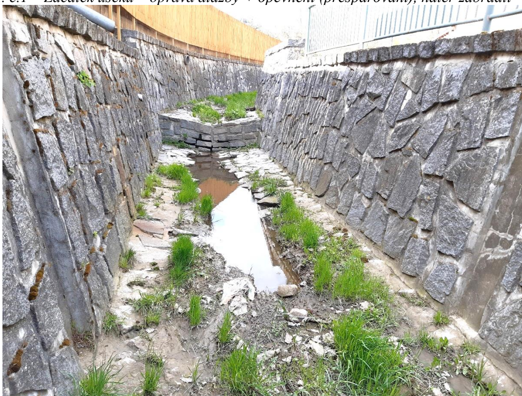
Obr. č.2 – Konec úseku – Pohled na rozpadlou dlažbu ve dně – kompletní oprava úseku
