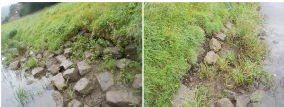
Poškození paty dlažby díky chybějící záhozové patě
