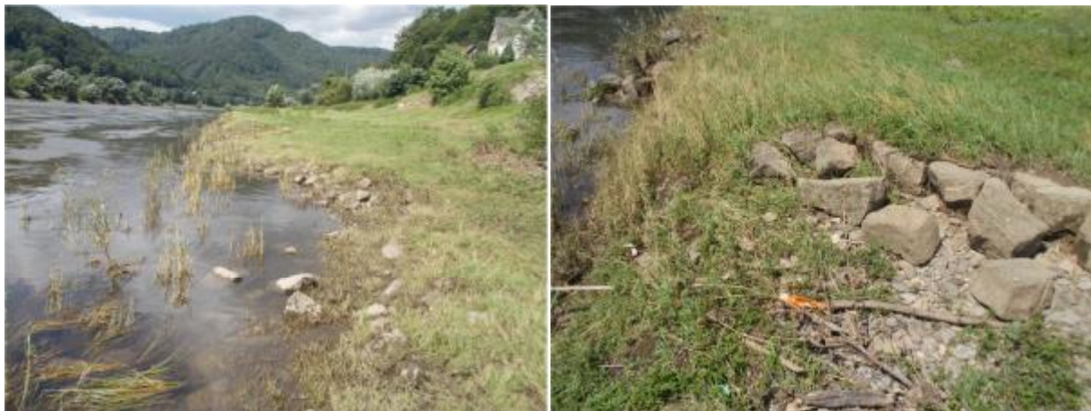
Chybějící úsek hráže (lokalita č.13) s rozpadající se dlažbou narušené hráže
