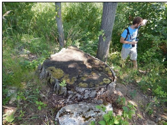
Uhnívající pařezy a kořenový systém stromů mají ohrožovat stabilitu hráze
