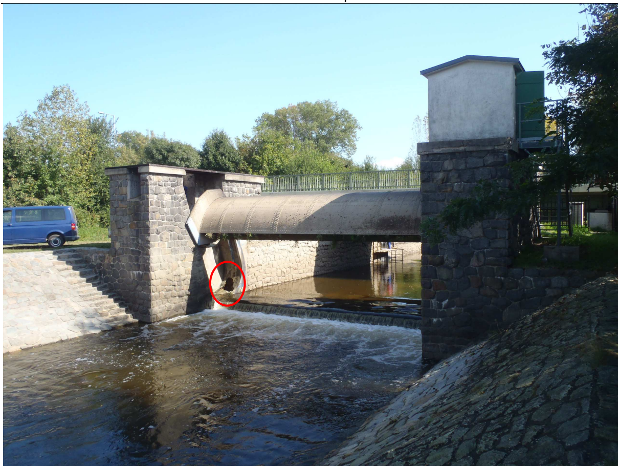
Obr. 6: Zobrazení poškození v kapsách jezových pilířů (2020).
