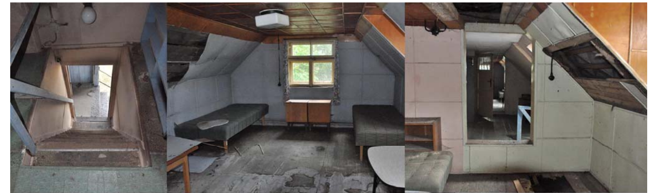
SCHODY DO 3NP
