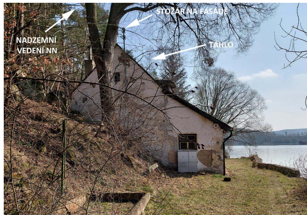
Stávající přípojka elektřiny: nadzemní vedení NN, stožár na štítu, táhlo
