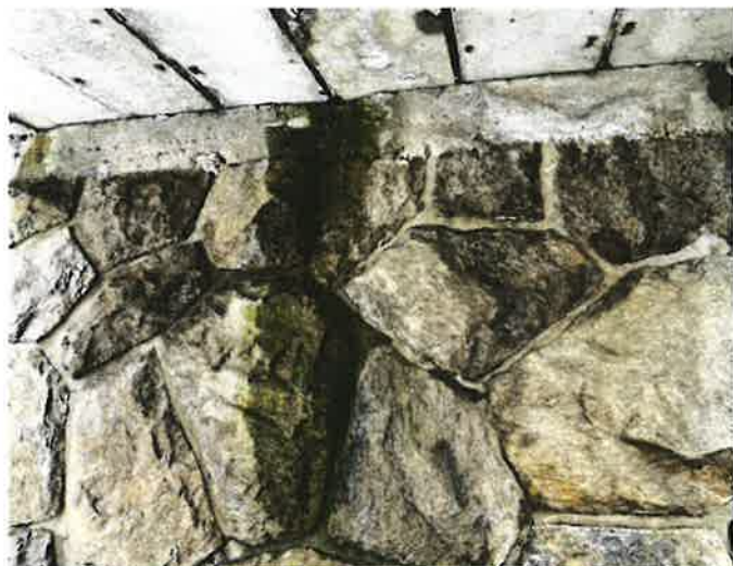
IMG_1398 - stopy po zatékání na opěře O4
