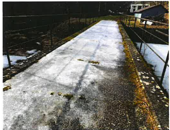
c_vozovka na objektu, pole 1_foto 28.2.21
