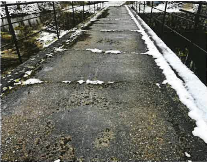
c_vozovka na mostě, pole 1
