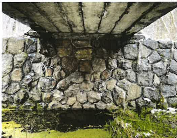
_Pohled na opěru O1
