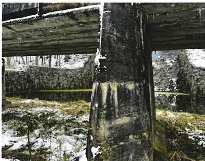
_ Pohled na pilíř P2 zleva
