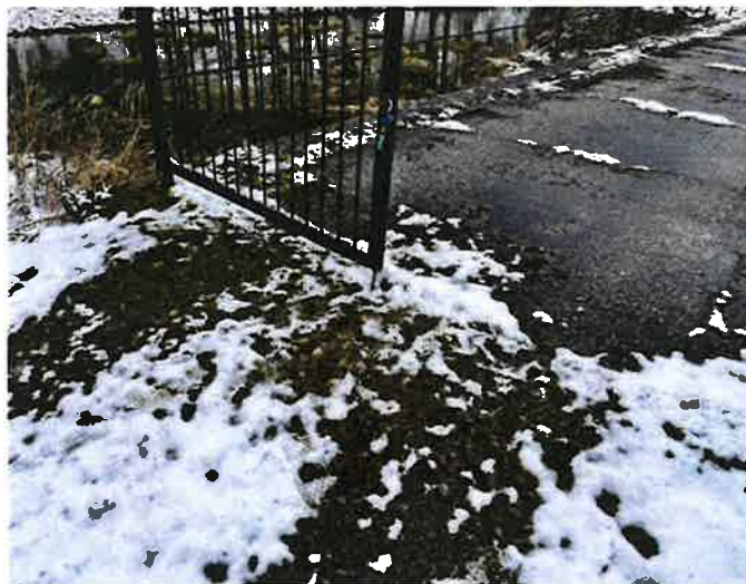
b_Přechod vozovky na most na začátku mostu
