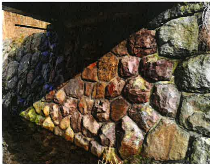
_Pohled na opěru O1_foto 28.2.21
