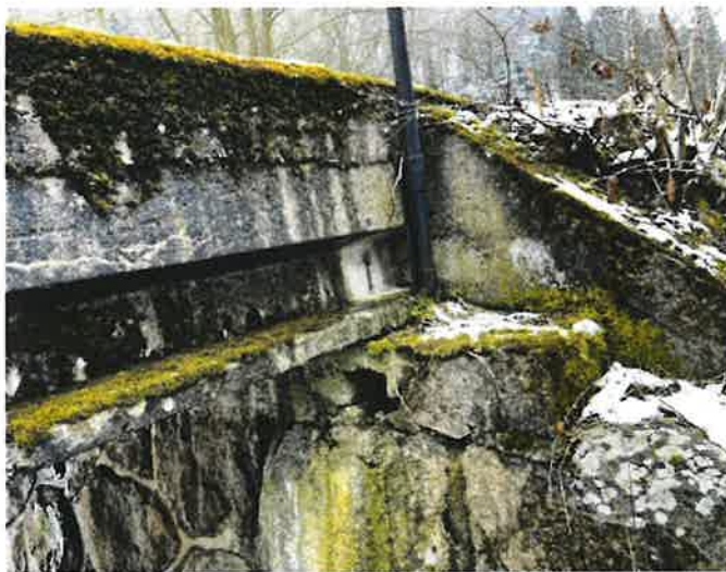
_pohled na uložení na opěře O4 zprava
