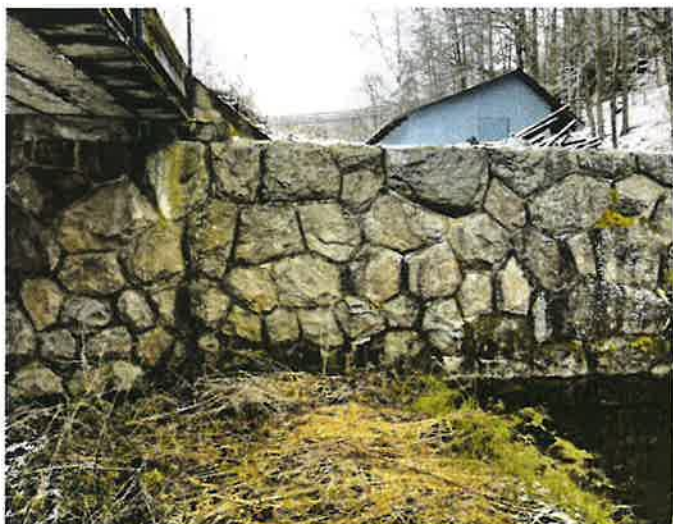
_Pravé křídlo na konci mostu (K4), (navazující opěrná zeď)
