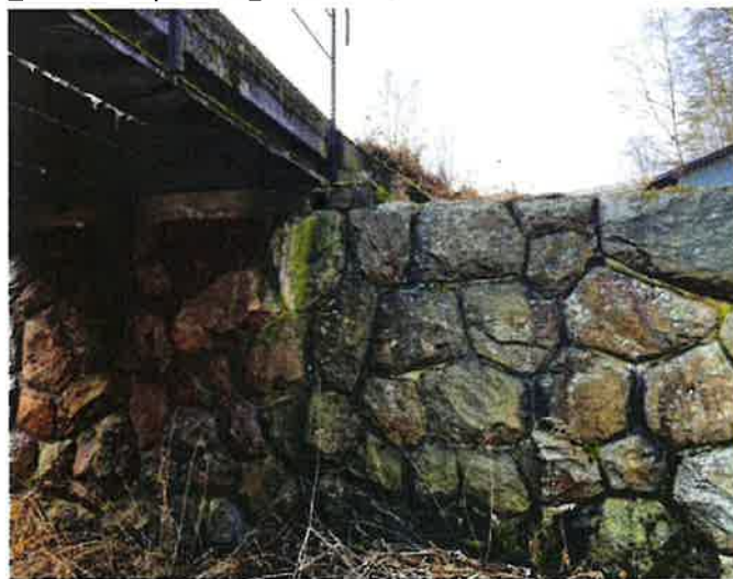
_Pravé křídlo na konci mostu (K4), (navazující opěrná zeď)_foto 28.2.21
