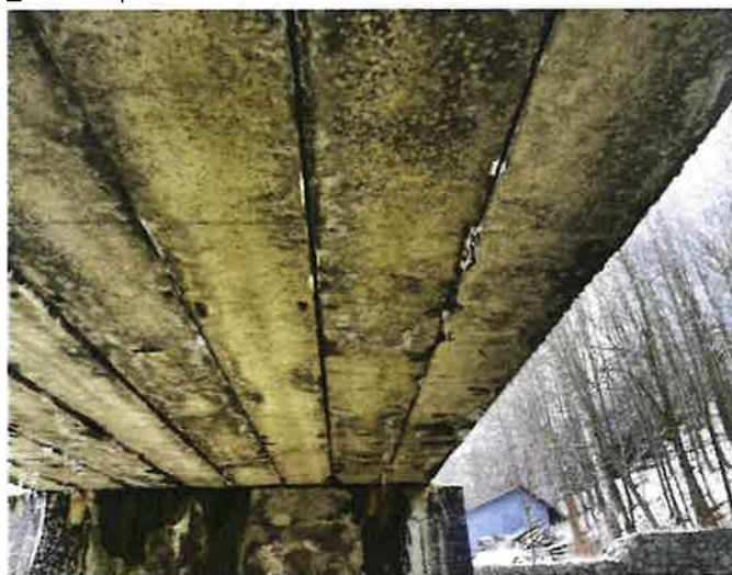
_Podhled pole 1 vpravo
