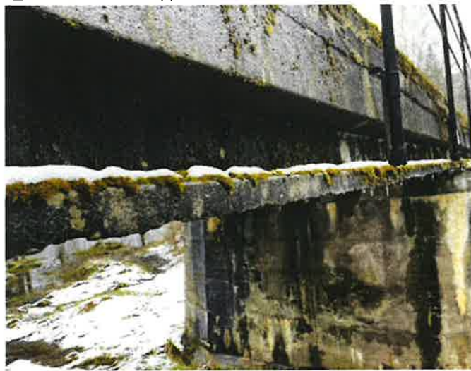
c_Pohled na NK zprava, pole 2
