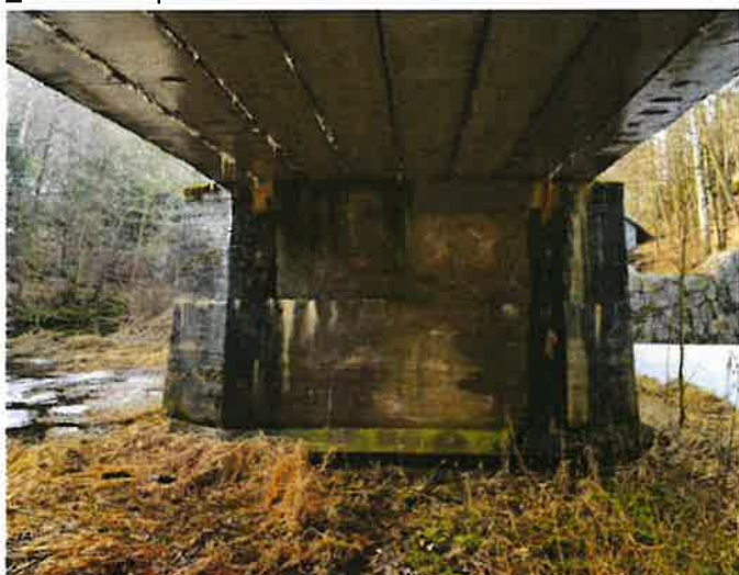
_Pohled na pilíř P2 z pole 1_foto 28.2.21
