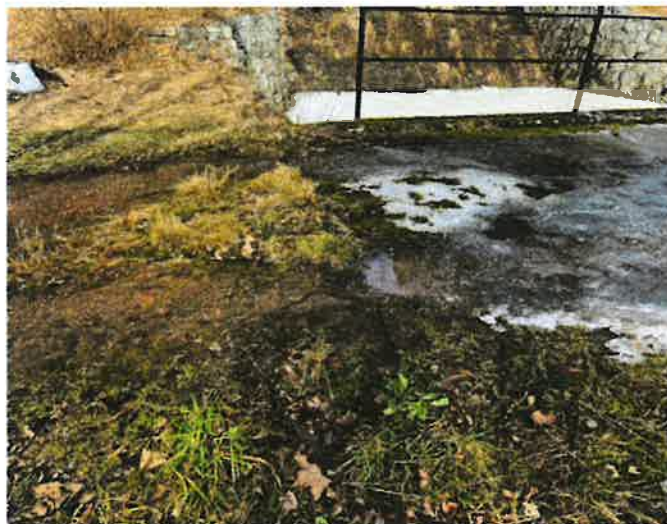
d_Přechod vozovky na most na konci mostu_foto 28.2.21
