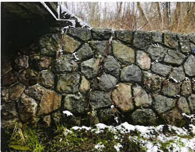
_Levé křídlo na začátku mostu (K1), (navazující opěrná zeď)
