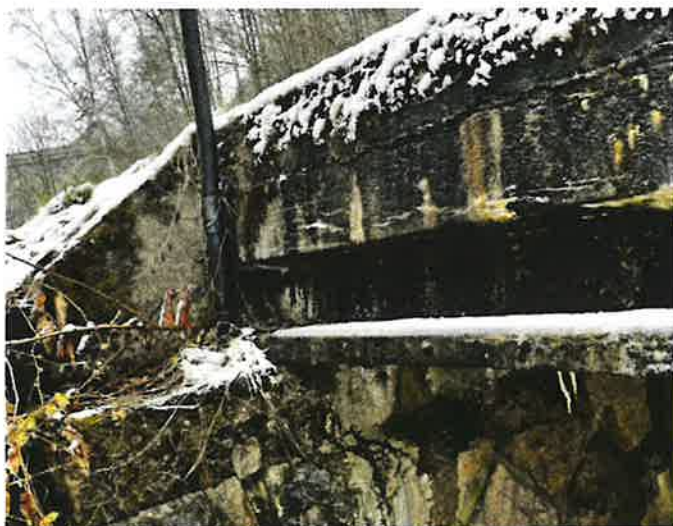
_pohled na uložení na opěře O4 zleva
