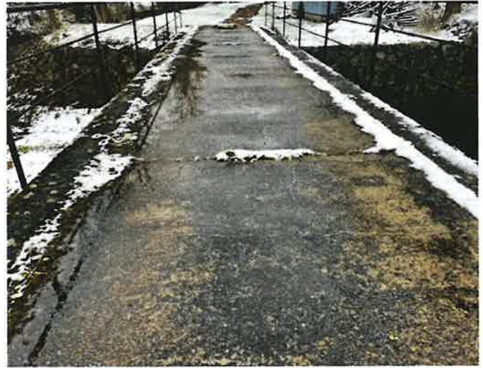
c_vozovka na mostě, pole 2
