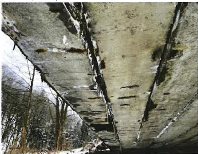
_Podhled pole 3 vlevo
