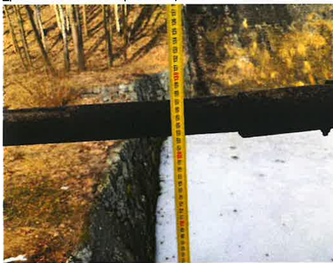
_vpravo ocelové zábradlí výšky 1270mm
