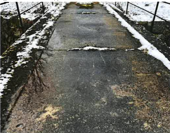
c_vozovka na mostě, pole 3
