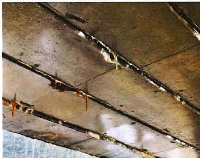
IMG_0269 - deformace jednotlivých nosníků nosné konstrukce pole 2 až 40mm, foto v zatížení pouze vlas
