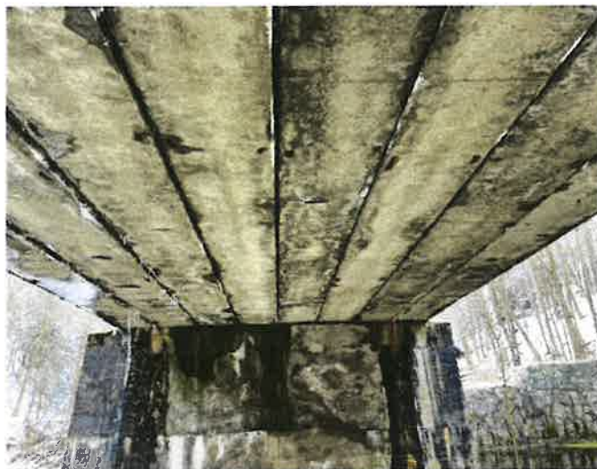
_Podhled pole 1 v ose
