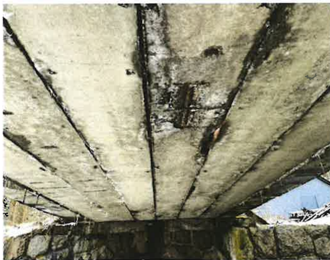
_Podhled pole 3 v ose
