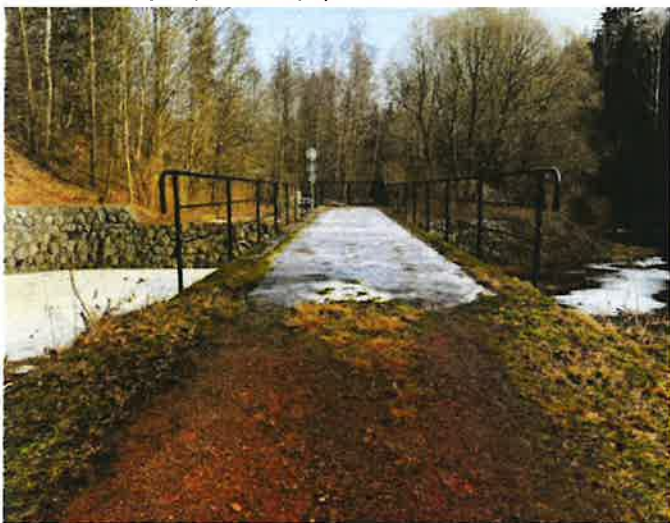
_Pohled na objekt proti směru popisu_foto 28.2.21
