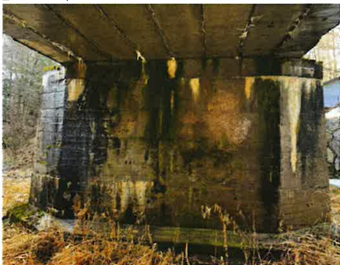
_ Pohled na pilíř P3 z pole 2_foto 28.2.21
