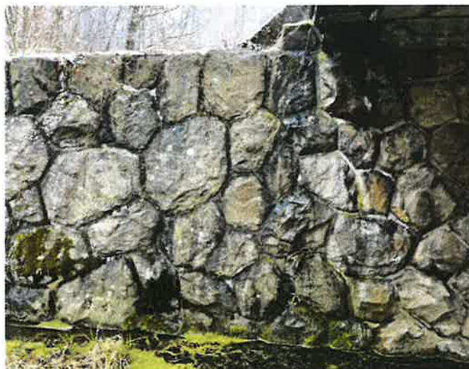
_Pravé křídlo na začátku mostu (K2), (navazující opěrná zeď)
