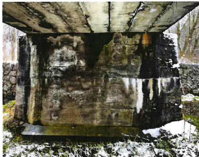
_Pohled na pilíř P2 z pole 2
