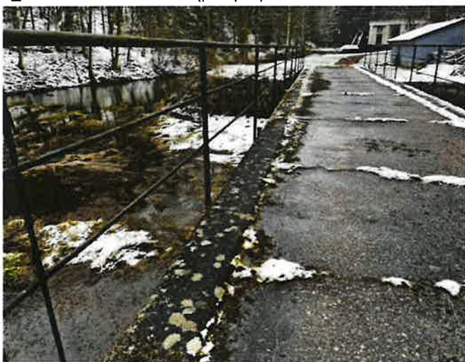
_Pohled na levou římsu po směru popisu
