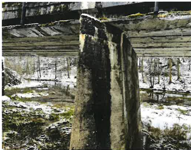
_Pohled na pilíř P3 zprava
