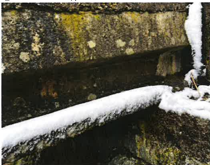
_pohled na uložení na opěře O1 zleva
