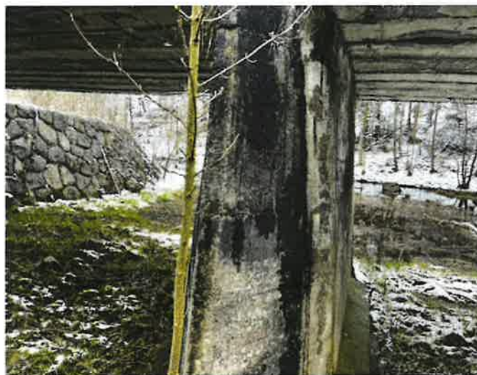
_ Pohled na pilíř P2 zprava
