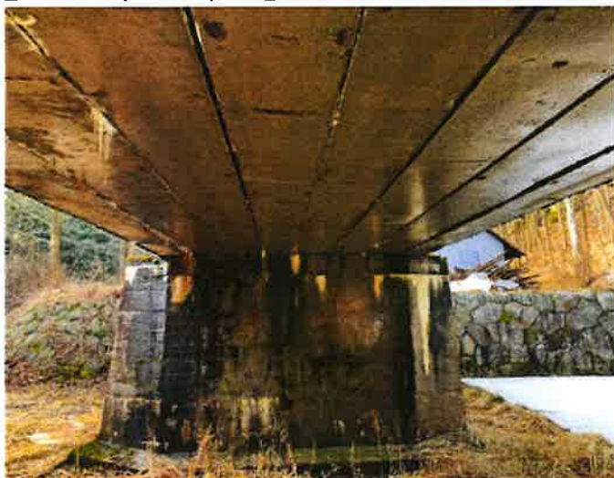
_Pohled na pilíř P2 z pole 2_foto 28.2.21
