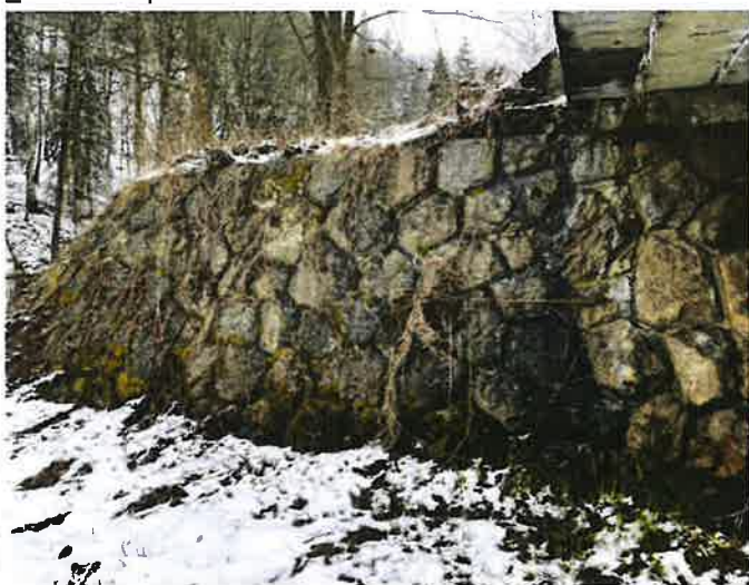
_Levé křídlo na konci mostu (K3)
