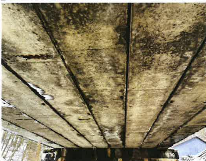
_Podhled pole 2 v ose
