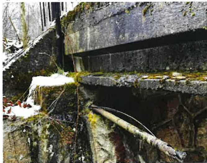
_pohled na uložení na opěře O1 zprava
