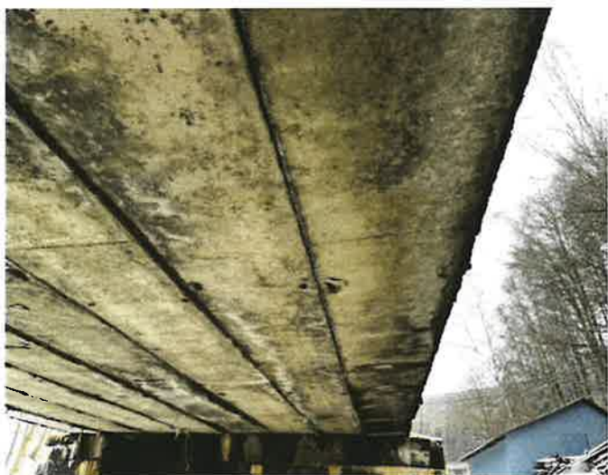
_Podhled pole 2 vpravo
