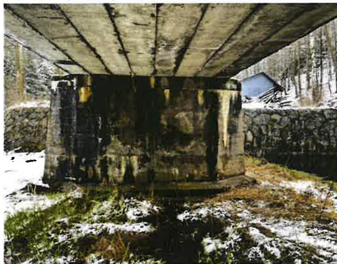
_ Pohled na pilíř P3 z pole 2
