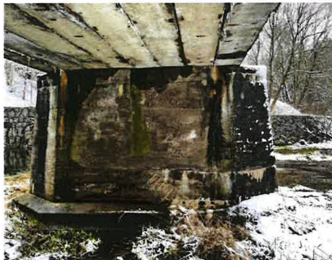
_ Pohled na pilíř P3 z pole 3
