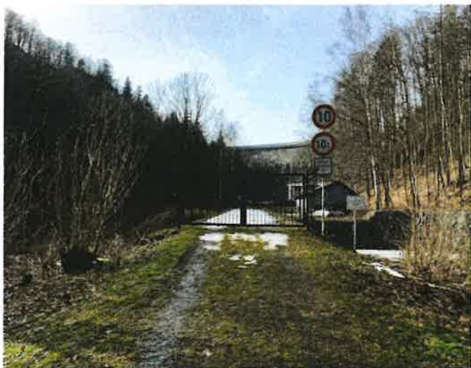
_Pohled na objekt po směru popisu_foto 28.2.21
