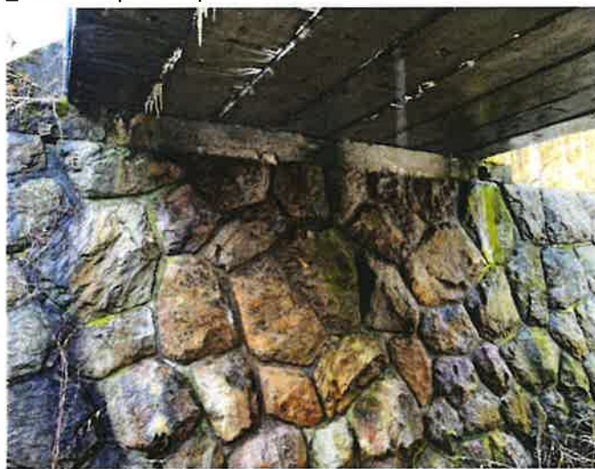
_Pohled na opěru O4_foto 28.2.21
