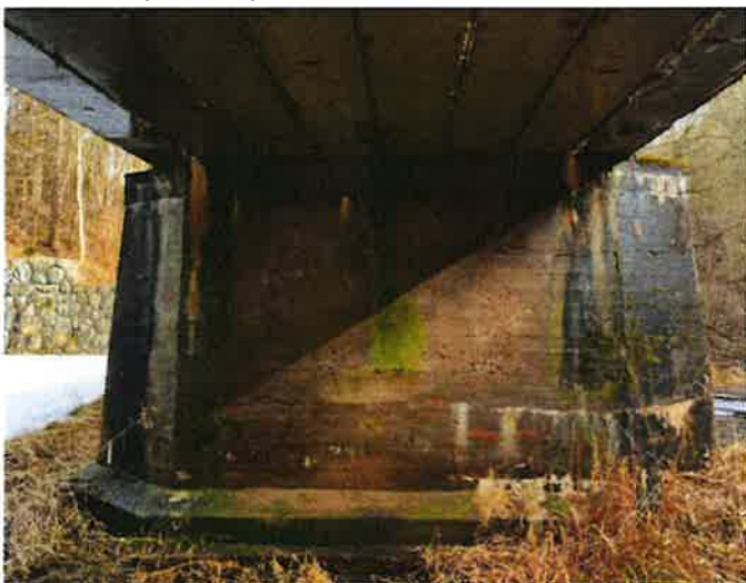
_ Pohled na pilíř P3 z pole 3_foto 28.2.21
