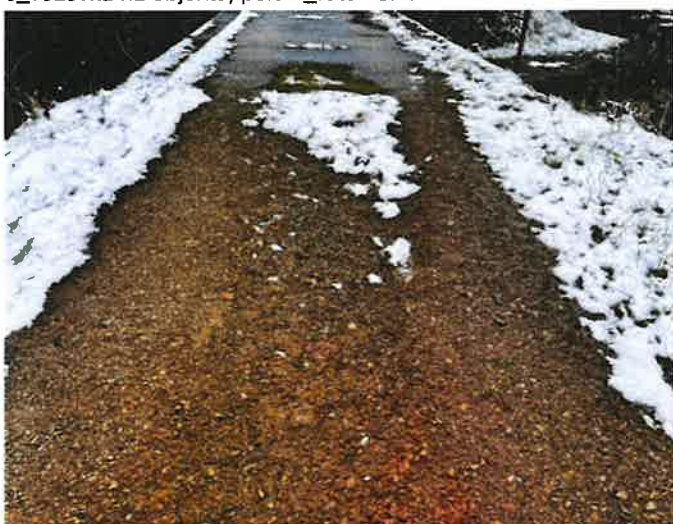
e_Vozovka na konci mostu (předpolí)
