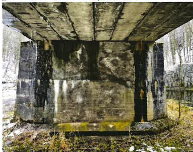
_Pohled na pilíř P2 z pole 1
