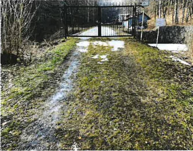
b_vozovka na začátku objektu (předpolí)_foto 28.2.21
