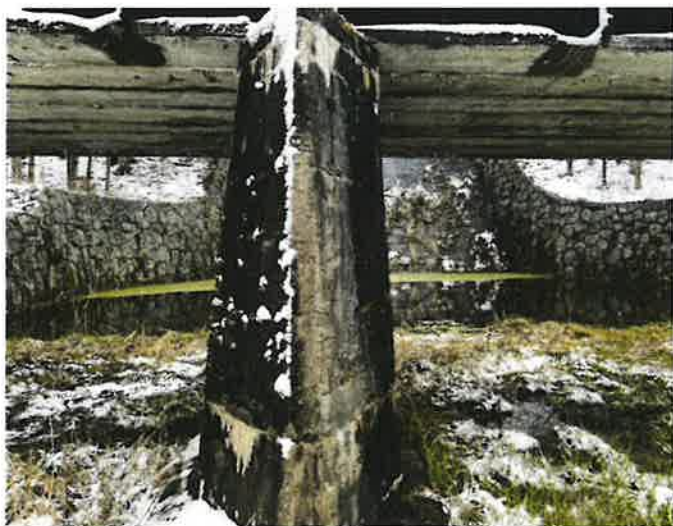
_Pohled na pilíř P3 zleva
