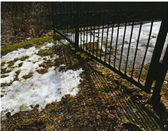
b_Přechod vozovky na most na začátku mostu_foto 28.2.21
