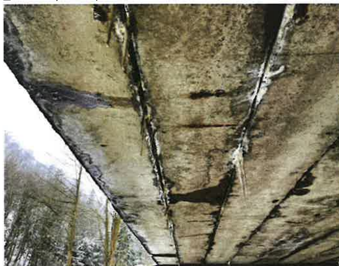
_Podhled pole 2 vlevo
