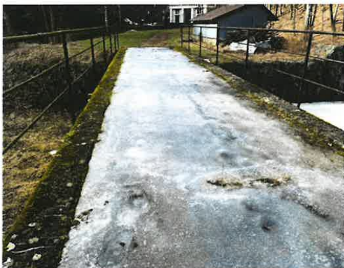
c_vozovka na objektu, pole 2_foto 28.2.21
