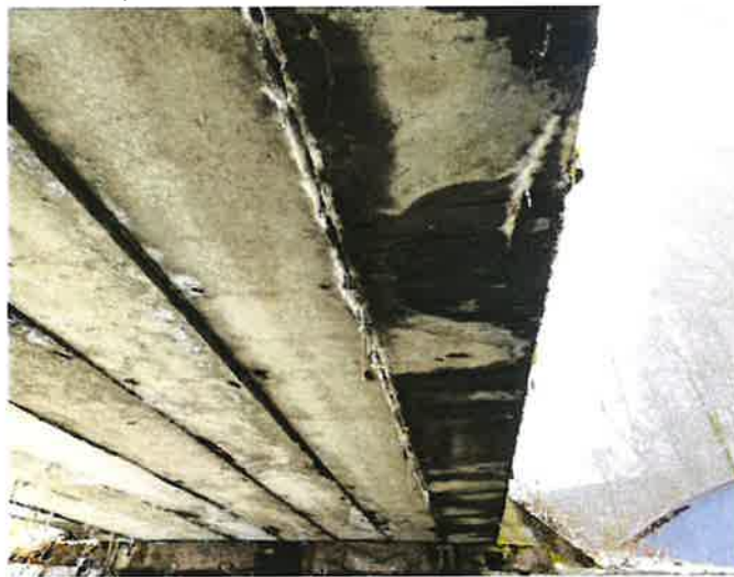
_Podhled pole 3 vpravo
