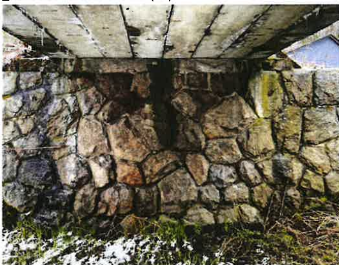
_Pohled na opěru O4
