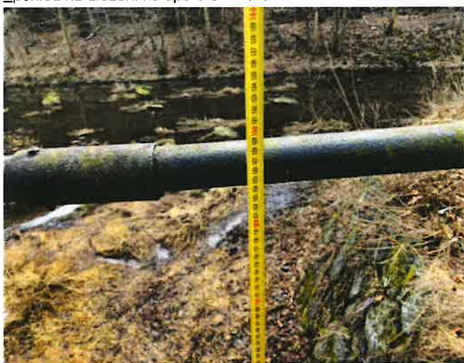
_vlevo ocelové zábradlí výšky 1270mm
