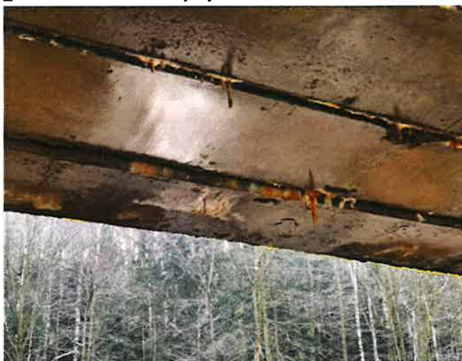
IMG_0269 - deformace jednotlivých nosníků nosné konstrukce pole 2 až 40mm, foto v zatížení pouze vlas
