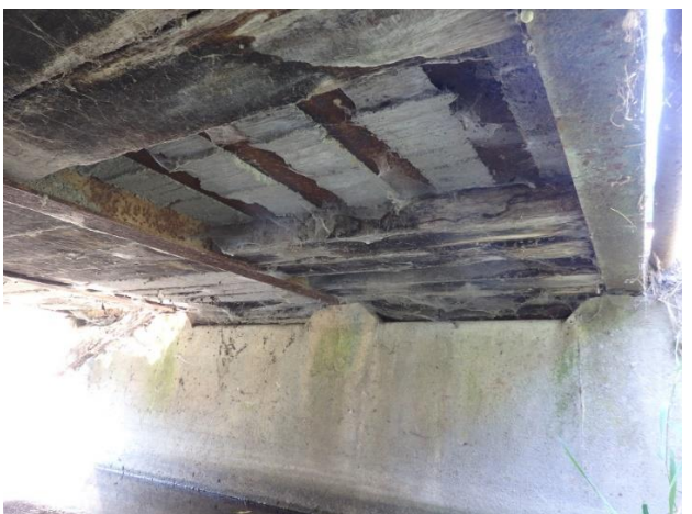
foto 5 druhá opěra, podhled nosné konstrukce
