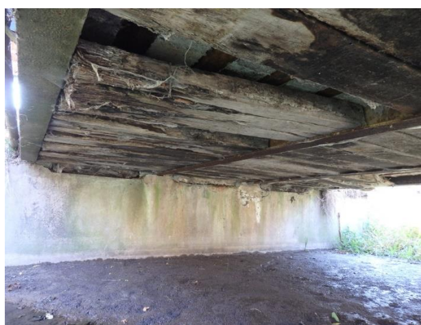
foto 4 první opěra, podhled nosné konstrukce
