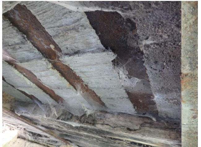
foto 8 nosná konstrukce, koroze
