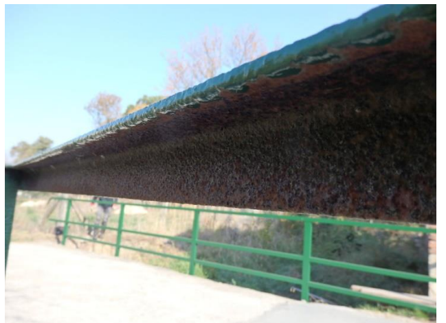
foto 8 nosná konstrukce, koroze
