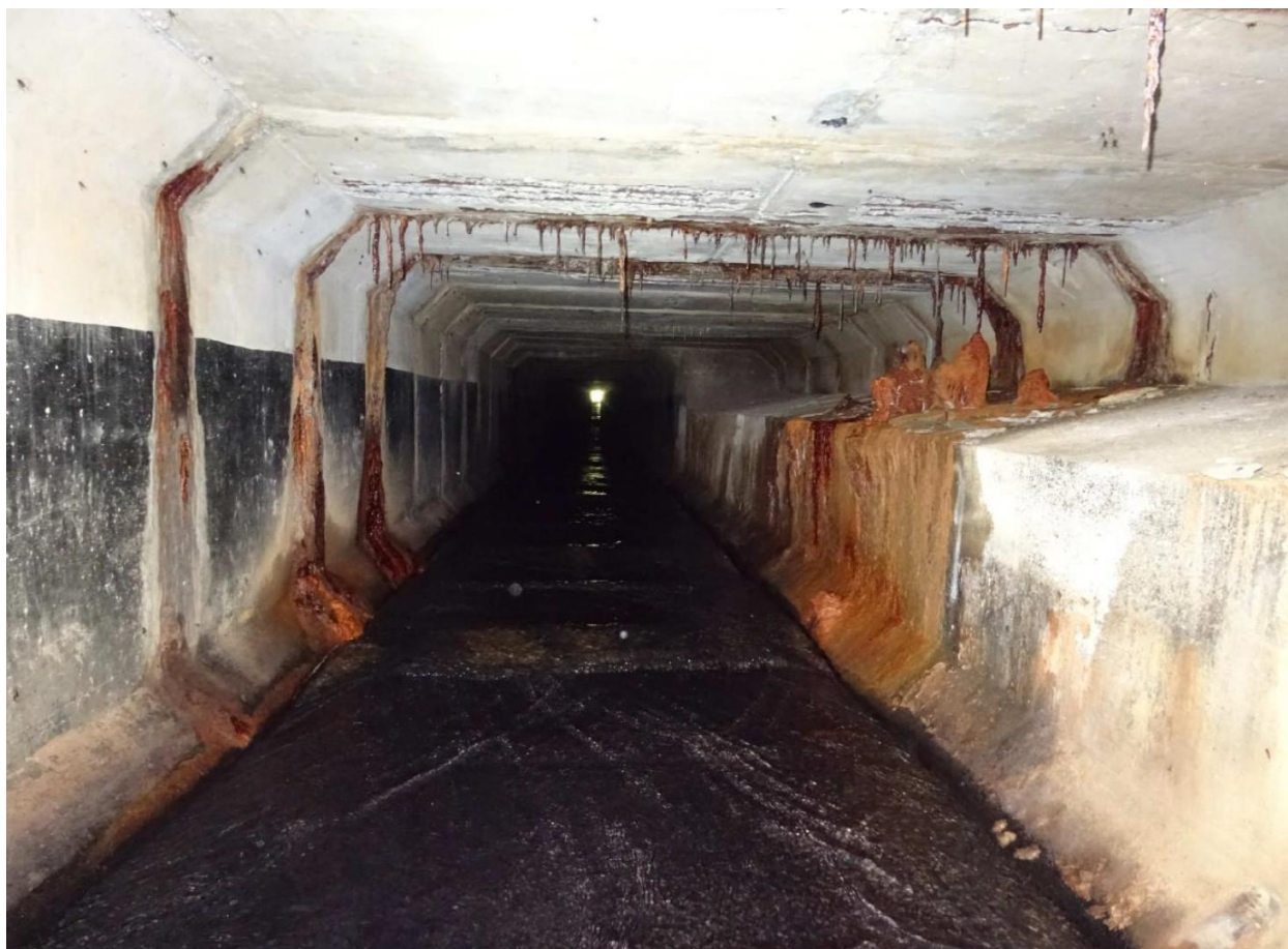
St. 0,220km – Monolitická rámová propust
