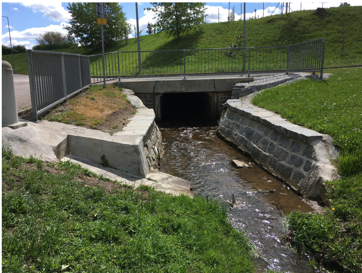
St. 0,020km – Rámová propust Beneš - š. 2,0m
