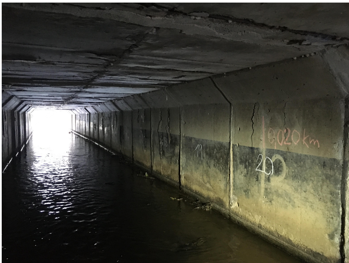
St. 0,020km – Rámová propust Beneš - š. 2,0m
