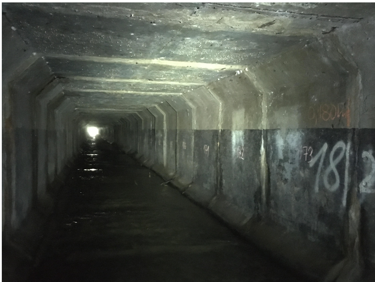
St. 0,208km – Rámová propust Beneš - š. 3,0m + betonová berma
