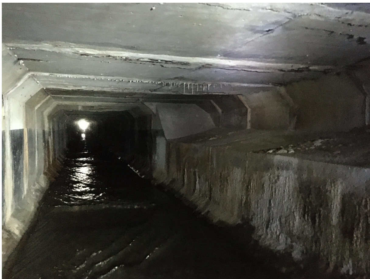
St. 0,208km – Rámová propust Beneš - š. 3,0m + betonová berma
