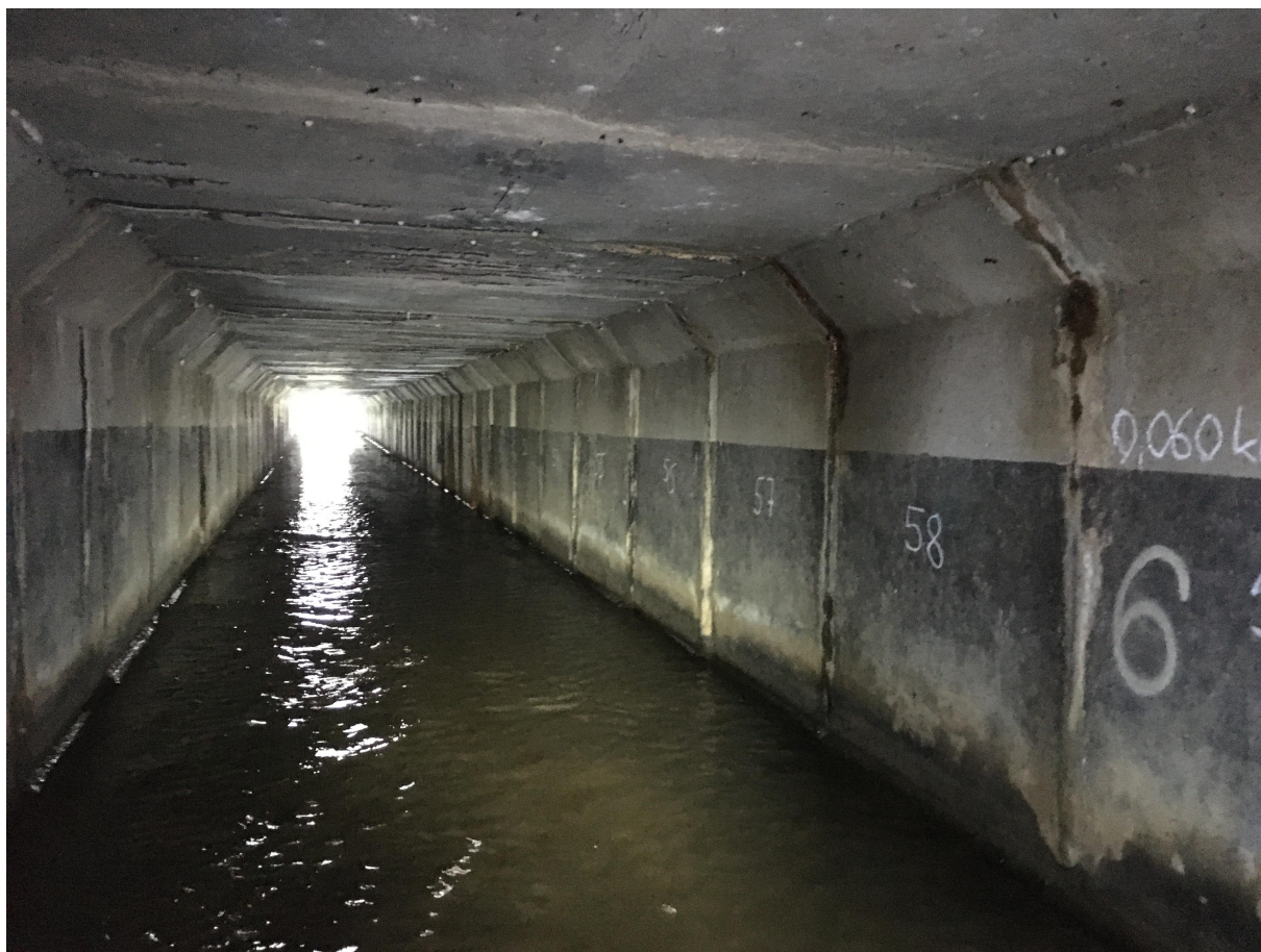
St. 0,125km – Rámová propust Beneš - š. 2,0m
