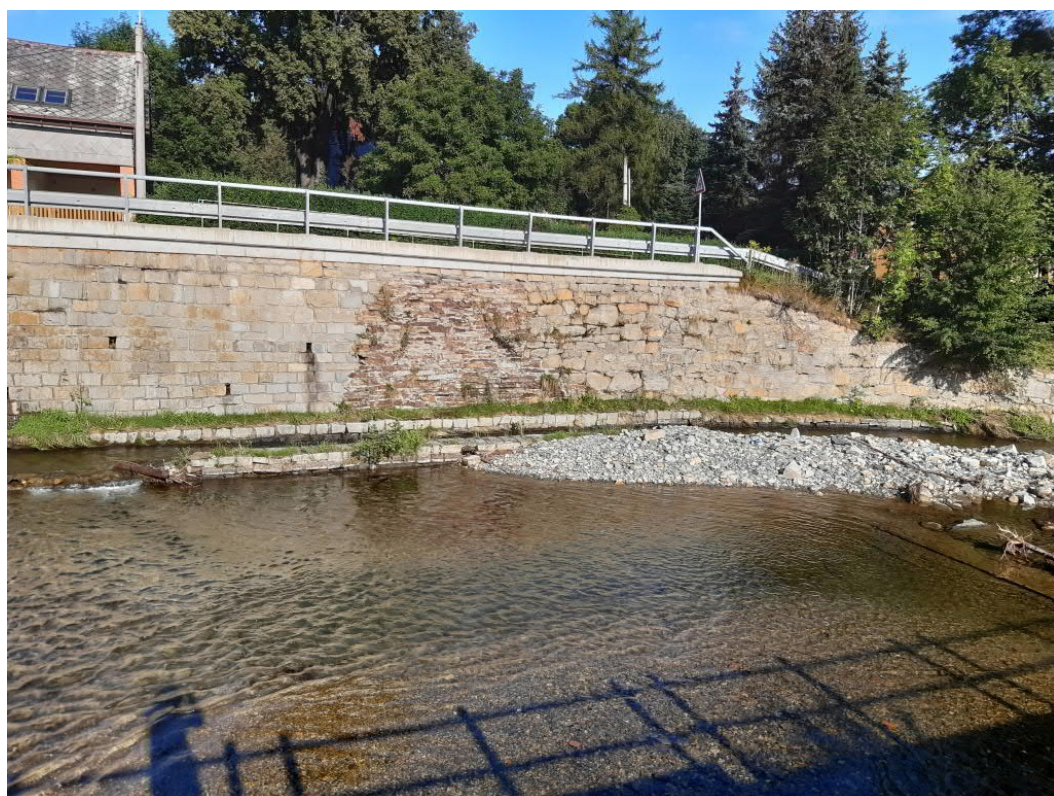
Obr. 7: Nánosy v podjezí – levý břeh
