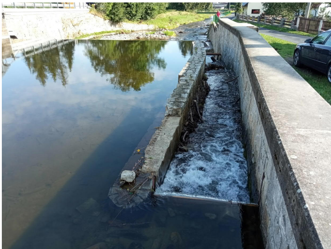
Obr. 2: Dělicí zeď rybochodu v nadjezí – odebrané opevnění koruny zdi
