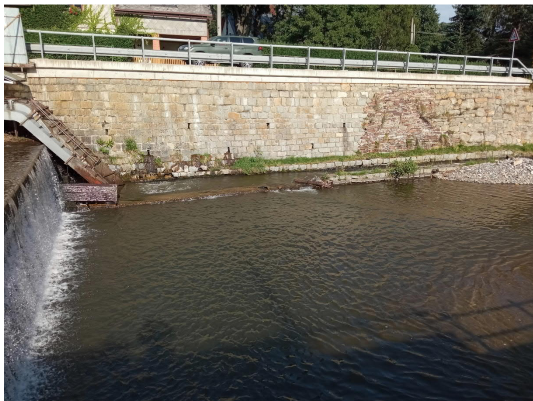
Obr. 5: Odebrané opevnění koruny dělicí zdi mezi vývarem a odpadním korytem MVE v podjezí
