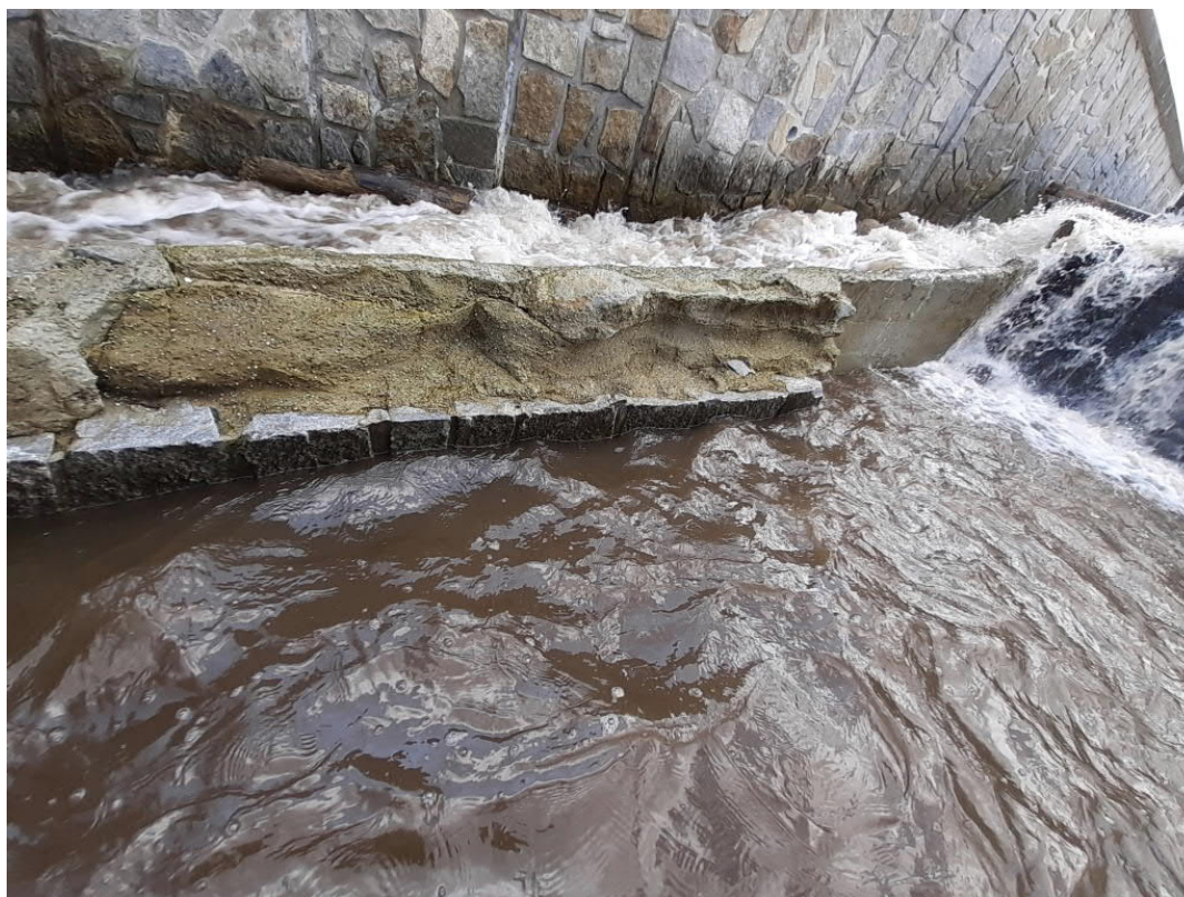
Obr. 4: Destruovaná dělicí zeď rybochodu v podjezí
