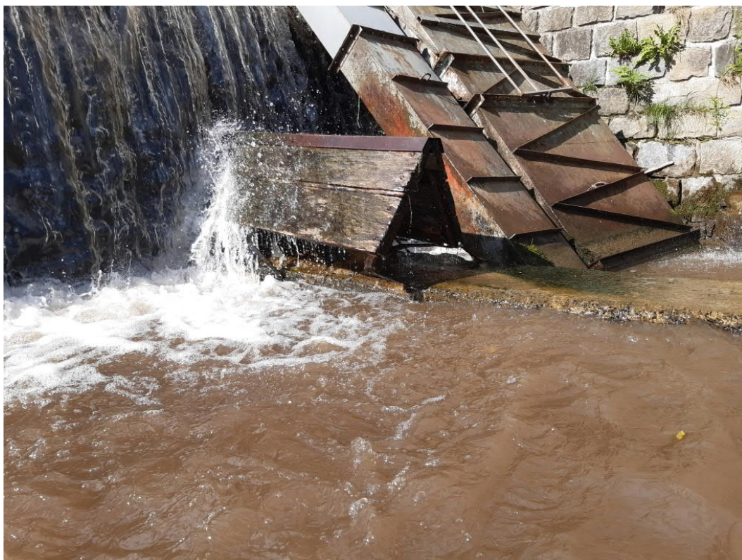
Obr. 8: Rozražeč proudu na dělicí zdi vývaru
