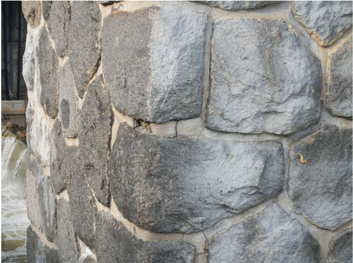
Porušené spárování kamenného obkladu jezových pilířů
