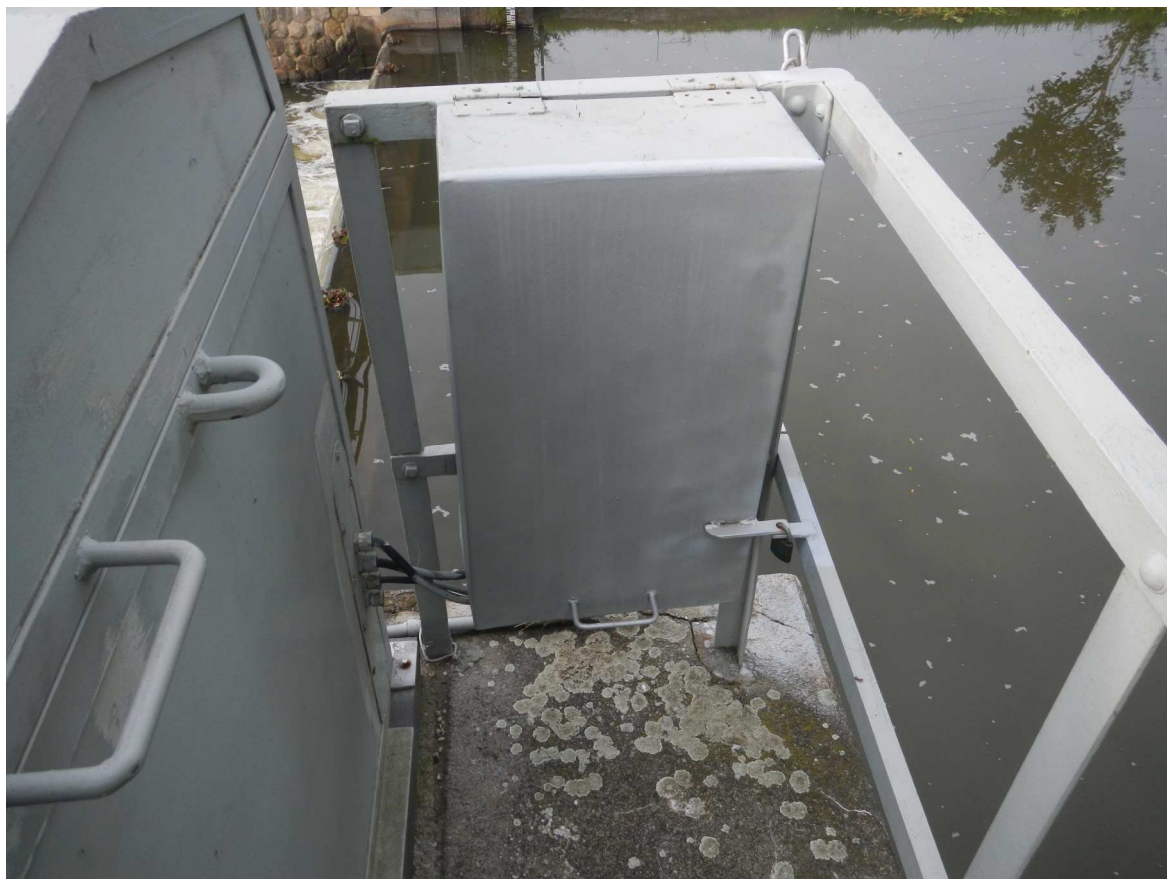
Skříň na levém pilíři s ovládáním pohonů jezu
