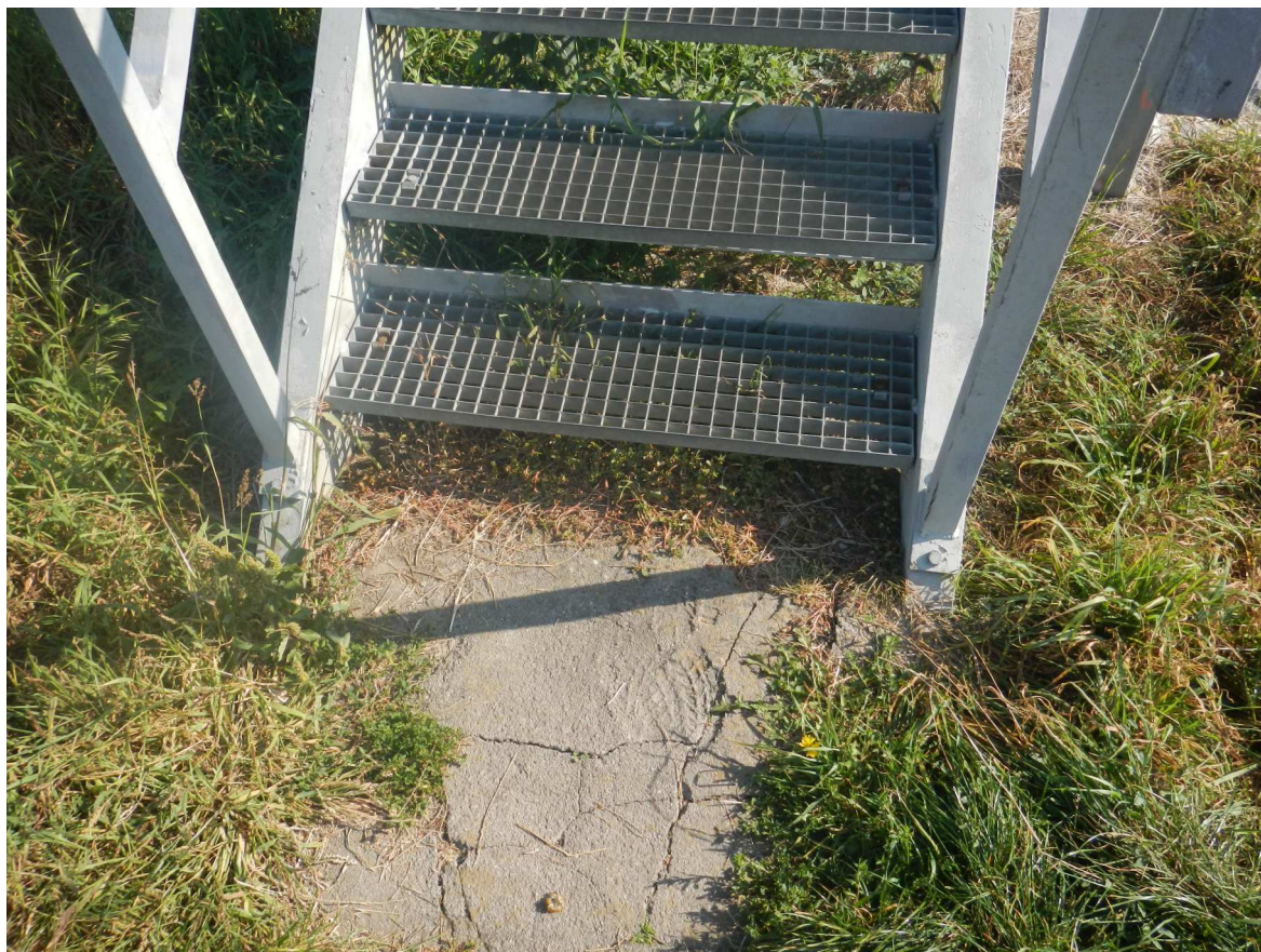
Narušená základová patka schodiště na pravý jezový pilíř
