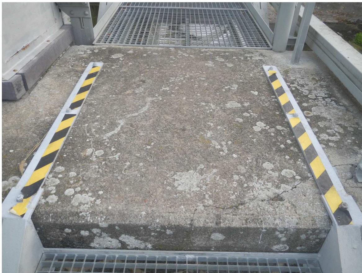
Popraskaný parapet (podesta) jezového pilíře
