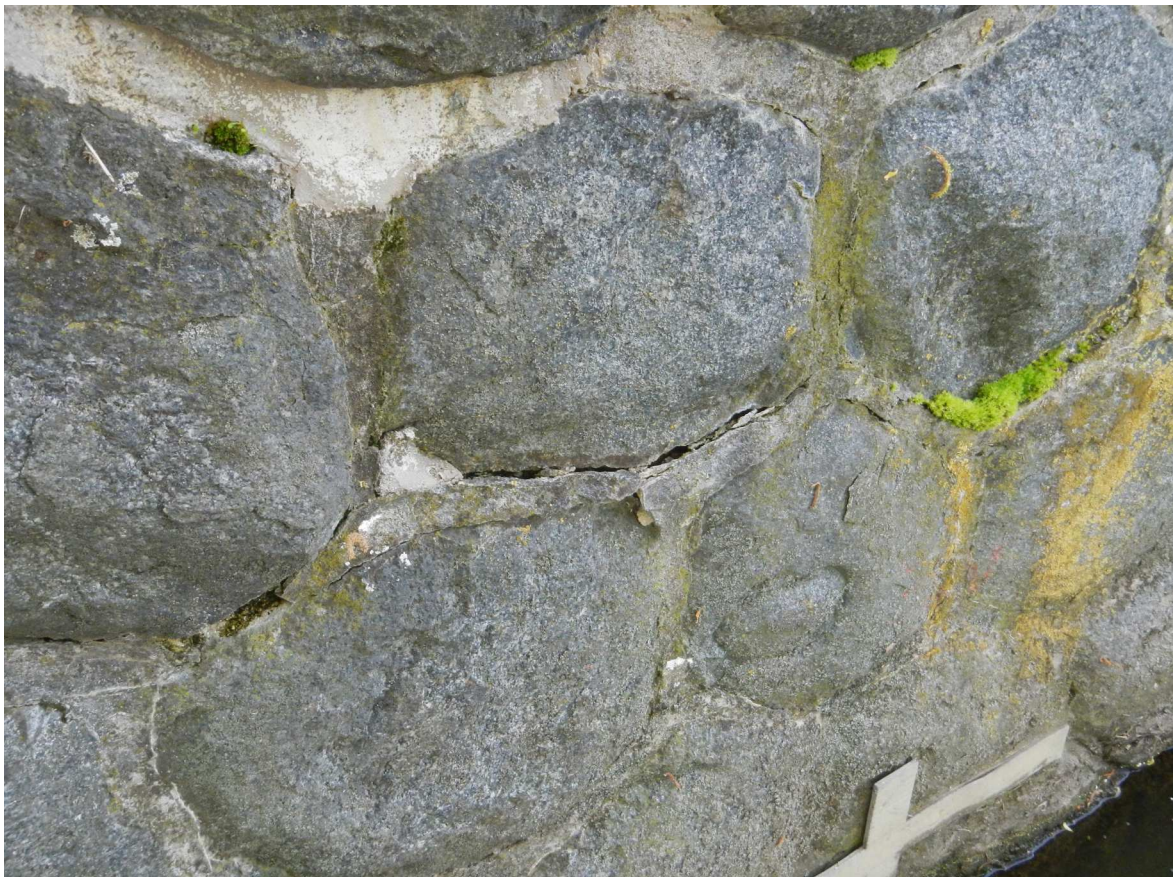
Porušené spárování kamenného obkladu jezových pilířů
