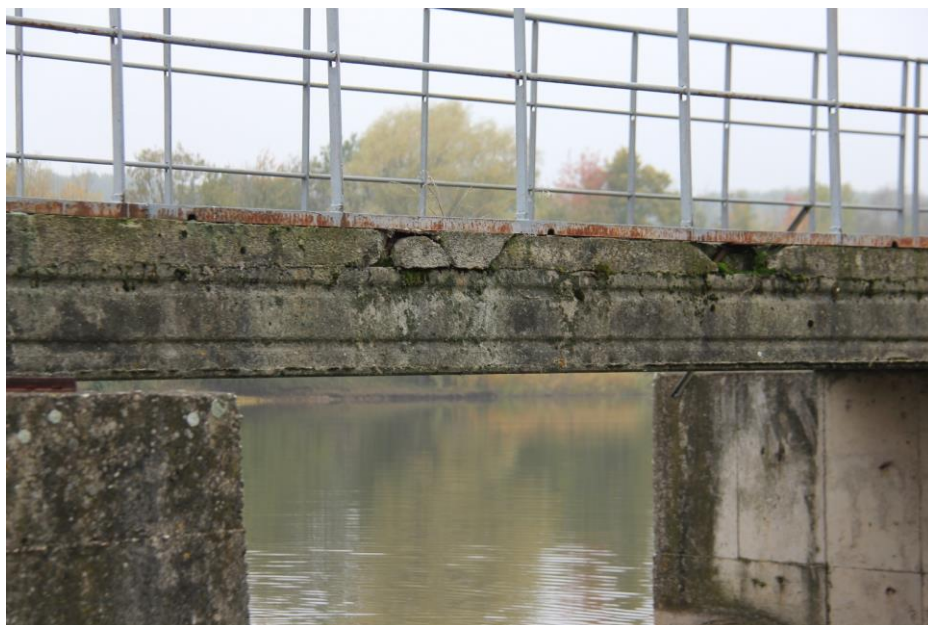
Foto poškození nabetonávky mostní konstrukce mrazovou degradací
