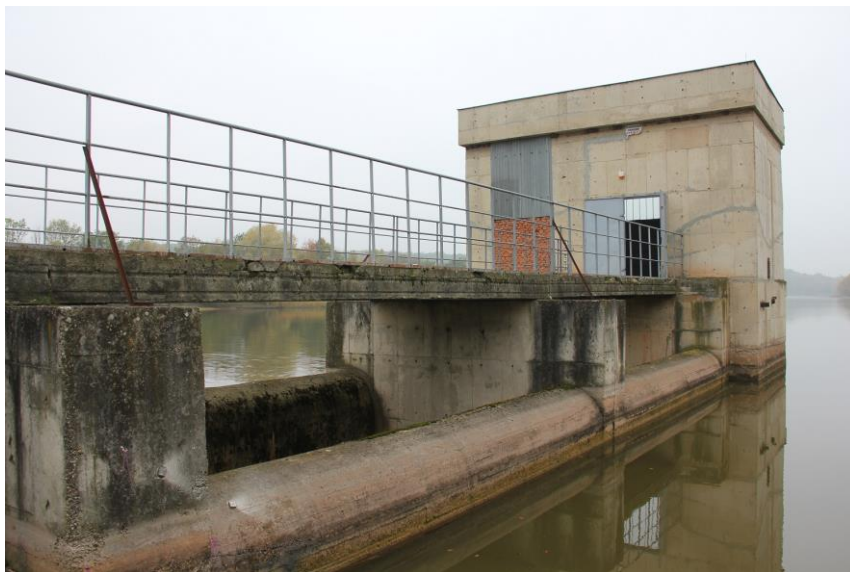
Foto: celkový pohled na přelivná pole bezpečnostního přelivu
