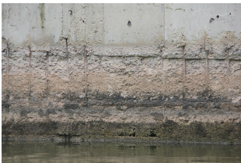
Foto koroze výztuže v oblasti kolísání vodní hladiny – věžový objekt
