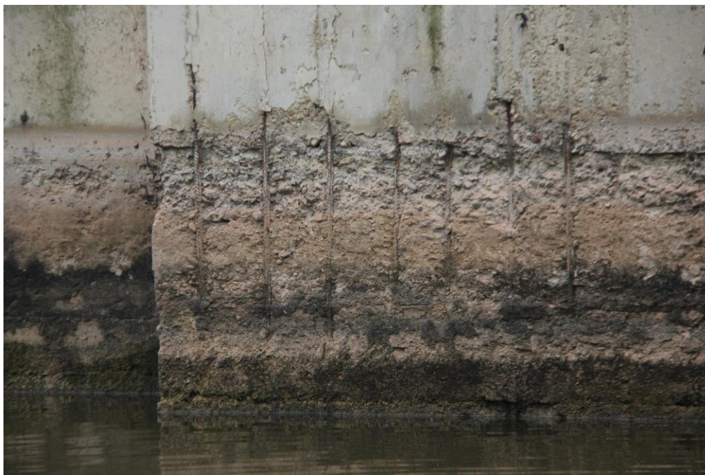
Foto koroze výztuže v oblasti s odpadnutou krycí vrstvou betonu
