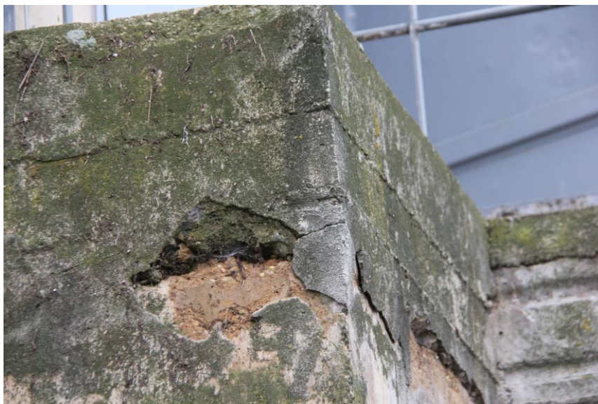
Foto defekty zhlaví stěny, sloužící jako úložný práh mostovky
