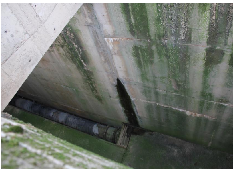
Foto: trhliny a nedotěsněné pracovní spáry na přelivných plochách
