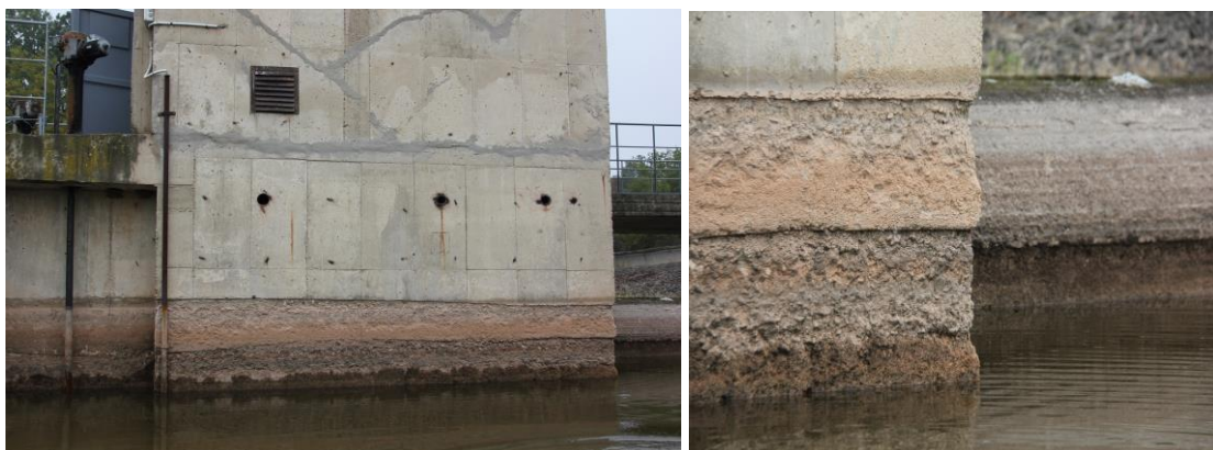
Foto: narušení konstrukce degradací v místě kolísání vodní hladiny
