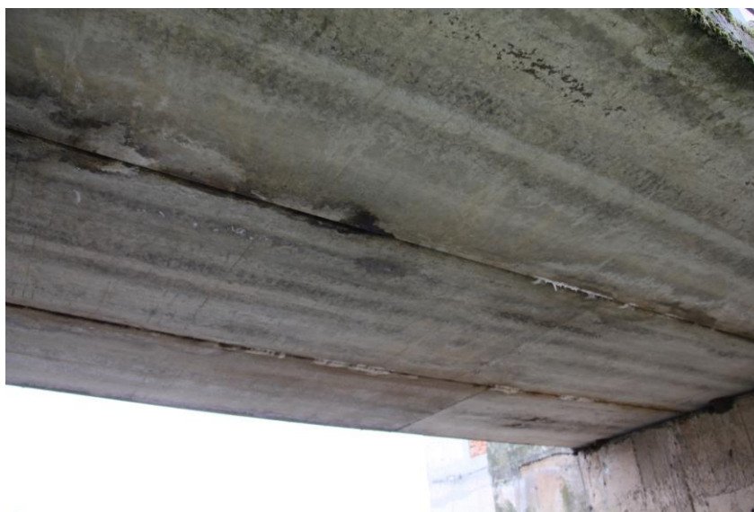
Foto výluhy na spodním líci mostovky – stopy po zatékání do konstrukce
