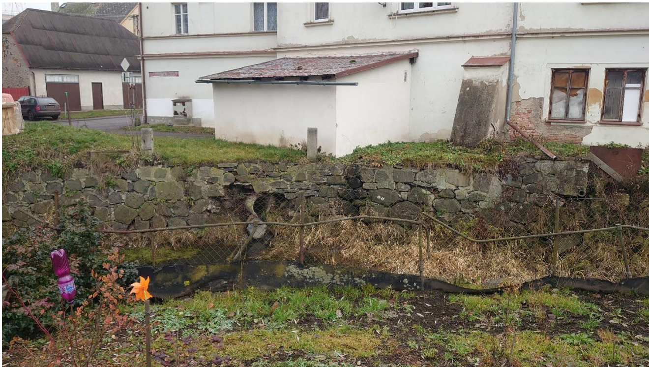
POHLED NA ROZPADAJÍCÍ SE LEVOBŘEŽNÍ ZEĎ U DOMU Č.P. 68:
