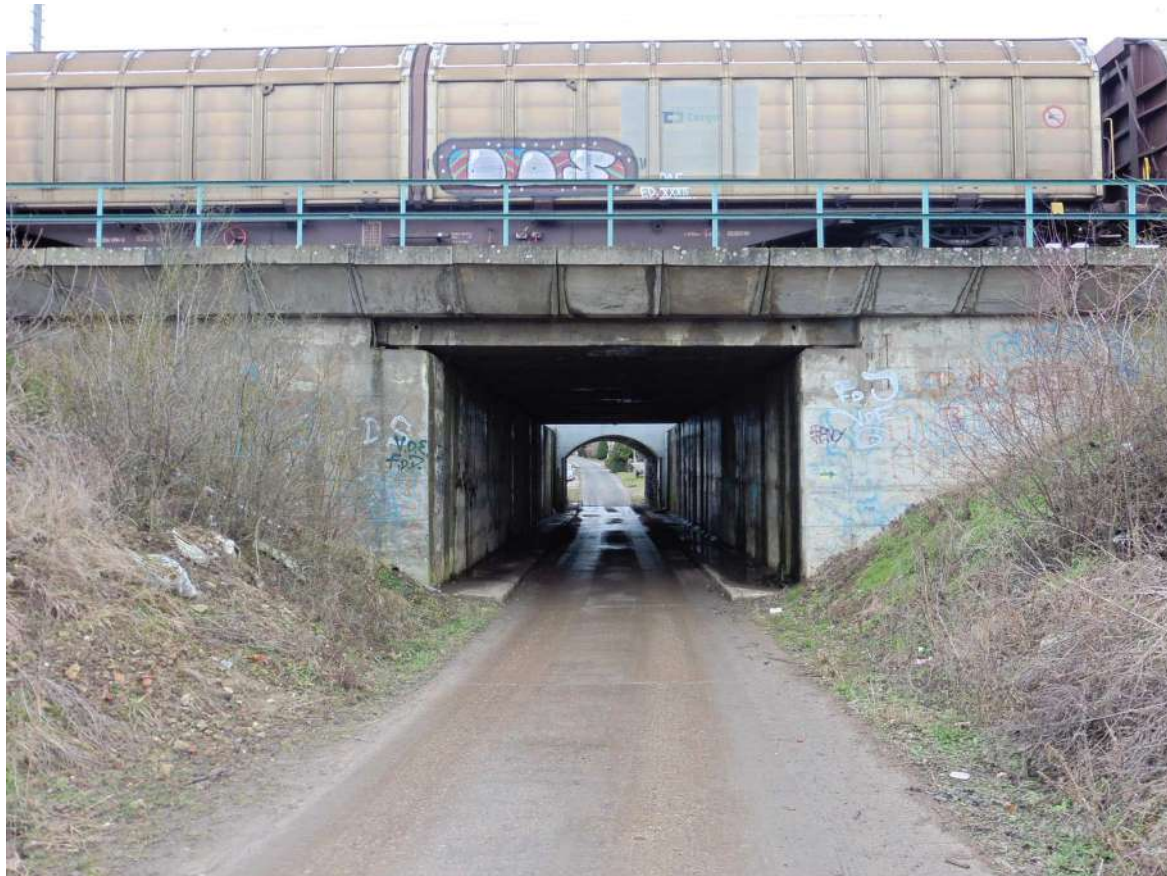
Čelo deskového mostu v místě navrhovaného mobilního protipovodňového hrazení
