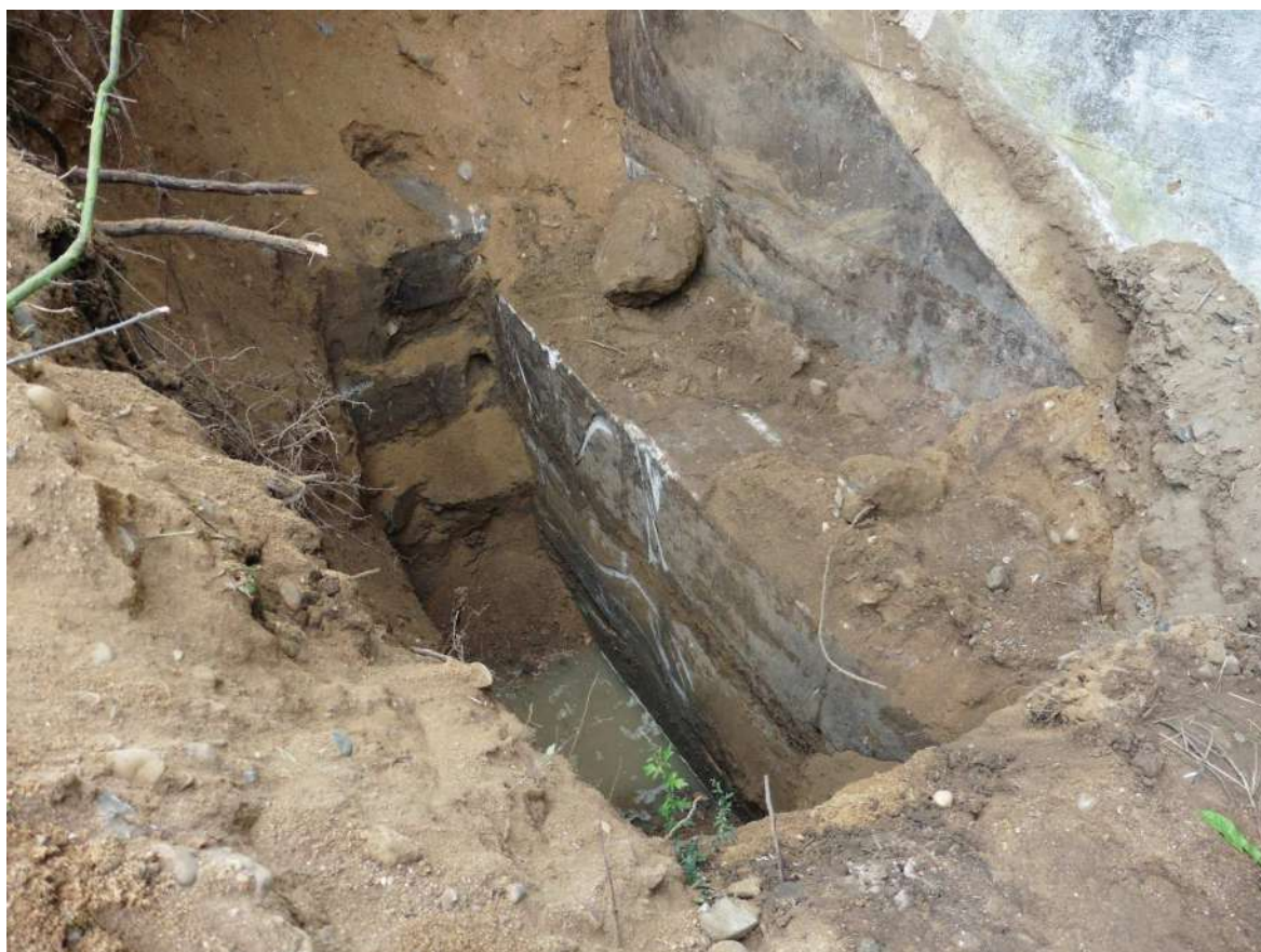
Základy křídla deskového mostu v místě navrhovaných protipovodňových opatření
