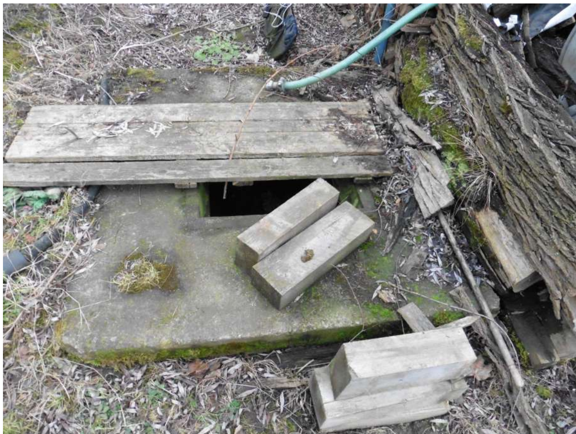
Poškozená kanalizační šachta před klenbovým mostem
