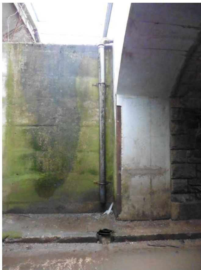
Odvodňovací místo železničního podjezdu (mezi deskovým a klenbovým mostem)
