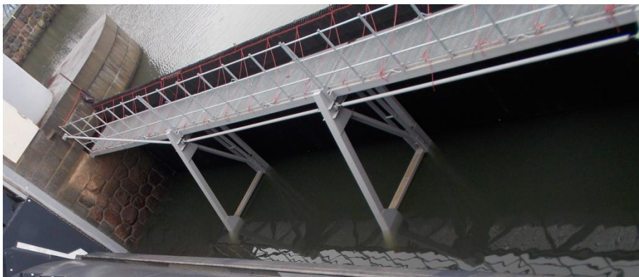
Sada osazeného horního provizorního hrazení
