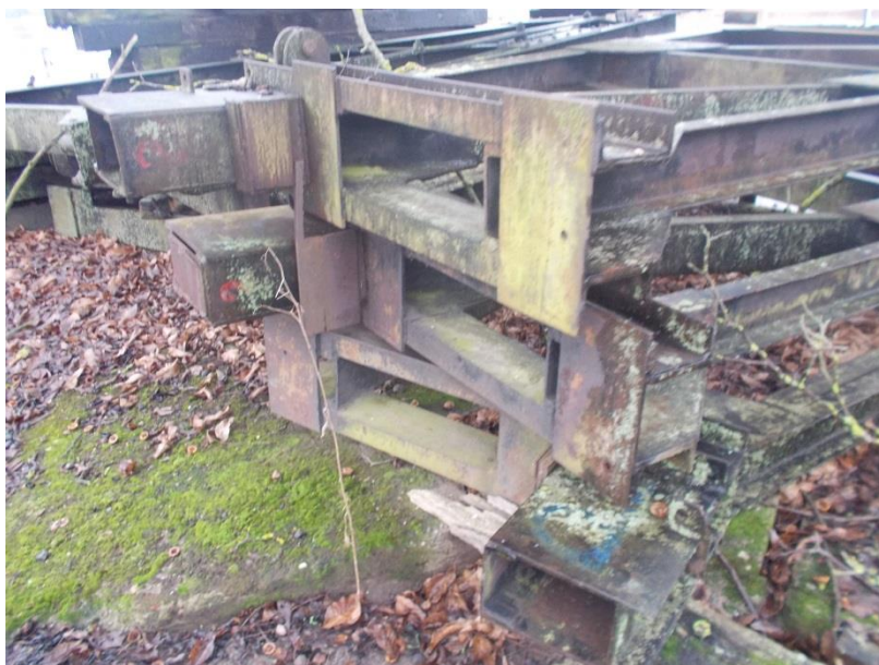
Slupice dolního provizorního hrazení na VD Kostomlátky
