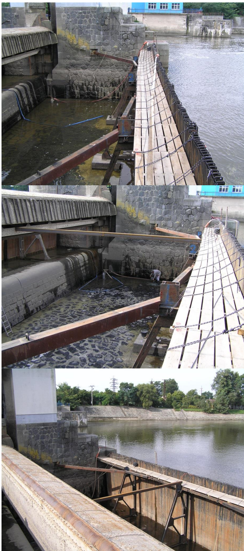
Osazené dolní provizorní hrazení VD Hradištka - stávající
