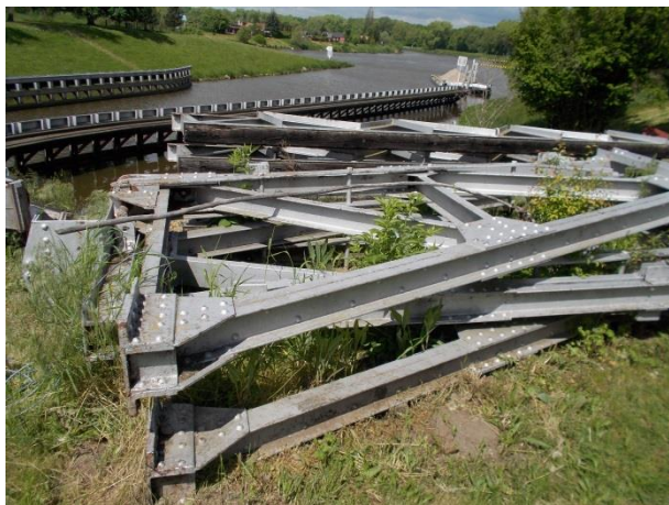
Stávající slupice horního provizorního hrazení
