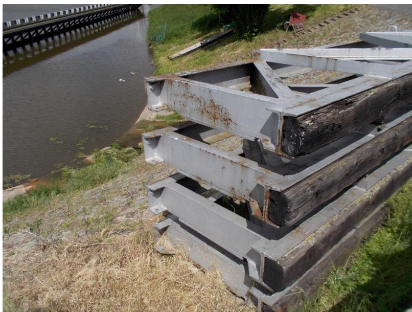
Lávky horního provizorního hrazení na VD Hradištko
