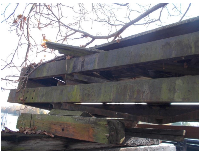
Lávky dolního provizorního hrazení na VD Kostomlátky
