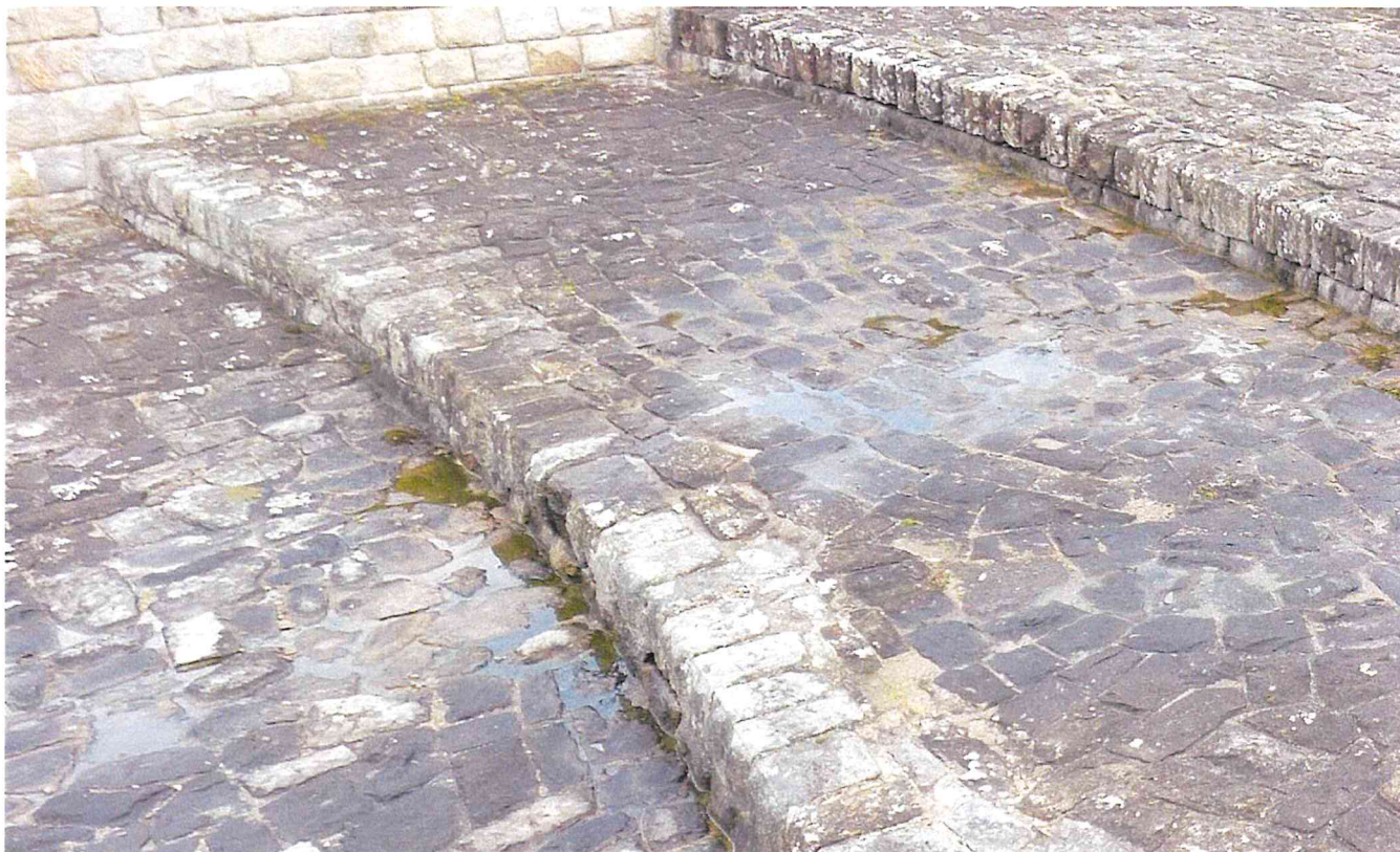
▲ ▼ Průsaky do kaskádového skluz v dolní části
