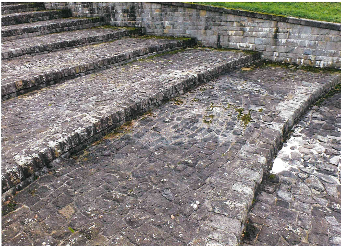
▲ ▼ Průsaky do kaskádového skluz v dolní části
