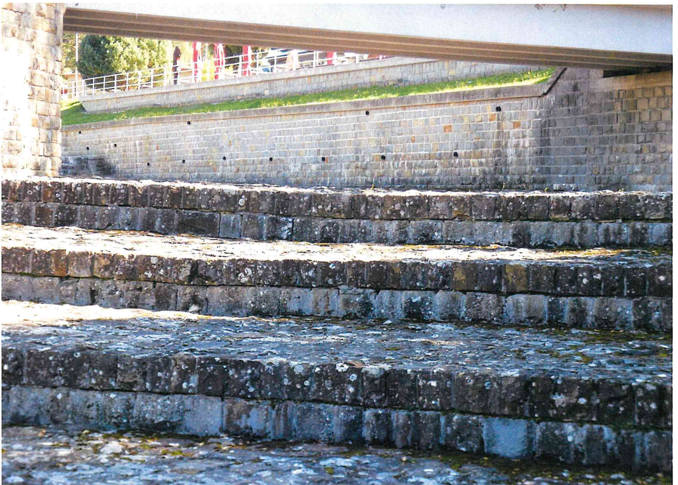
▲ ▼ Kaskádový skluz v horní části
