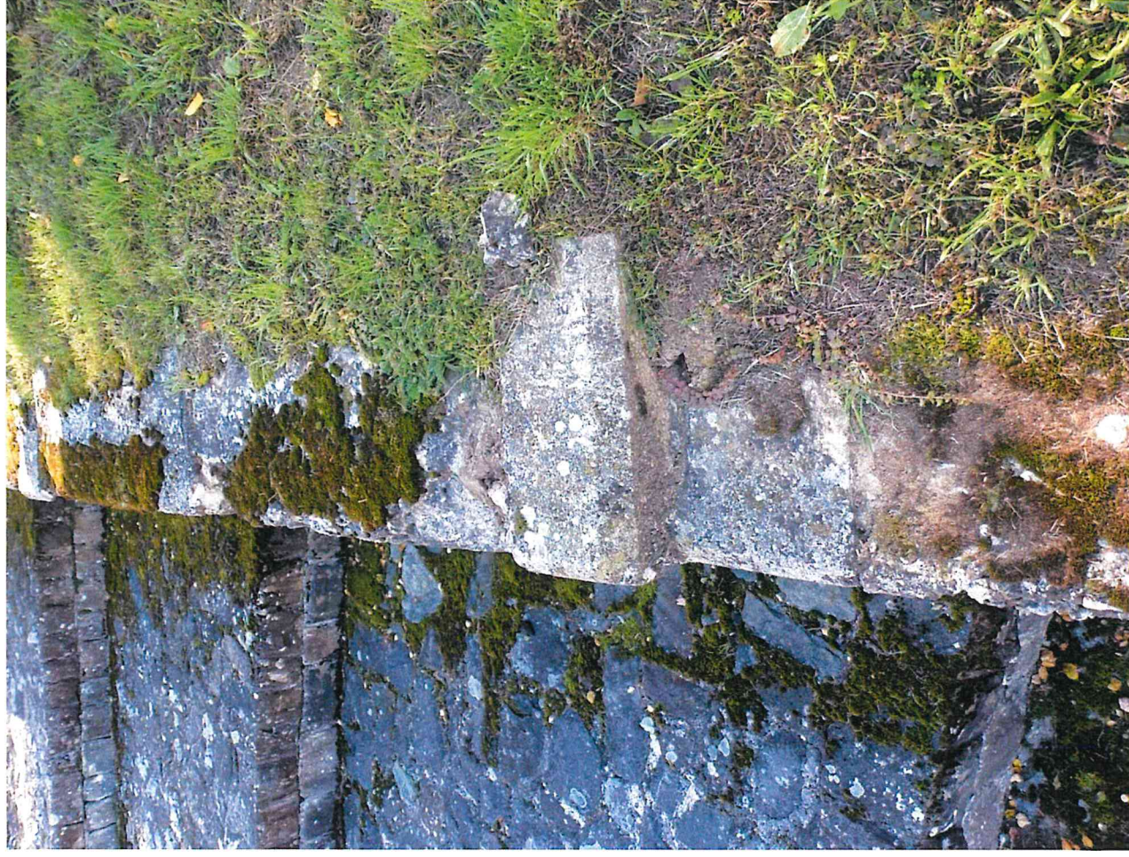
▲ ▲ Betonové římsy bočních zdí skluzu - detaily narušení
