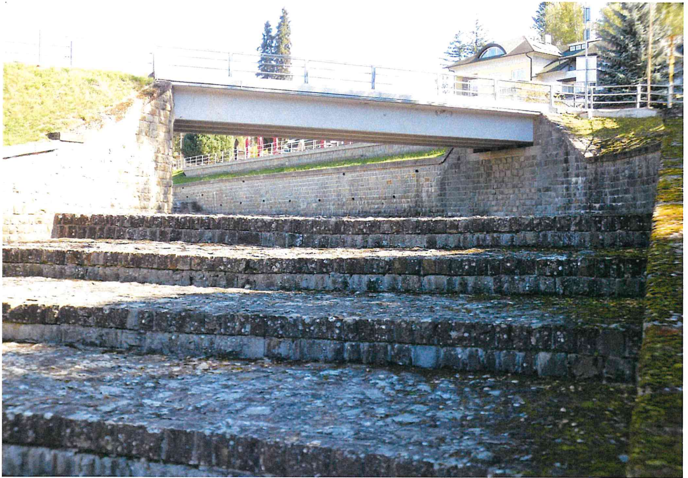
▲ ▼ Kaskádový skluz v horní části
