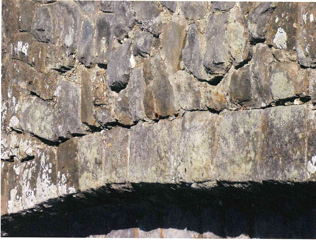
▲ ▲ Kaskádový skluz v dolní části - detaily narušení
