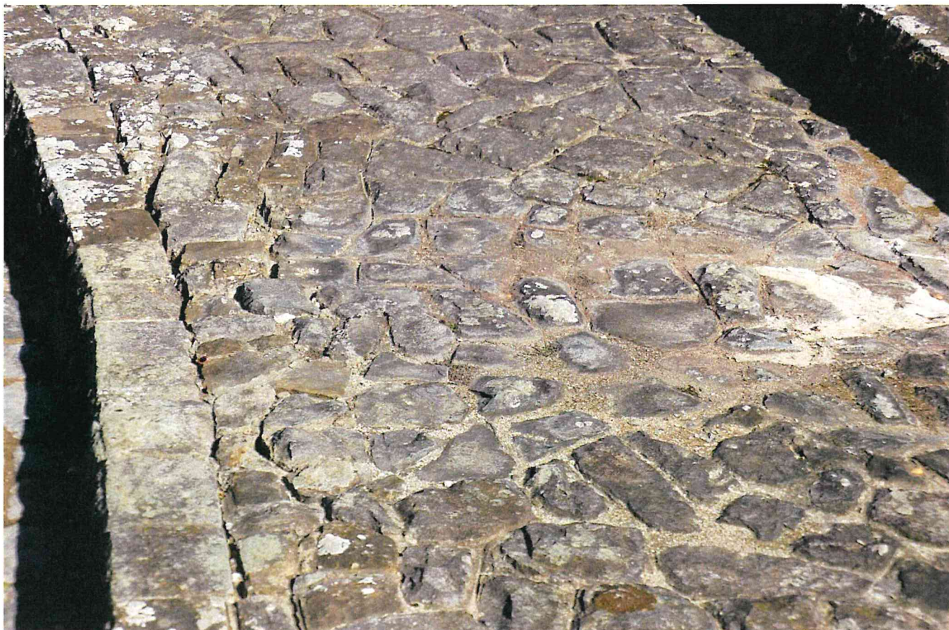
▲ ▼ Kaskádový skluz v dolní části - detaily výnosu materiálu zpod stupňů
