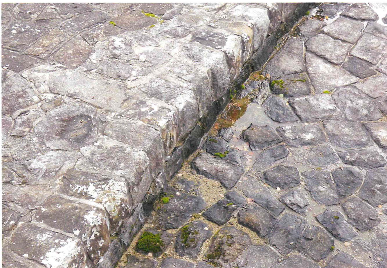
▲ ▼ Kaskádový skluz v dolní části - detaily výnosu materiálu zpod stupňů
