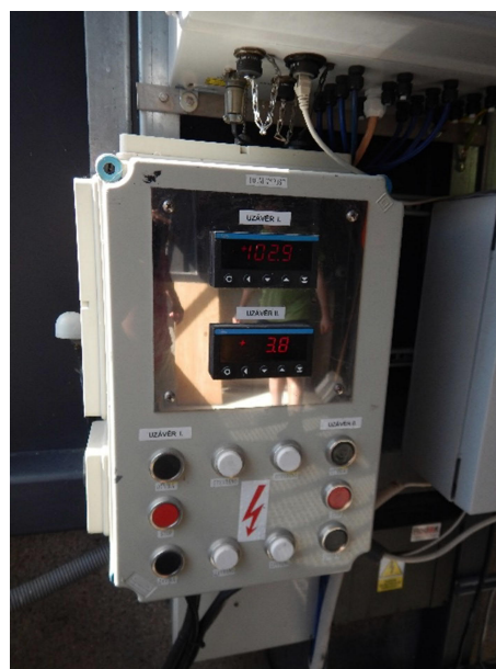
Ovládání uzávěrů SV v horní strojovně
