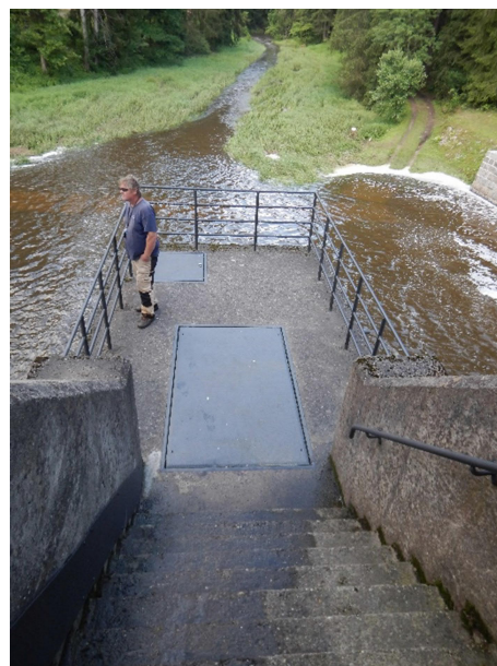
Strop strojovny uzávěrů s e vstupním a montážním poklopem
