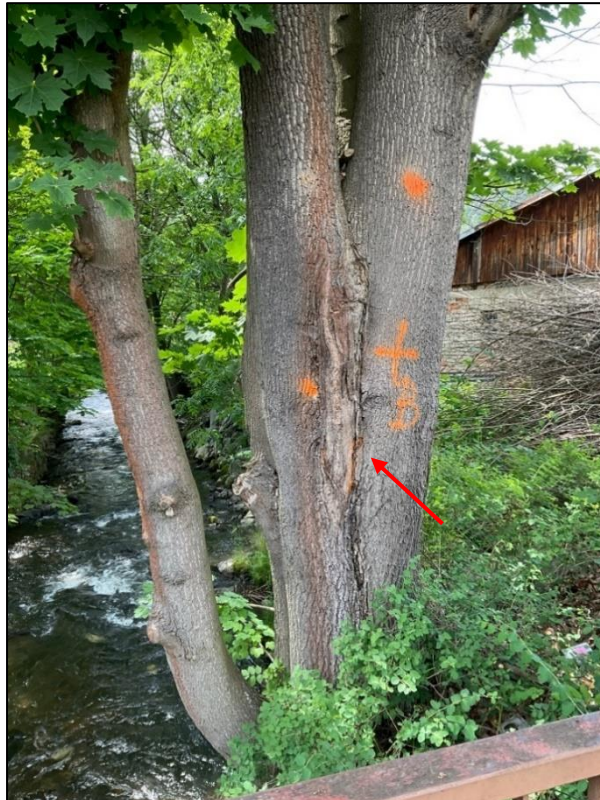
Detail stromu č. 111 – úsek 1 PB
