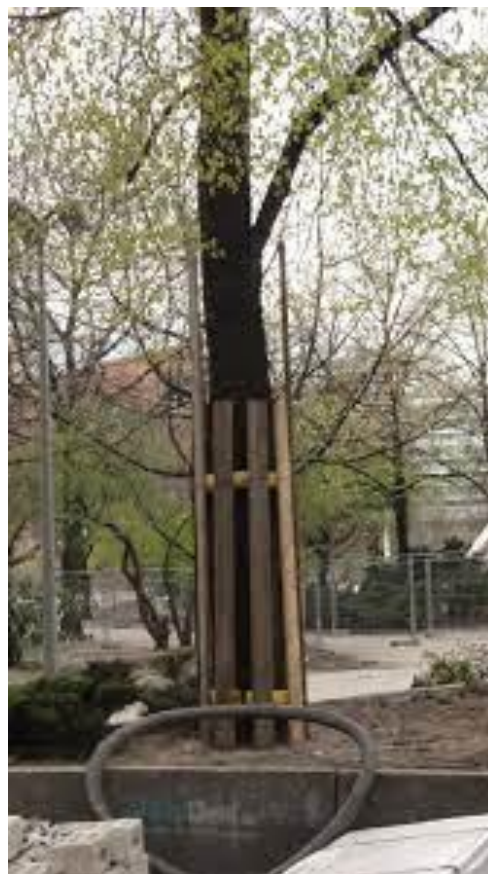
Obrázek 2 - Zobrazení obednění kmenu stromu (zdroj: https://akela.mendelu.cz/~xcepl/inobio/inovace/Zaklady_arboristiky/Stavebni%20cin-nost_komp.pdf )
