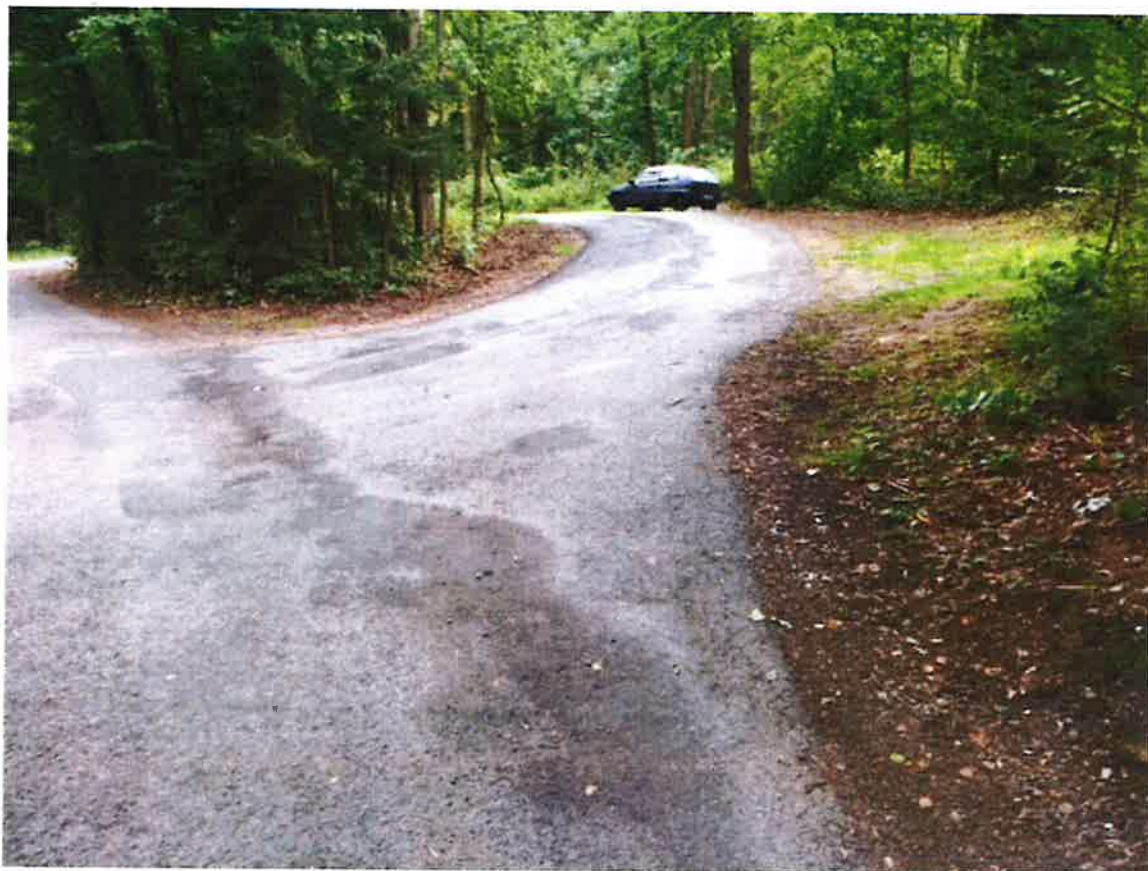
Stávající točna nad silnicí III. třídy
