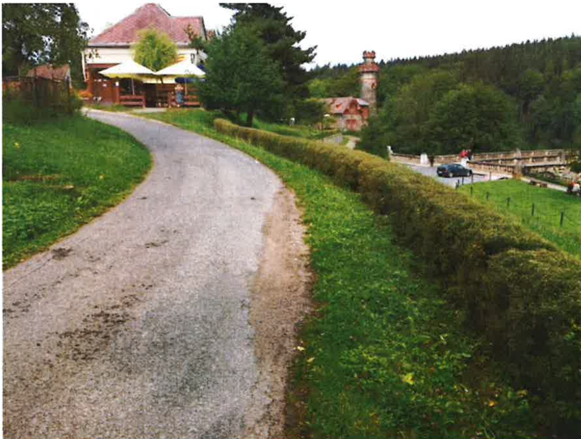
Příjezdová komunikace k provoznímu zázemí VD
