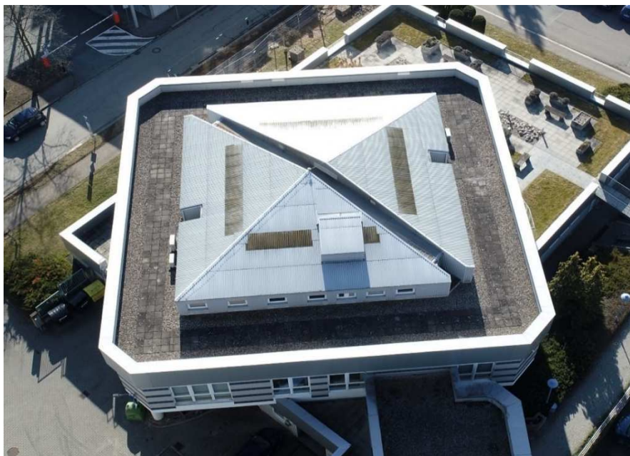
Obrázek 1: Letecký pohled na střechu budovy C.
