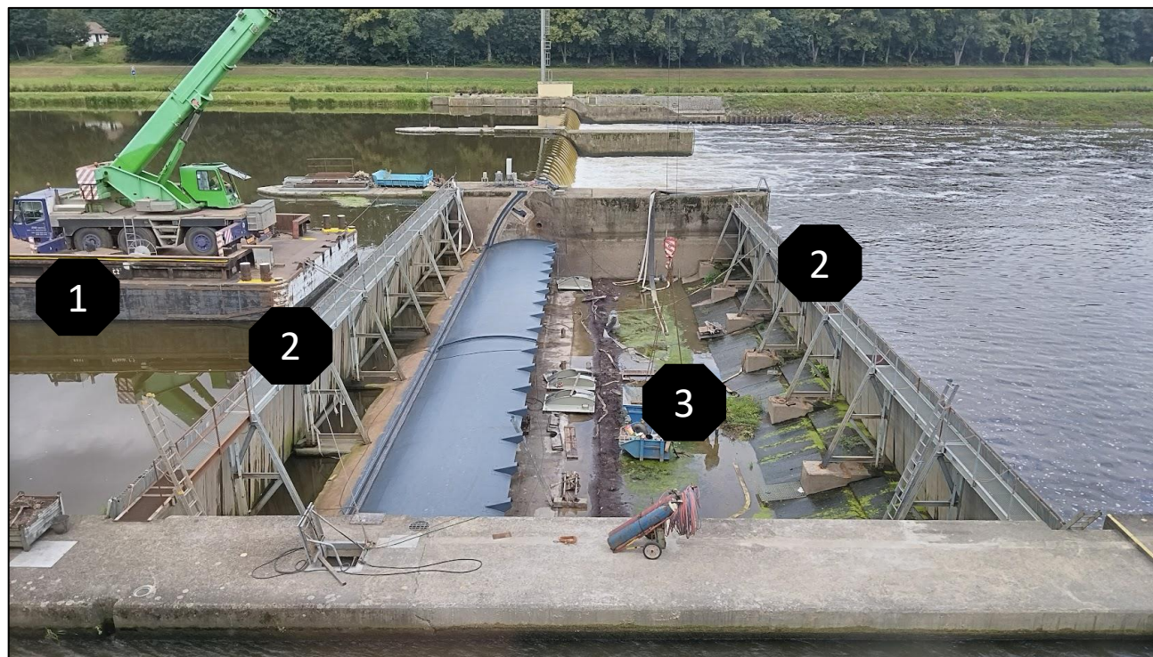
VD Klecany – oprava jezového pole
