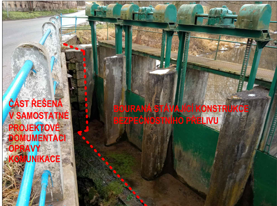
POHLED DO PRAVÉHO ZAVÁZÁNÍ PŘELIVU
