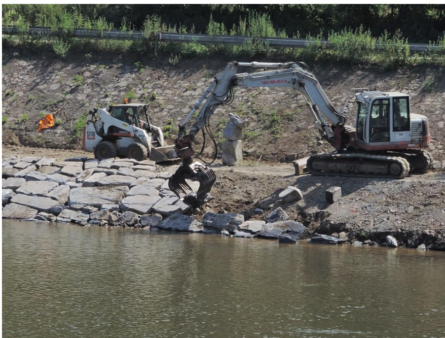
Pokládka strojně rovnané dlažby. Místo na záhozovou patku se osazují spodní kameny do rýhy u paty svahu. Pod silnicí je svah opevněn dlažbou z lomového kamene nasucho, která byla dost pravděpodobně položena na počátku 20. století
