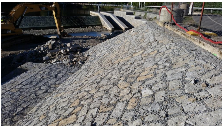
Dlažba nasucho – víceméně správná skladba (občas se vyskytují křížové spáry), spáry vyplněny drceným kamenivem
