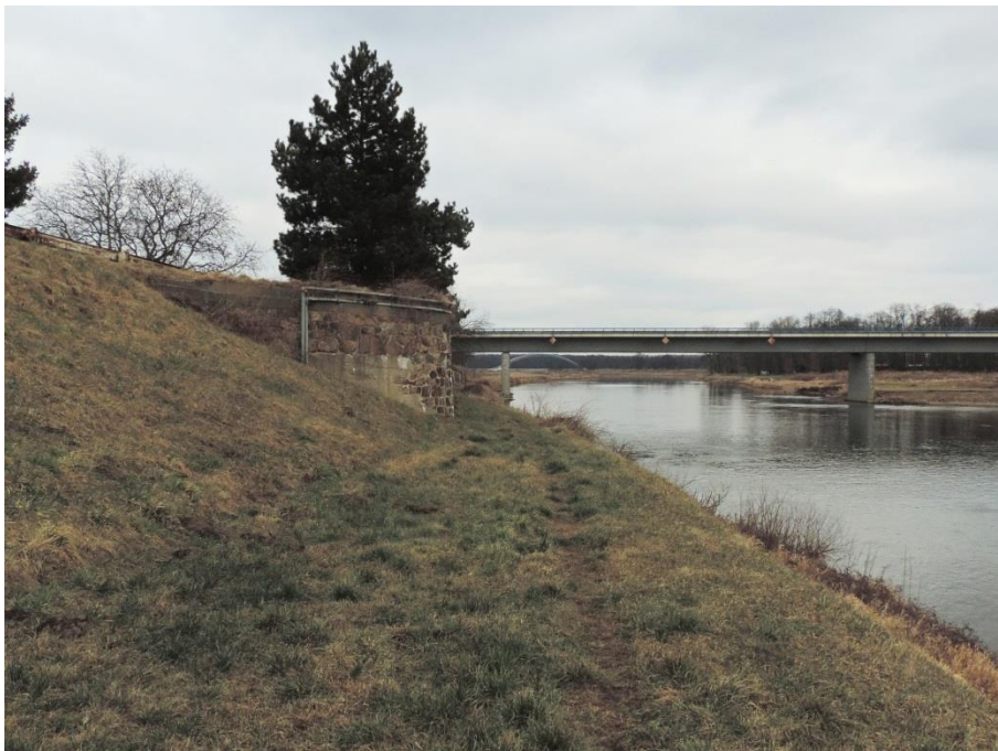
Dlažba z lomového kamene nasucho , stáří asi 90 let. Na dlažbě leží cca 30 cm tlustá vrstva jemnozrnného sedimentu (bylo ověřeno pedologickou sondou), který ji velmi účinně chrání před účinky velkých vod.
