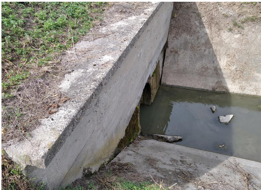
Obr. 3 Stávající výtokové čelo
