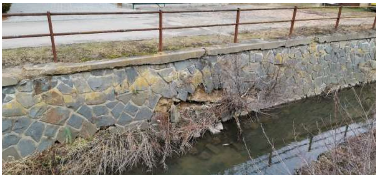
Obrázek 24: Stabilizační zdi nad mostem – kaverna na PB
