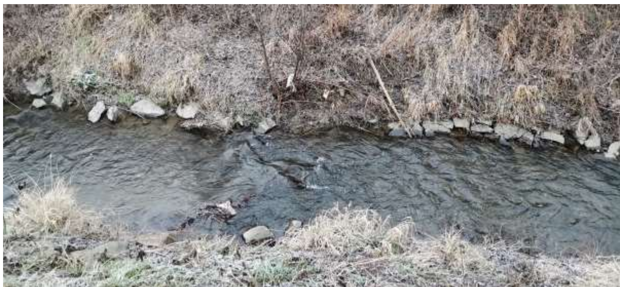
Obrázek 4: Původní opevnění z kamene v patě svahu
