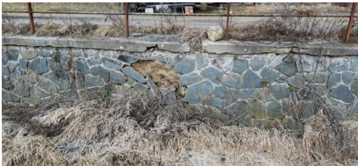
Obrázek 17: Stabilizační zdi nad mostem – začínající kaverna na PB
