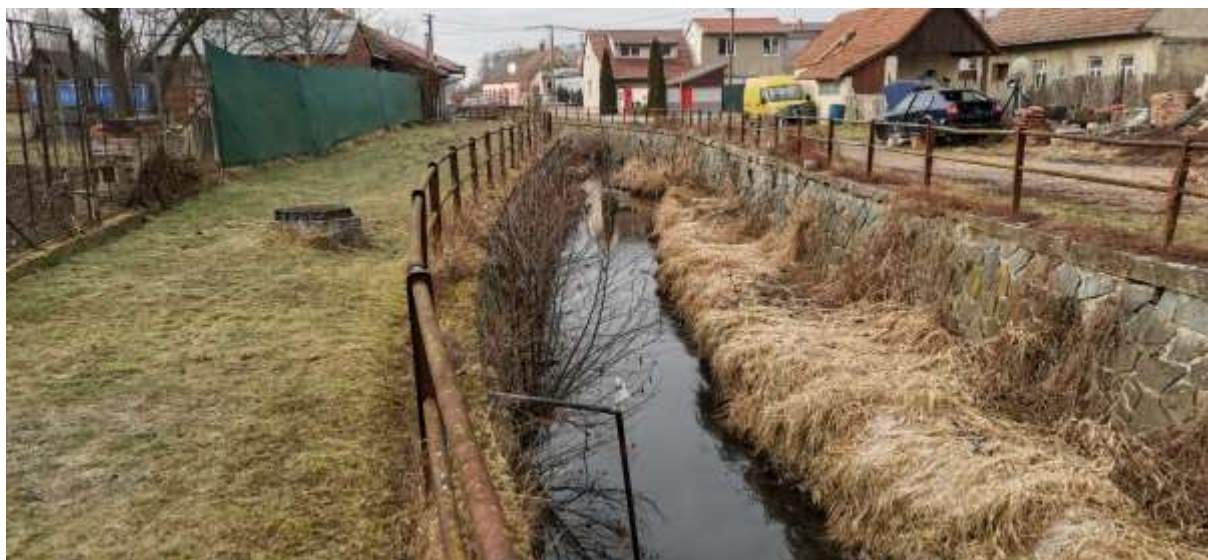
Obrázek 16: Upravené koryto nad mostem – kanalizace v souběhu (LB)
