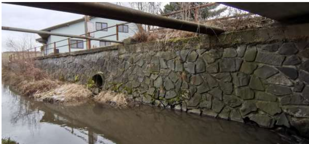
Obrázek 32: Přítok kanalizace na LB, DN 800 mm
