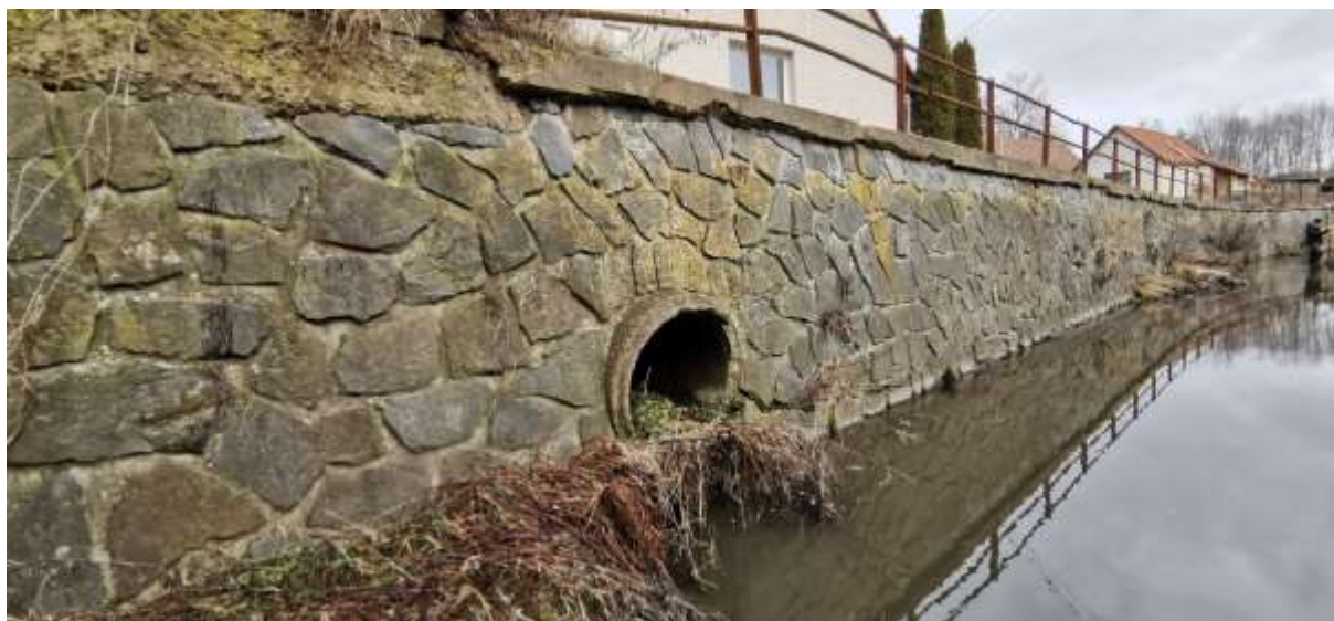
Obrázek 31: Přítok kanalizace na PB, DN 800 mm
