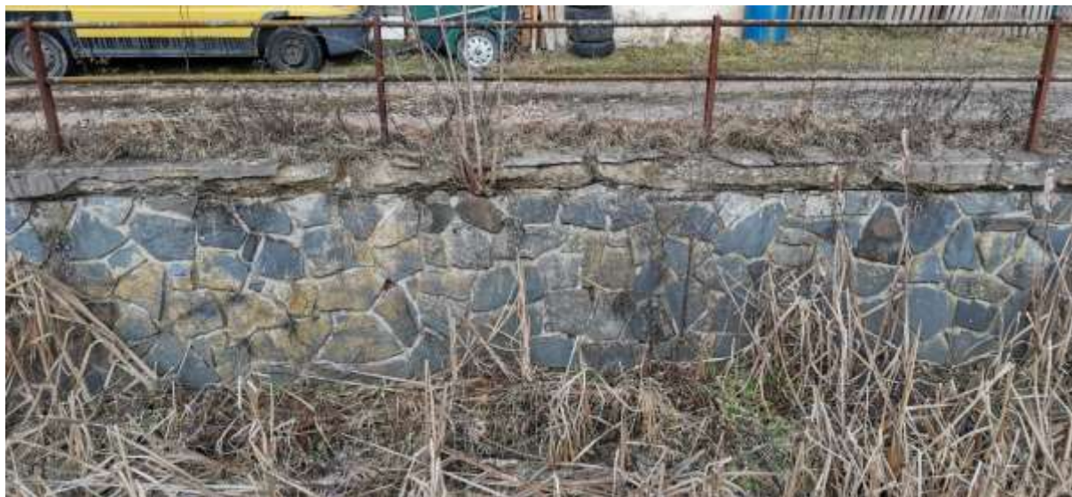
Obrázek 20: Stabilizační zdi nad mostem – rozpadlá římsa na PB
