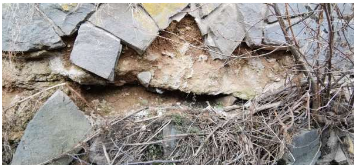
Obrázek 33: Detail kaverny ve zdi
