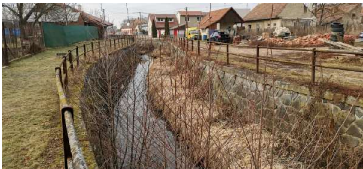
Obrázek 15: Upravené koryto nad mostem – kanalizace v souběhu (LB)
