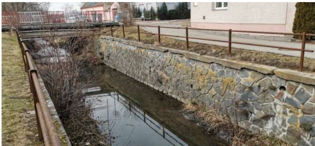
Obrázek 23: Stabilizační zdi nad mostem
