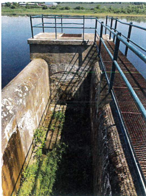
Foto č.1 - celkový pohled na výpustní kanál směřem na stěnu výpustní šachty
