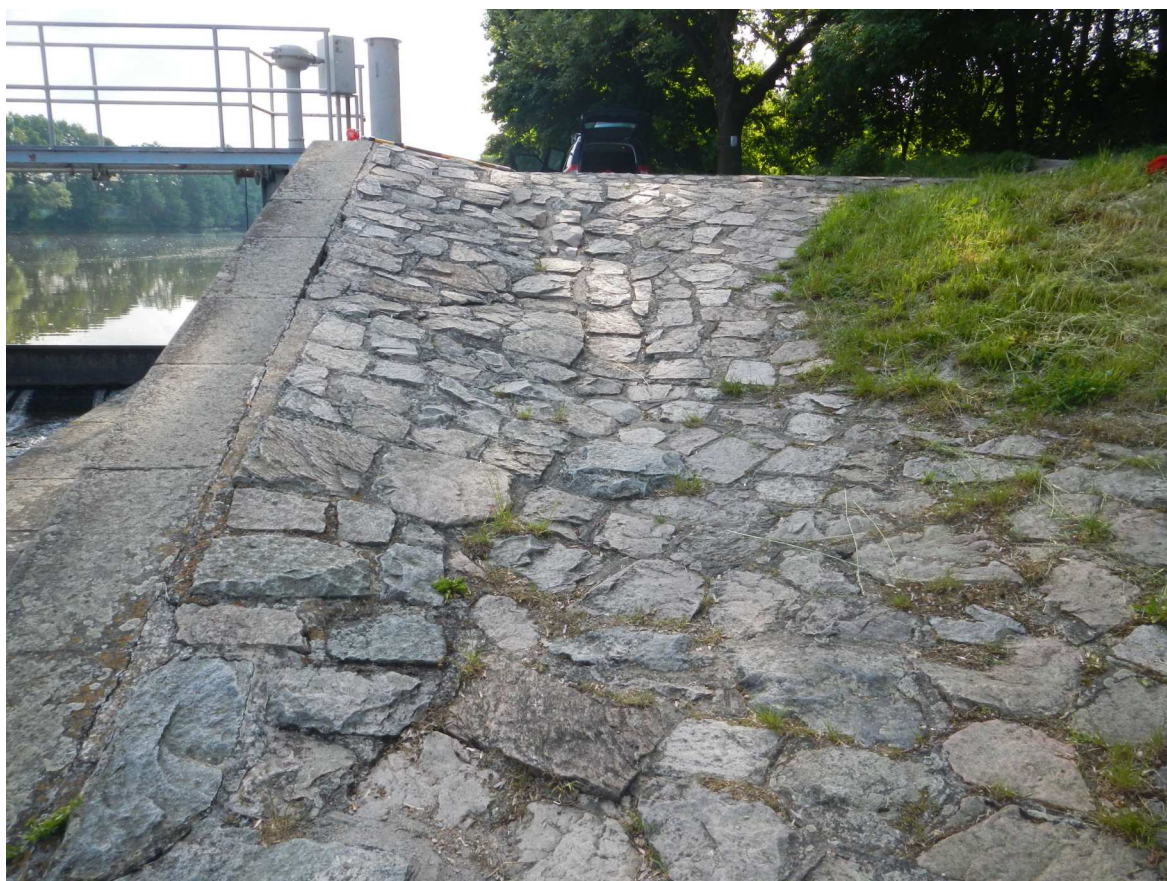
Propadlá kamenná dlažba LB opevnění
