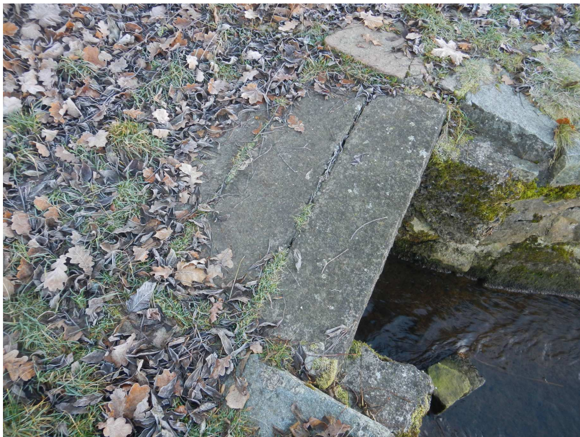
Zákrytové PZD desky nad vyústěním ze slepých ramen
