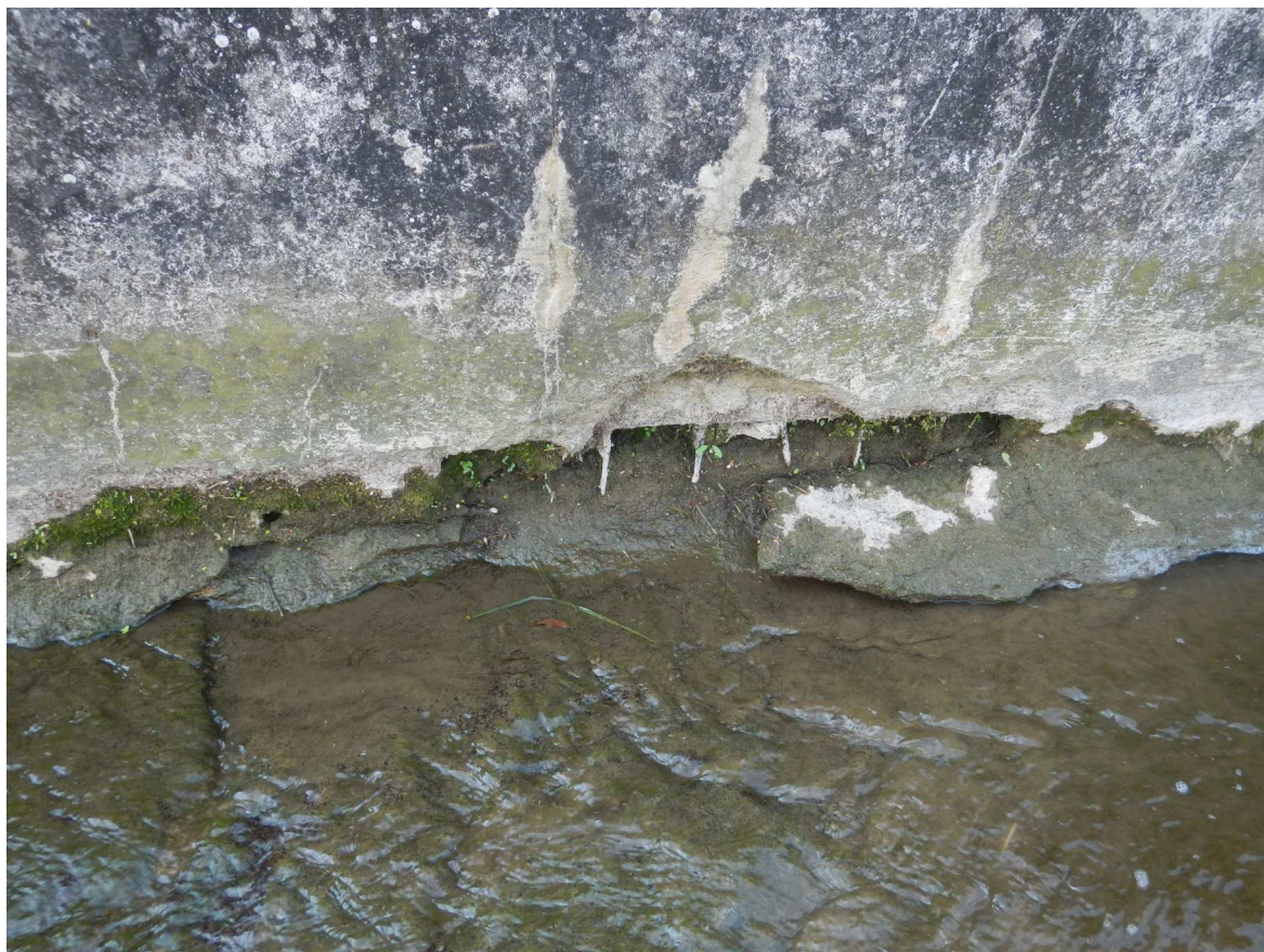
Detail poškozené paty vorové propusti
