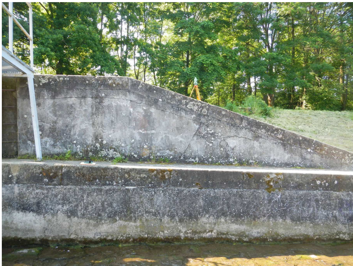
Degradovaný betonový líc pilíře nad vorovou propustí
