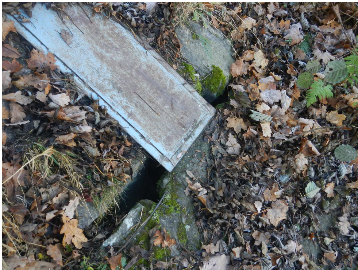
Otevřená spára nad zákrytovými PZD deskami
