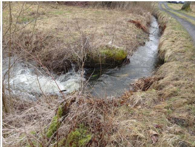
pohled proti proudu: vpravo obecní cesta, v popředí spádový stupeň a prudká změna směru koryta
