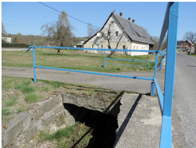
pohled po proudu: vtok do profilu mostku č. 5, jehož mostovka je pravděp. tvořena žulovými kvádry, v pozadí č.p. 193
