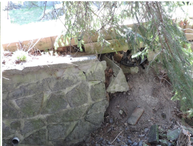
pohled na JZ konec PB zdi – sesunutě zavazovací křídlo
