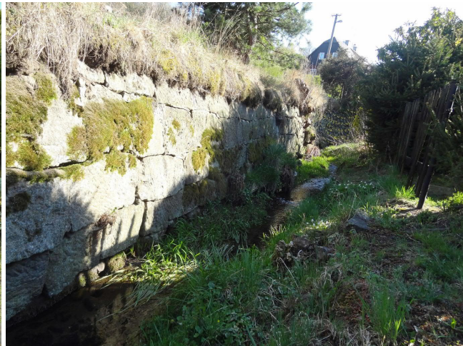
pohled proti proudu: zeď ze žulových kvádrů na PB, nad její korunou silnice III/2656, LB u č.p. 153 svahovaný
