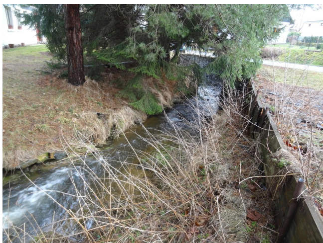
pohled proti proudu v blízkosti konce úpravy: na PB za korunou nábr. zdi dřevěné bednění a kamenný „zához“, LB téměř neopevněný s jehličnatými stromy
