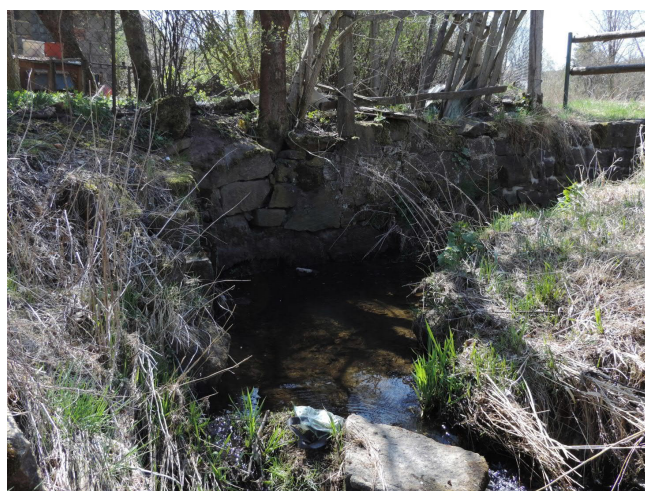
pohled proti proudu: poškozený PB (dříve pravděp. kamen. zdivo nasucho), vlevo v pozadí roh garáže č.p. 62, vpravo v pozadí lávka č. 1
