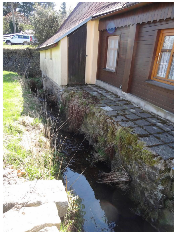
pohled po proudu: v popředí zděná terasa, dále přístavba č.p. 123 na konzole a pilířích, v pozadí opěrná čedičová zeď pod silnicí III/2656
