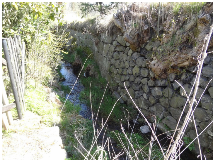
pohled po proudu: vpravo opěrná zeď z čedičových sloupců ve vrcholu oblouku pod silnicí, dále po proudu opěrná zeď ze žulových kvádrů, LB svahovaný, oplocení p.č. 2202
