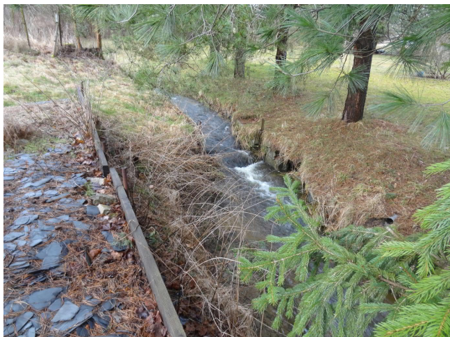
pohled proti proudu v blízkosti konce úpravy: na PB za korunou nábr. zdi dřevěné bednění a kamenný „zához“, LB téměř neopevněný s jehličnatými stromy
