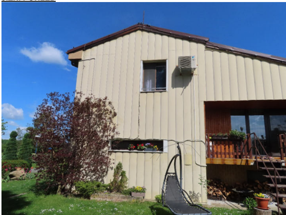
OBR. 4) TECHNICKÁ MÍSTNOST - JIŽNÍ POHLED
