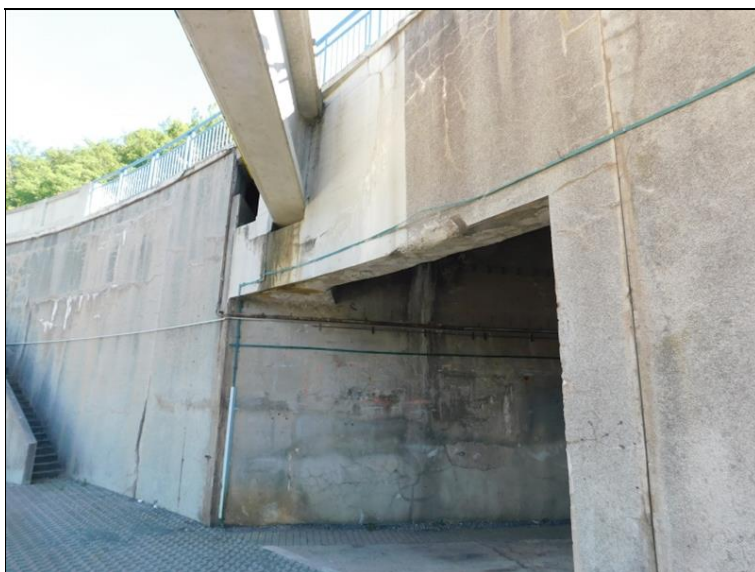
Pole 1 - pravá strana
