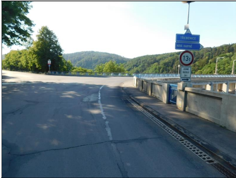
Vjezd na most ve směru staničení
