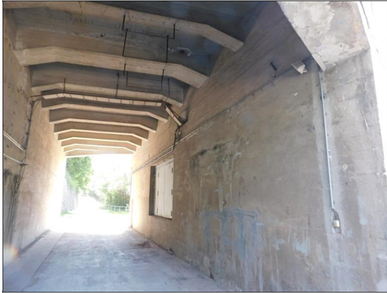
Pole 1 - spodní líc nosné konstrukce
