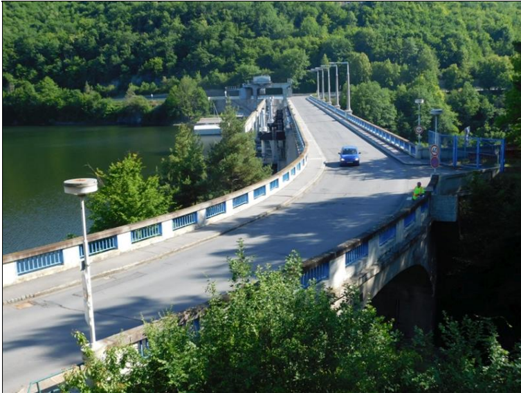
Pohled na mostní svršek z pravého břehu
