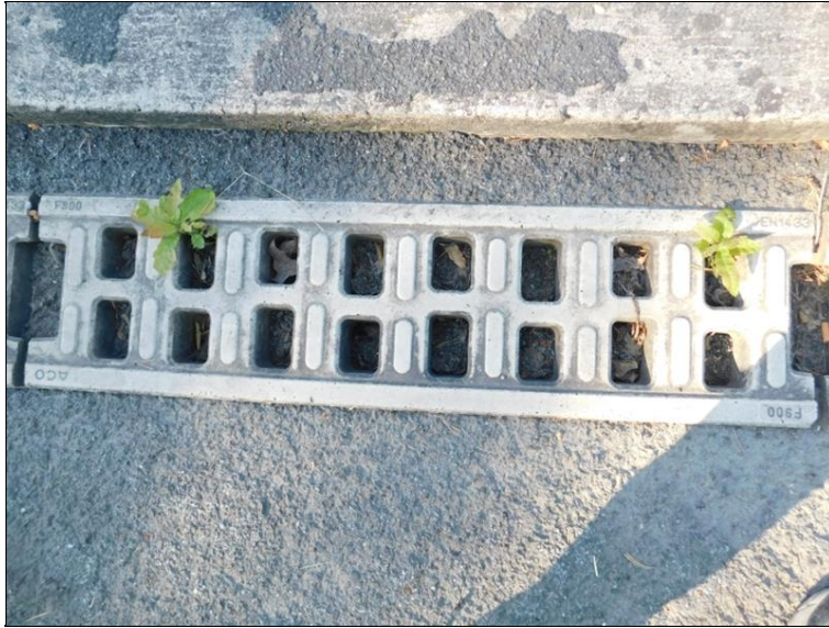
Zanesené odvodňovací žlab na kraji vozovky na předmostí u opěry OP1
