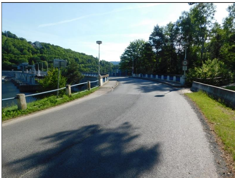
Pohled na most proti směru staničení
